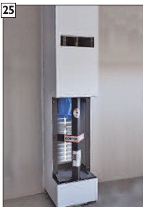
Pohľad na hotový Schiedel KINGFIRE GRANDE bez vnútornej vykurovacej krbovej vložky
