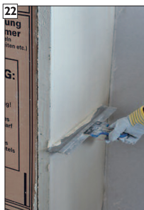
22 Ak je to potrebné, povrch opätovne vyrovnajte stierkou.
