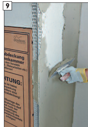
9 Naneste prvú vrstvu - podkladovú - maximálna hrúbka nanášania 5mm.
