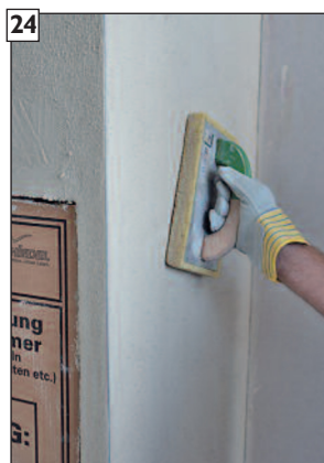
Ak je to potrebné, povrch následne opracujte filcom
