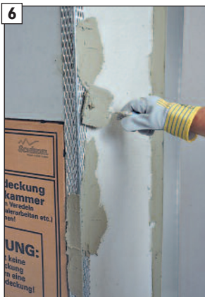
6 Osadte rohové profily a vyrovnajte podkladovou základnou vrstvou „maxit multi 280“.
