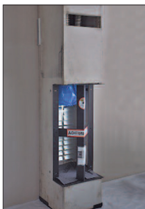
Pohľad pred začiatkom montáže - príklad obkladu na KINGFIRE GRANDE S
