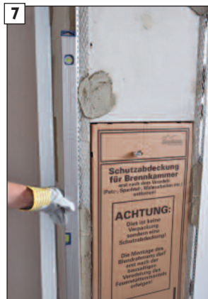
7 Rohové profily zarovnajte zvisle.
