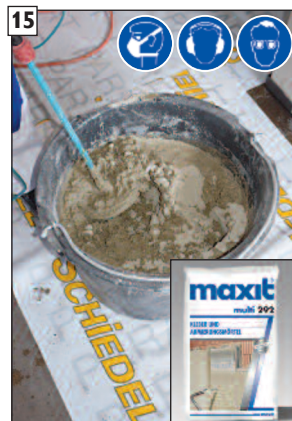
15 Lepiaci podklad "Maxit multi 280" podľa miešajte podľa špecifikácií výrobcu.
