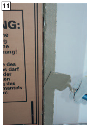
11 Na okraje otvoru pre krb naneste tiež podkladovú základnú vrstvu...
