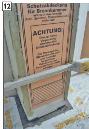
12 ... S vodováhou stiahnite prebytočné množstvo a ...
