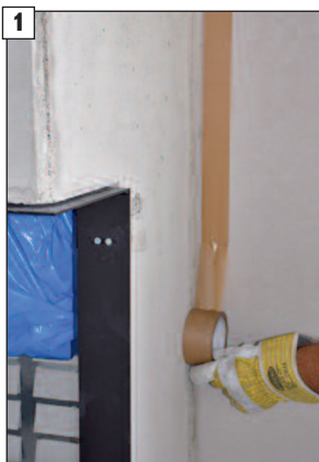
Na susednú ľahkú stenu naneste oddeľovaciu pásku.
