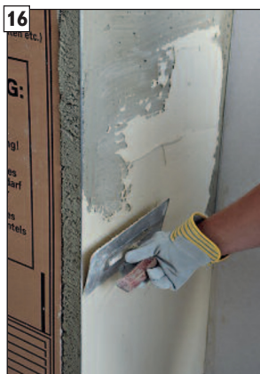
16 Aplikácia vrchnej vrstvy a ...
