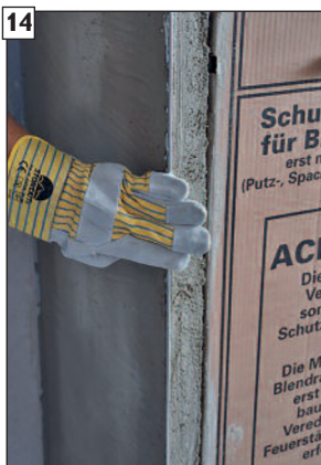
14 Očistite rohovník, kým je ešte zmes vlhká.
