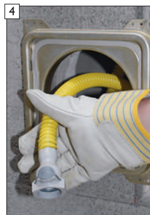
4 Nasuňte spojovaciu časť vrečka na zber kondenzátu na 3/4" hadicu sifónu.
