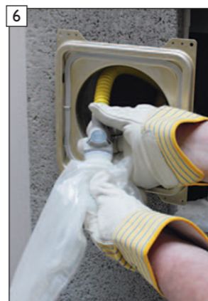
6 Pripojte vrecko na zachytávanie kondenzátu k spojovacej časti.
