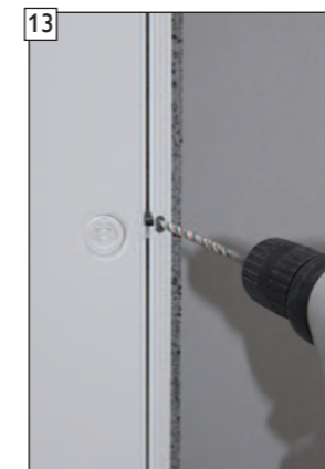
13 Až teraz, v druhom kroku, pripravte dva centrálné vyvrtané otvory.
