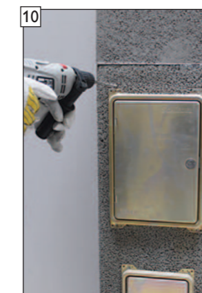
10 Najprv predvrtajte iba dva horné a spodné montážne otvory.
