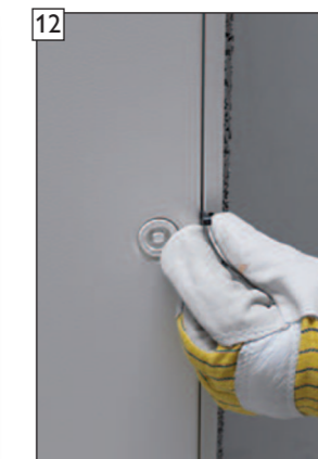
12 Pomocou dvoch plastových klinov (C) zaistíte požadovanú medzeru dverí medzi rámom a krídlom dverí vľavo a vpravo na vŕtanie.
