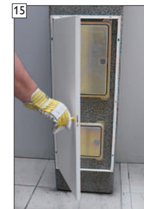
15 Odstráňte plastové kliny a vykonajte kontrolu funkčnosti dverí.
