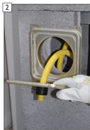
2 Odstráňte krycí panel BlowerDoor a vyťahnite adaptér pre pripojenie HT potrubia DN40 so sifónovou hadicou.
