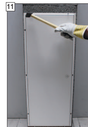
11 Vložte zatlákanie kotvy do dvoch horných a spodných upevňovacích otvorov a a zarazte ich do päty.
