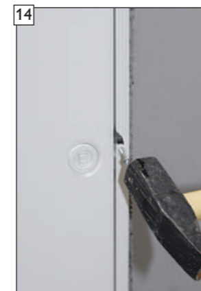
14 Vložte a zatlačte hmoždinku. POZOR! Dávajte pozor, aby ste nepoškodili lak.
