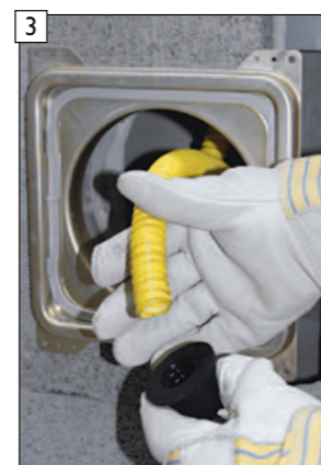
3 Zo sifónovej hadice odskrutkujte adaptér pre prípojku HT potrubia DN 40.
