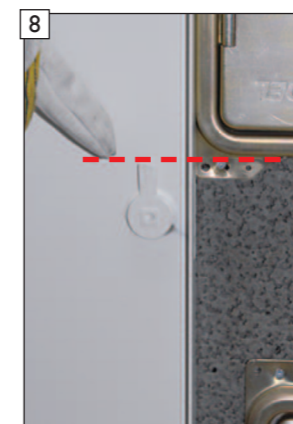
8 Dôležité! Blokovacia páčka v krídle dverí nesmie byť umiestnená príliš vysoko, aby nenarážala na omietkový rám.
