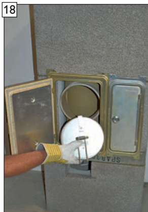
18 Vložte uzáver dvierkového kusu. (Ilustrácia na príklade kontrolného uzáveru „F“ na tuhé palivá)
