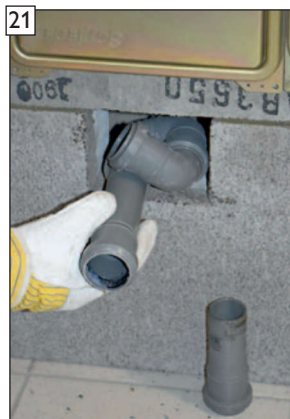
21 Zaskrutkujte časť sifónu HT a pripojte ju k pripojeniu adaptéra PA tvarovky.
