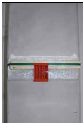
Pohľad na prepravný ochranný obal pred zahájením montáže.
