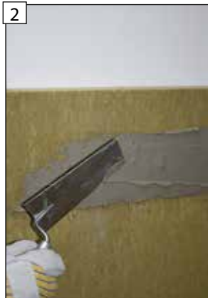
2 Špeciálna KINGFIRE izolačná sada bočnej steny sa môže voliteľne na vnútornú stenu alebo priečku nalepiť alebo alternatívne...
