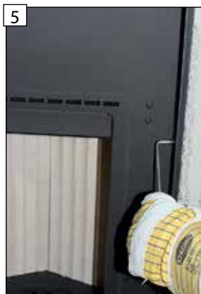
Krycí rám po priložení na obklad realizovaný na stavbe dotiahnutím skrutiek pevne zafixujte.
