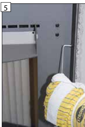
S použitím inbus kľúča plne vyskrutkujte všetky upevňovacie skrutky na ráme ohniska.
