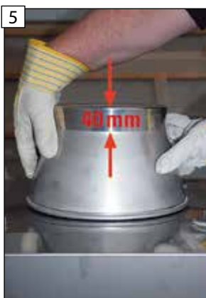
5 Kónus osadte tak, aby medzi doskou a kónusom zostala medzera ca. 2 - 3 mm!
