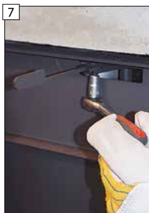
Skrutkou ovládanie pevne skrutkou zafixujte
