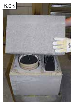
Osadte tvárnicu Schiedel ABSOLUT.
