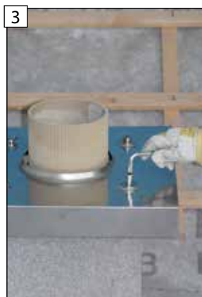
3 Inbusové skrutky pevne dotiahnite
