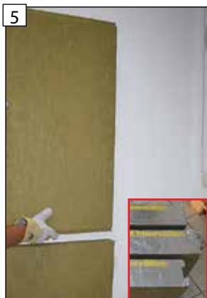
5 Do dosky s drážkou osadíte dosku s dvojitém perom a ďalej...
