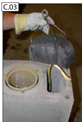
Vytiahnite vrchný diel (3) pre prívod vzduchu zo šachty.
