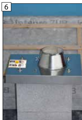
6 Pohľad na prvok dosky po ukončení montáže.
