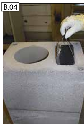
S každou ďalšou osadenou tvárnicom je teraz NEVYHNUTNÉ povytiahnuť vrchný diel pre vzduch(4) ešte pred nanesením tenkovrstvej malty.
