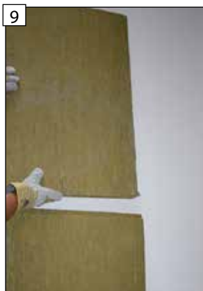
9 Hornú dosku s drážkou osadíte do dosky s dvojitém perom.
