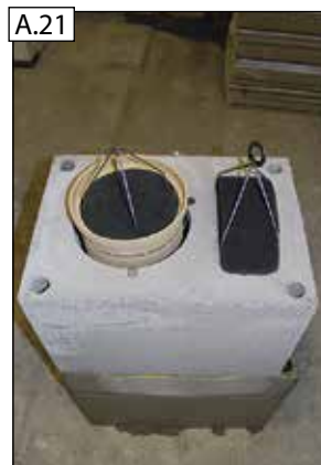
Pohľad na montážne miesto po ukončení krokov zabudovania montážneho setu.
