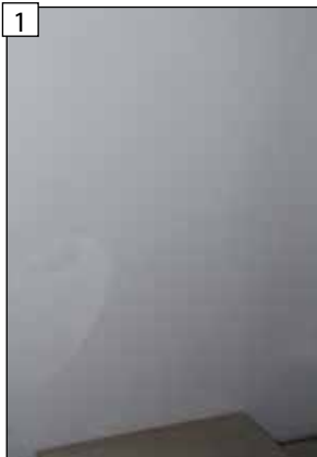
1 Pohľad na stav pred zahájením montáže.
