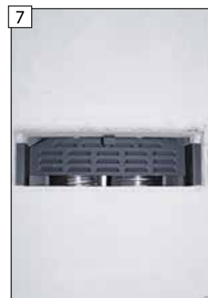
7 Pohľad na hotový stav.
