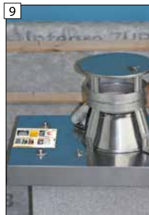
9 Použite podložky a dotiahnite krídlové matice pre uchytenie krycej hlavy.
