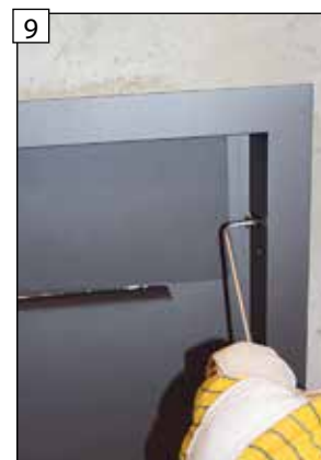
Krycí rám po priložení na obklad realizovaný na stavbe dotiahnutím skrutiek pevne zafixujte.
