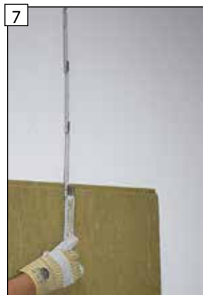
7 Stanovte rozdielový rozmer k stropu na strane stavby.
