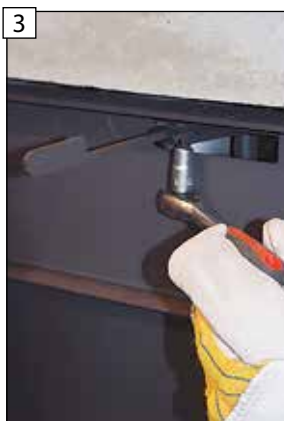
3 Skrutku pevne dotiahnite
