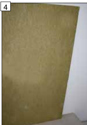
4 Dolnú dosku s drážkou špeciálnej KINGFIRE izolačnej sady bočnej steny upevnite na vnútornú stenu.
