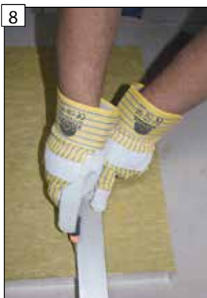
8 Hornú dosku s drážkou odpovedajúcim spôsobom skráťte. POZOR! Dbajte na rovno vedený rez!
