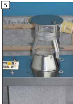
5 Silikónové tesnenia položte na dosku a následne umiestnite kryciu striešku na kryciu dosku tak, aby ste ju mohli uchytiť skrutkami.
