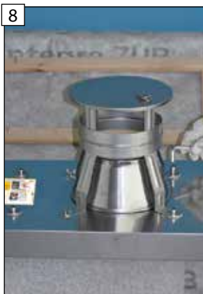
8 Dotiahnite skrutky pre pevné uchytenie krycej hlavy „EAGLE“
