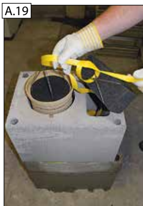
Vnútrotný koniec z rolky lanka pevne zviažte dvojitým uzlom so spodnou časťou vrchného dielu pre spaliny (4).
