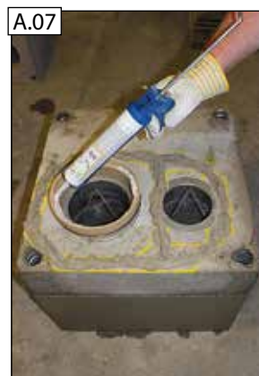
A.07 RAPID-tmel (7) naneste na adaptér (12).
