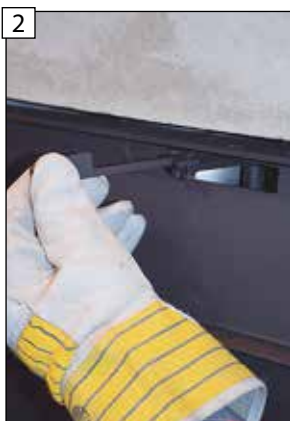
2 Osadíte ovládanie na prívod vzduchu do zodpovedajúceho prvku.
