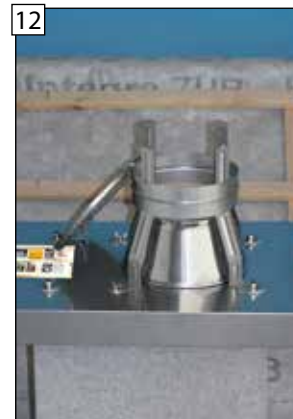
12 Prekrytie je proti pádu a strate zabezpečené oceľovým lankom.
