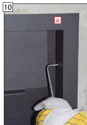
Predĺžovací krycí rám (A) následne pevne zafixujte.
