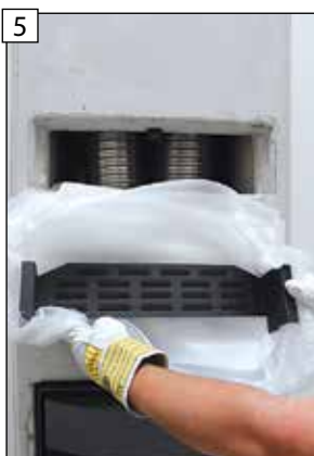
5 Vybalte pohľadovú clonu. DÔLEŽITÉ UPOZORNENIE! Dávajte pozor, aby nedošlo k poškodeniu povrchu pohľadovej clony alebo lakovaných plôch!
