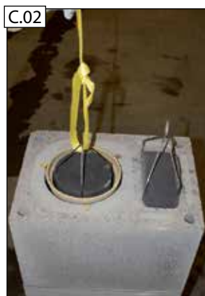
S lankom vytiahnite spodnú časť pre spaliny (1) von z priechodu.
