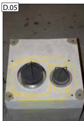
Zasuňte spodný diel pre prívod vzduchu (2).
