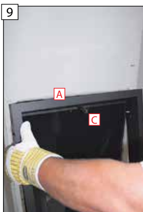
Krycí rám (A) pod uhlom osadte ponad ovládanie (C) prívodu vzduchu a následne upravte zvyšné strany rámu.
