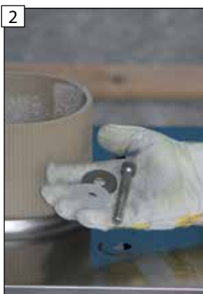
2 Postup montáže: 1. Silikónové tesnenie. 2. Podložka z nehrdzavejúcej ocele 3. Inbusové skrutky z nehrdzavejúcej ocele - M12
