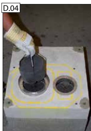
Zasuňte spodný diel pre spaliny (1).
