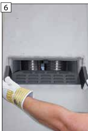
6 Pohľadovú clonu nastavte do šikmej polohy a vsuňte ju do otvoru konvekčného vzduchu. Potom ju posuňte smerom dole až k dorazu.
