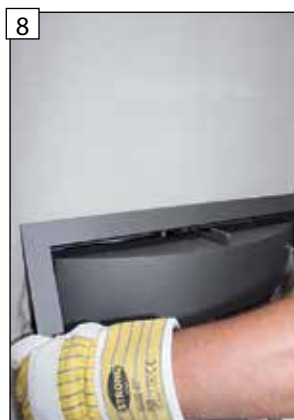
Krycí rám najskôr pod sklom založte za ovládanie prívodu vzduchu a umiestnite ho na požadovanú mieru.
