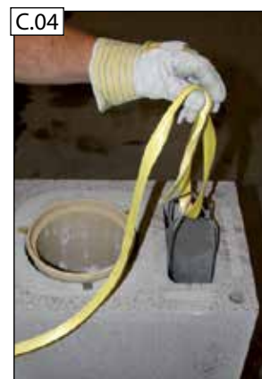
S lankom vytiahnite spodnú časť pre rívod vzduchu (2) von zo šachty.
