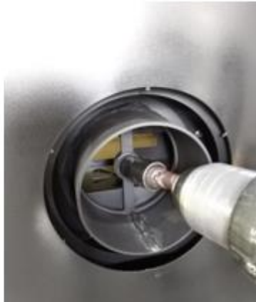
Mocowanie dyszy przyłącza powietrza za pomocą śruby M8
