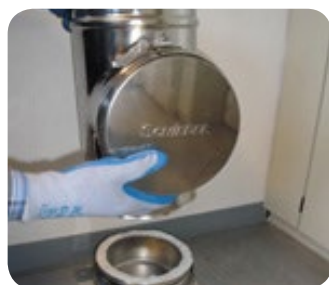
1. Uzmontēt tīrīšanas trejgabalu uz pamatelementa.
