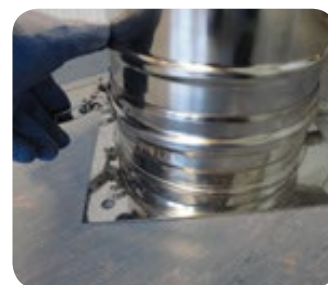
3. Uz savienojuma uzlikt skavu, aizsprādzēt un pievilkt.
