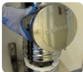
1. Uzmontēt tīrīšanas trejgabalu uz konsoles.
