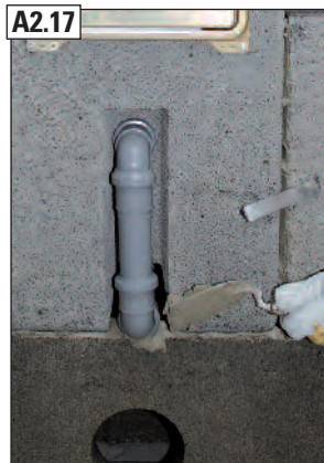
Piemērs ar kondensāta novadišanu uz leju (Ø40).
