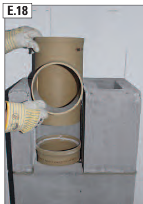
E.18 Blokā iemontēt pieslēguma trejgabalu. L - 33cm līdz Ø20 L - 66cm no Ø25
