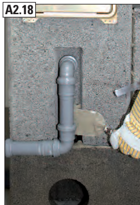
Piemērs ar kondensāta novadišanu uz sāniem (Ø40).
