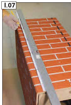
Uz apdares atzīmējiet A izmēru ar pieplusotu augšējās plaknes biezumu. Atzīmi veiciet pareizajā (garajā) pusē.
