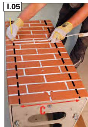
Iecentrējiet un atzīmējiet uz apdares dūmvada platumu C.
