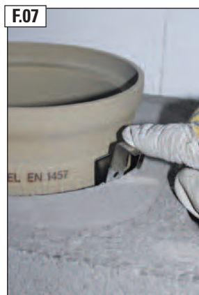
Cauruli iecentrēt ar distanceriem (3gb.) tos izvietojot vienādā attālumā ap cauruli un iespiežot izolācijā.
