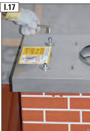
Uzlikt noseiplāksni, paplāksnes un pieskrūvēt skrūves.
