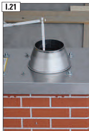
...Nomērīt pēdējās keramiskās caurules garumu no cauruļu savienojuma līdz konusa augšai.
