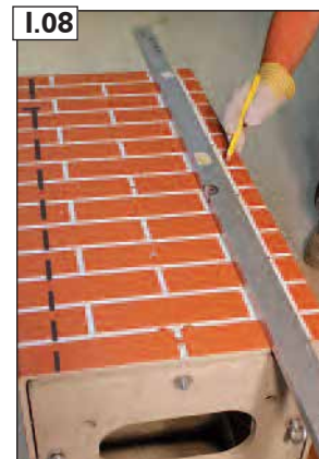
Uz apdares atzīmējiet B izmēru ar pieplusotu augšējās plaknes biezumu. Atzīmi veiciet pareizajā (īsajā) pusē.
