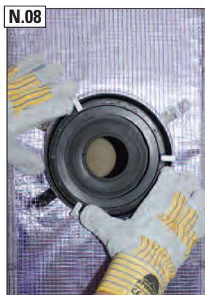
Uz ārējā (gaisa pieplūdes) adaptera uzklāt smērvielu un adapteri iemontēt apmetuma gredzenā līdz atdurēm.
