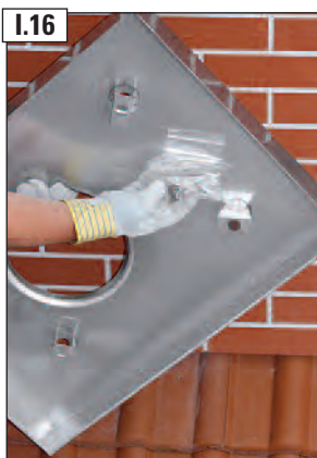
Noņemt stiprinājumu komplektu no gaisa pieplūdes noseiplāksnes apakšas.
