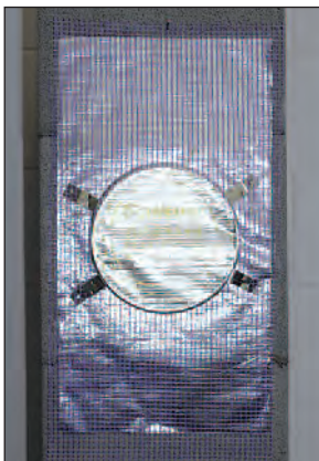
Skats, dūmvada pieslēgumam, pirms montāžas.
