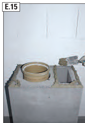
Uzklāt plāno javu (Dūnbbetmörtel) uz bloka.
