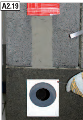
Piestiprināt (BlowerDoor) pieplūdes gaisa pieslēguma pāreju noblīvējot (piem. ar silikonu) pieguļošo virsmu pie dūmvada.
