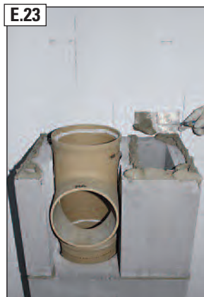
E.23 Uzklāt blokam plāno javu (Dünnbettmörtel).
