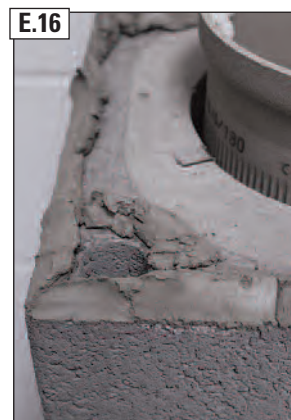
UZMANĪBU: Javu klāt tikai keramzītbetona daļai, īpaši pievērst uzmanību ap armēšanas dobumiem (nekādā gadījumā uz izolācijas).
