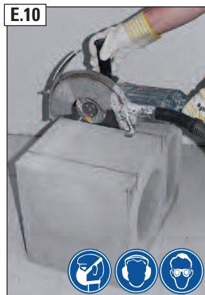
Ar leņķa slīpmašīnu veikt griezumus pa atzīmētajām līnijām. UZMANĪBU: levērot darba drošības instrukciju (skat.2.lpp.)!
