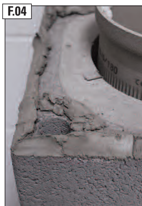
UZMANĪBU: Javu klāt tikai keramzītbetona daļai, īpaši pievērst uzmanību ap armēšanas dobumiem.
