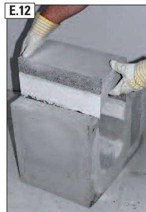
Izņemiet nogriezto bloka daļu. Iztīriet bloku no zāģēšanas atgriezumiem.
