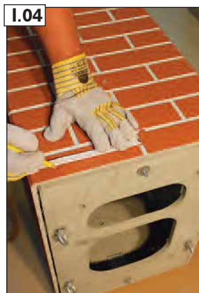
Iecentrējiet un atzīmējiet uz apdares dūmvada platumu C.
