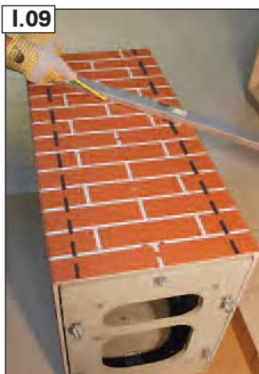
Tagad uz apdares visām plaknēm atzīmējiet griešanas līniju.
