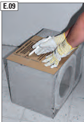
Uz bloka uzlikt atzīmēšanas šablonu un atzīmēt griešanas līnijas.
