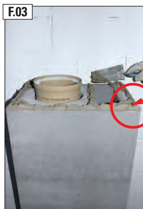
Uzklāt plāno javu (Dünnbettmörtel).
