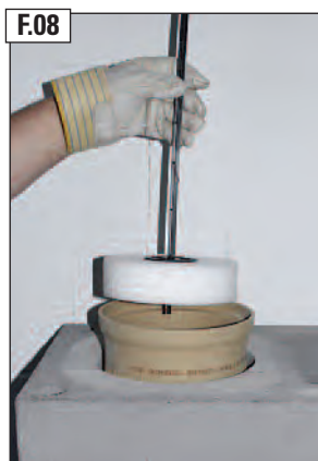
Šuvju izlīdzinātāju iestumt caurulē līdz savienojumam un izlīdzināt izspiedušos ķīti.
