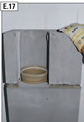
E.17 Uzlikt bloku ar pieslēguma atvērumu to nolīmeņojot.
