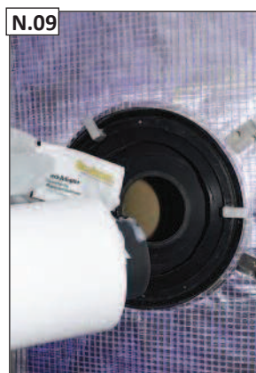
Įcentruotą jungiamąjį vamzdį patepkite lubrikantu ir sumontuokite.
