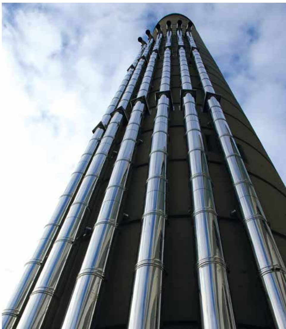
Sistema camino - ICS 5000. Impianto multiplo Struttura ospedaliera, Glasgow, Royal Infirmary
