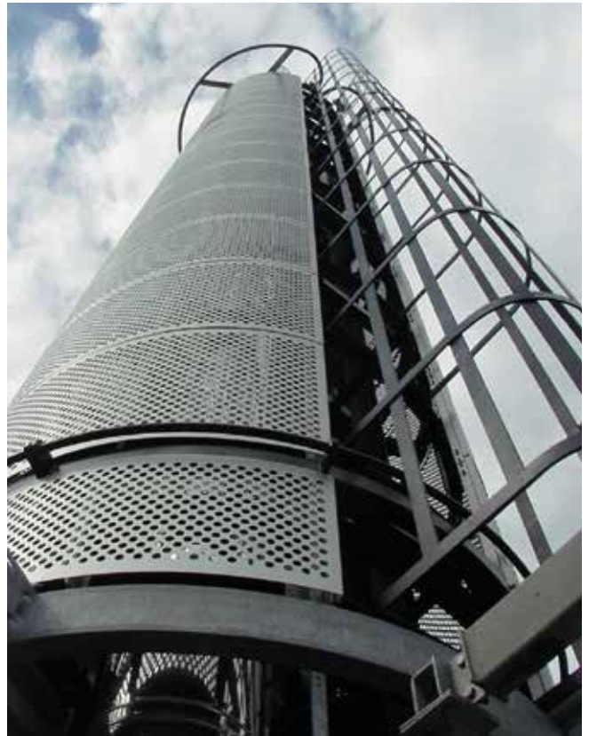
Sistema ICS 5000 Torre BBC, UK
