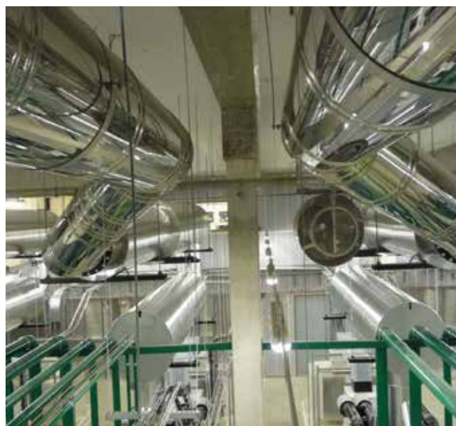
Esempi di applicazioni di canne fumarie e condotti resistenti al fuoco in ambienti compartimentati
