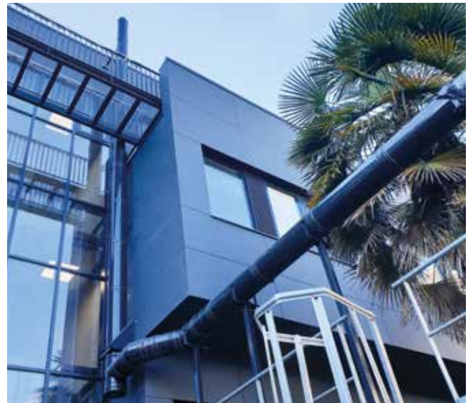
Sistema camino - ICS 5000 isolamento 50 mm Verniciato RAL Impianto asservito generatore diesel Edificio pubblico, Francia
