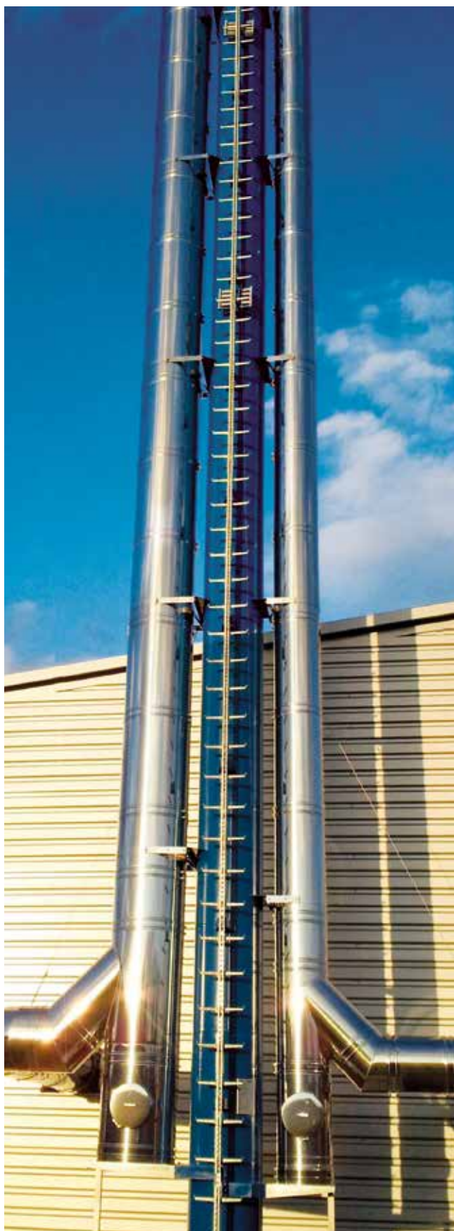
Sistema camino ICS Impianto multiplo con traliccio di supporto Caserma militare, Germania
