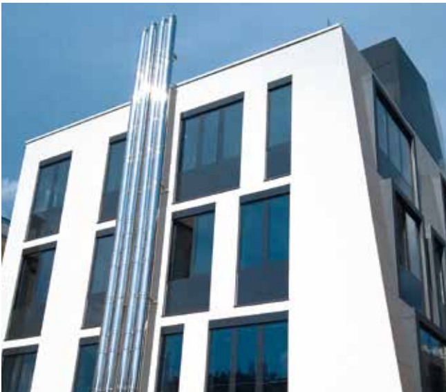
Sistema camino - Super ICS impianto multiplo Edificio direzionale, uffici Croazia
