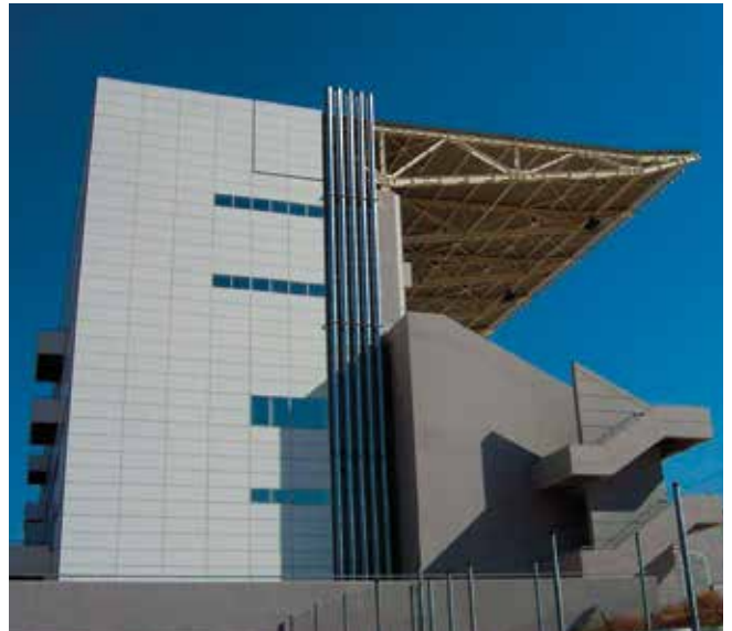
Sistema Super ICS Struttura olimpica, Grecia
