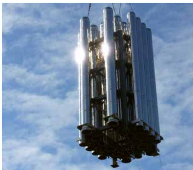
Sistemi camino ICS e ICS 5000 con struttura traliccio prefabbricata Struttura ospedaliera, UK
