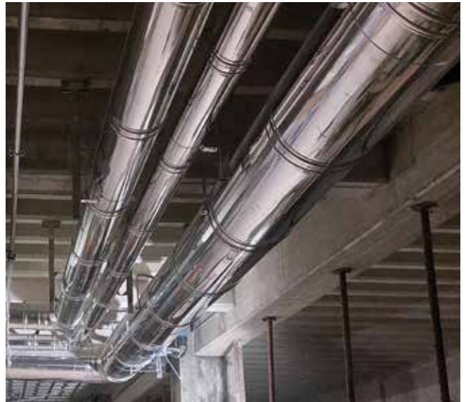
Sistemi Super ICS e ICS 5000. Impianto multiplo per gruppi elettrogeni, motopompe antincendio, cappe cucina, Torre Velasca, Milano
