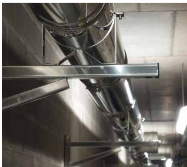
Sistema ICS 5000 gruppo elettrogeno per motopompa antincendio, Citylife, Milano
