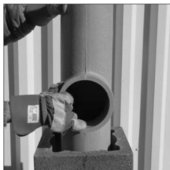
18. A szükséges magasság elérésekor elhelyezzük a füstcső-csatlakozót és köré ásványgyapot zsinórt tekerünk. Felhordjuk a következő habarcsréteget.
