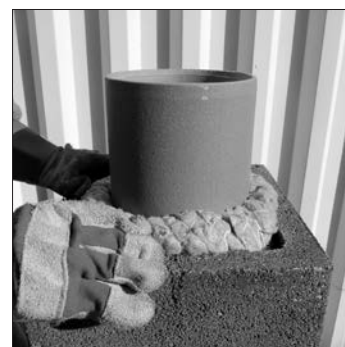
16. Ásványgyapot zsinórt tekerünk a samottcső és a köpenytégla közötti hézagba, majd felhordjuk a következő habarcsréteget.
