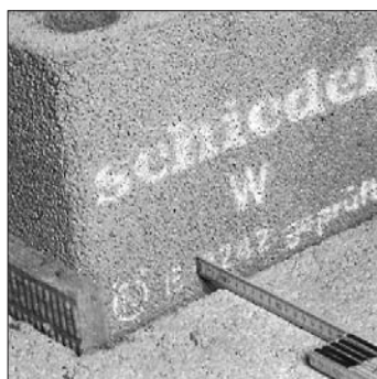
23. A födémáttörésnek minden oldalon 3 cm-rel nagyobbak kell lennie, mint a köpenytégla külső mérete. A hézagot nem éghető szigetelőanyaggal kell kitölteni.
