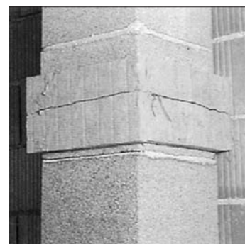
24. A födém utólagos betonozásánál a kéményre minden oldalról nem éghető, legalább 3 cm vastag szigetelőanyagot kell elhelyezni.
