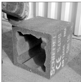
19. A következő köpenytéglát kivágjuk, majd habarcsot hordunk fel a permére.
