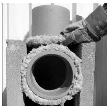
21. Elhelyezzük a köpenytéglát, majd a samottcső és a füstcső-csatlakozó köré ásványgyapot zsinórt tekerünk.
