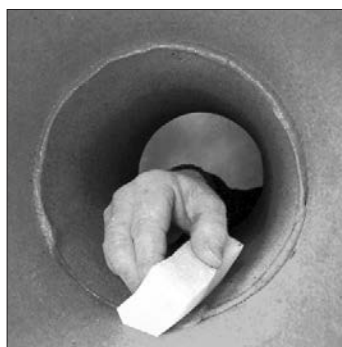
15. A kinyomódott hézagkittet lesimítjuk.
