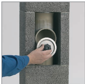
6.1 Helyezzük fel a vizsgálónyílás fedelét.
