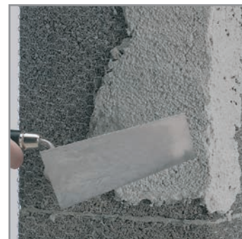
6.4 A vakolat gondos felhordásával előzzük meg a kapcsolódó falak melletti vakolatrepedéseket.
