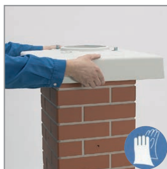
8.3 A fedlapot habarcságyba ültessük.
