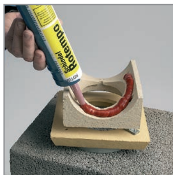
4.7 A csatlakozóra Rotempo-t hordunk fel és felragasztjuk.
