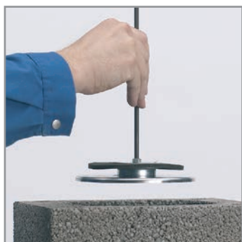
5.5 A védősapkát a mágnes segítségével levesszük a csőről.
