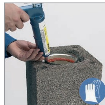
5.8 ROTEMPO-t nyomunk vastagon a profilcső peremére, felhelyezzük a védősapkát. Ezt az építési folyamatot a kéménytorolatig folytatjuk.
