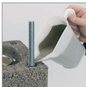
8.2 A sarokfuratokba a megkevert kiöntő habarcsot öntsük bele. Ügyeljünk arra, hogy a vas kiöntés után is központosan helyezkedjen el lyukban.
