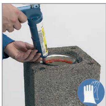
5.1 Schiedel ROTEMPO-val alaposan bekenjük a profil samottcső peremét. Előtte a samottcsövek csővégeit pormentesítsük. A hézagtömítő masszát mindig a profilcső felső végére (tömítő-központosító gyűrűs vég) kell felhordani.
