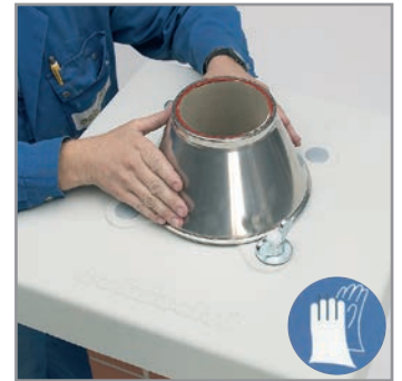
8.8 A torkolati kúpot helyezzük rá szintbe állítva. A kitüremkedő masszát a hézaglehetővé húzzuk le.
