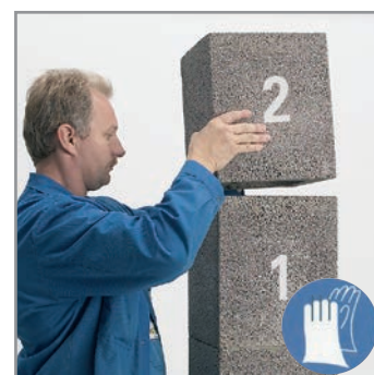
5.4 Felhelyezzünk a következő két darab köpenytéglát.
