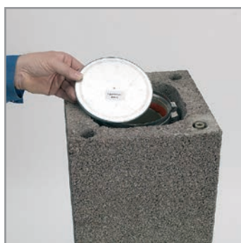
5.2 A védősapkát felhelyezzük a csőre.
