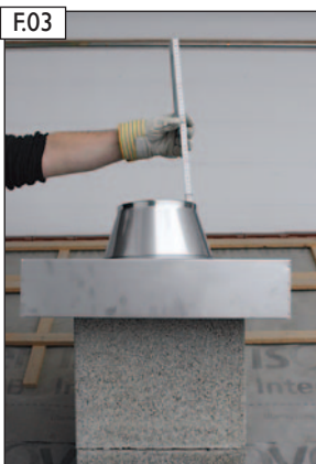
Zuluftkopfplatte und Abströmkonus lose auflegen und Zuschnittlänge für Abschluss-Profilrohr (ohne Dämmschale) ermitteln.
