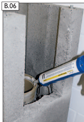
B.06 RAPID-fugendicht satt auftragen.
