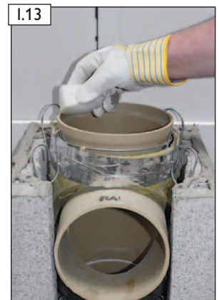
I.13 Steckverbindung säubern.
