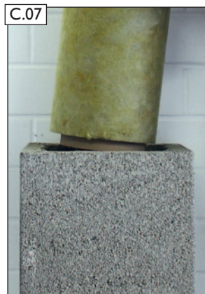
Profilrohr (66 cm) einsetzen.
