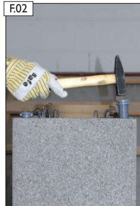
HEB-Spezialdübel in die Bewehrungskanäle des Mantelsteins einschlagen.
