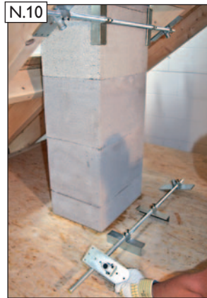
N.10 Zweiten Schornsteinhalter vorbereiten. Spannwinkel und Sparrenhalter lose auf die Gewindestange auf-fädeln.
