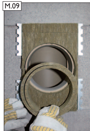
M.09 Bei D 12-18 die nicht erforderlichen Innenkernringe vor dem Einsetzen herausnehmen.
