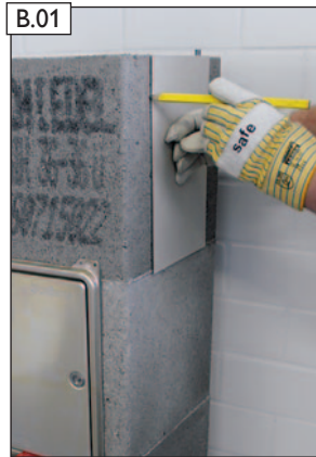
B.01 RA-Schnittsablone anlegen, Mantelsteinöffnung anzeichnen.
