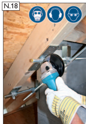
N.18 Bei Bedarf überstehende Gewindestangen an den Lagerbuchsen kürzen. ACHTUNG! Beachten Sie bitte die Hinweise zum Arbeitsschutz auf Seite 2!
