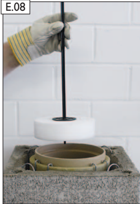
RAPID-Fugendichtreste mit Fugenglätter abstreifen.
