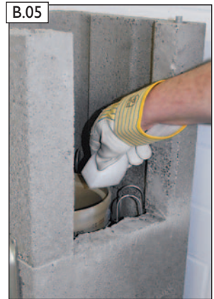
B.05 Steckverbindung säubern.
