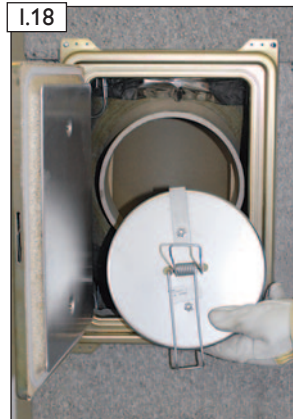
Revisionsverschluss „F“ für Festbrennstoffbelegung einsetzen.
