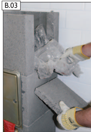
B.03 Bauseitige Schutzabdeckung entfernen.
