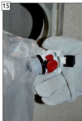
15 Verriegelung des BIB-Connectors öffnen und BIB-Anschlusshahn mit dem Kondensatauffangbeutel aus dem Kuppungsteil herausziehen.
