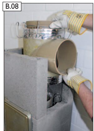
B.08 Rauchrohranschluss (RA) einsetzen.
