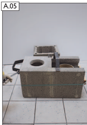
A.05 Tragegriffe entfernen.
