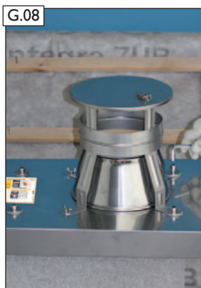
Regenhaube „EAGLE“ mit der Zuluftkopfplatte-Edelstahl verschrauben.
