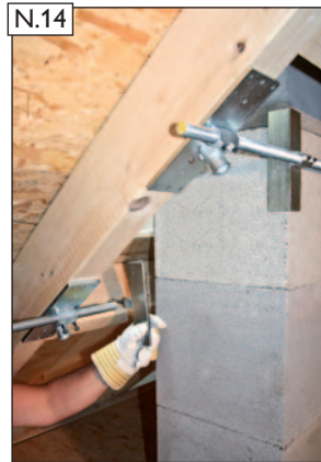
N.14 Gewindestange und Spannwinkel wieder ein-fädeln und ausrichten.
