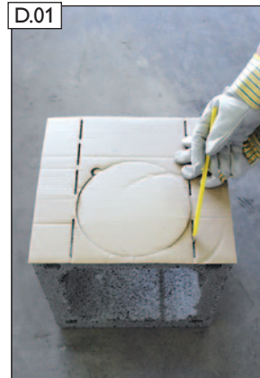
RA-Schnittschablone außen anlegen, Mantelsteinöffnung anzeichnen.
