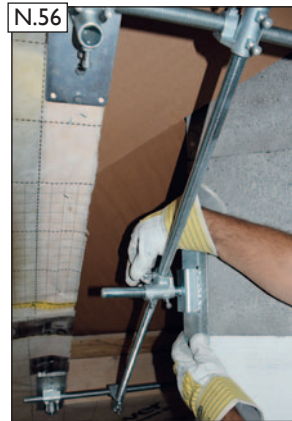
N.56 Spannwinkel ausrichten und vorfixieren.
