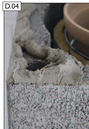
ACHTUNG! Auf geschlossenen Stegbereich achten!
