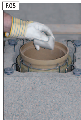
Steckverbindung säubern.
