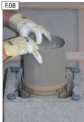
F08 Abschluss-Profilrohr (ohne Dämmschale) versetzen.
