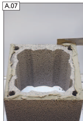
A.07 Mörtel MG(M5) IIa (Mauermörtel nach EN 998-2) auf ersten Mantelstein auftragen.
