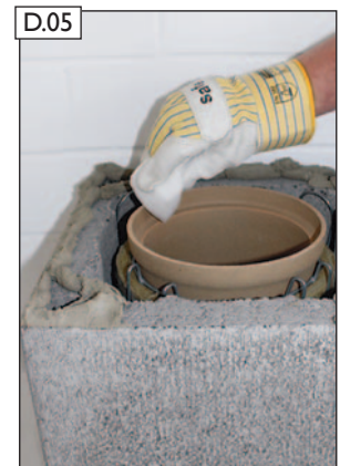
Steckverbindung säubern.
