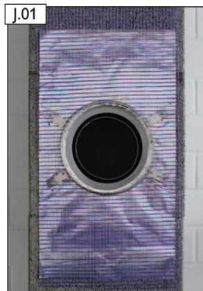
Ansicht Feuerstättenanschluss mit eingebautem Schiedel Edelstahl-Anschlussfutter:
