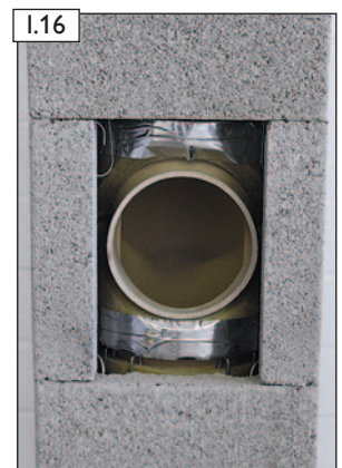
I.16 Ansicht vor dem Anbringen der Putztür.
