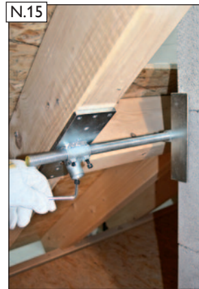
N.15 Gewindestange fixieren. Dazu die Abreißschrauben an beiden Sparrenhaltern mit Inbusschlüssel (E) anziehen bis der Schraubkopf an der Sollbruchstelle abreißt. Erst danach Spannwinkel fixieren (siehe Bild N.09).
