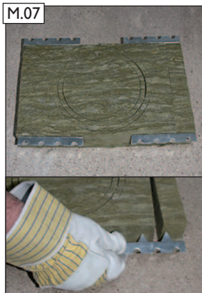
M.07 Haltewinkel in die BDF einstecken. Mit den oberen Haltewinkeln den angelegten BDF-Abschnitt fixieren.
