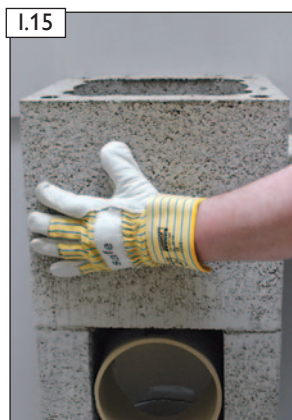
I.15 Weiteren Mantelstein versetzen.
