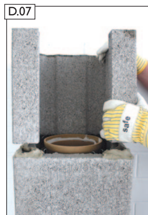
RA-Öffnungsstein versetzen.
