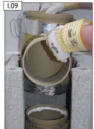
I.09 PA-Formstück einsetzen.
