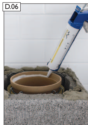
RAPID-fugendicht satt auftragen.
