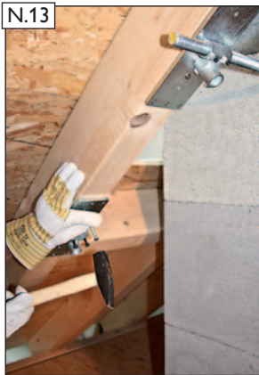
N.13 Sparrenhalter mit Kamm-nägeln (D) ausnageln.
