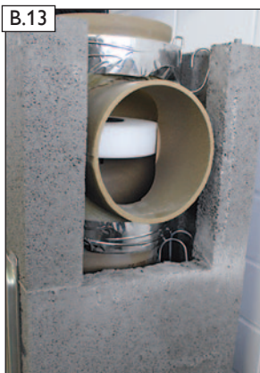
B.13 RAPID-Fugendichtreste mit Fugenglätter abstreifen.
