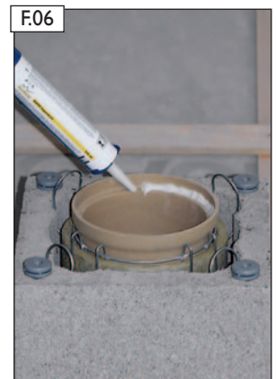
RAPID-fugendicht satt auftragen.
