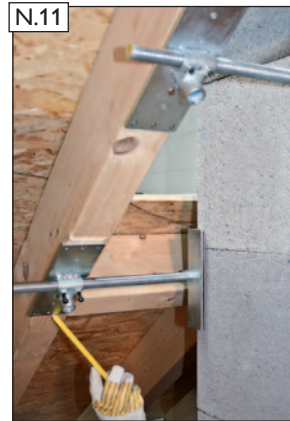
N.11 Aufgefädelt Einzelteile zum einrichten anhalten. Einbauposition für den Sparrenhalter markieren. Danach Einzelteile aus-fädeln.
