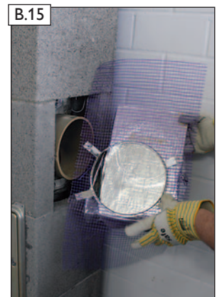
Abschlussarbeit: Einbau BlowerDoor Frontplatte (Einbauanleitung siehe Kapitel M, Seite 37)
