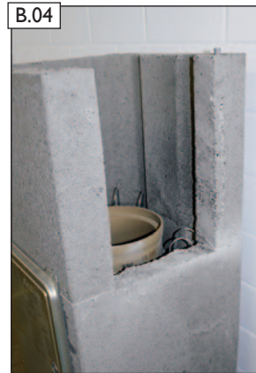
B.04 Fertigfuß von allen Bauschuttresten säubern.
