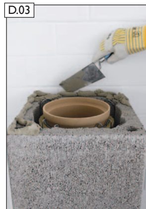
Mörtel MG(M5) IIa (Mauermörtel nach EN 998-2) auftragen.
