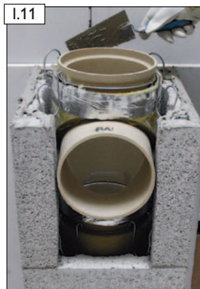
I.11 Mörtel MG(M5) IIa (Mauermörtel nach EN 998-2) auftragen.
