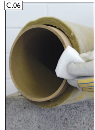
Unterseite Profilrohr säubern.
