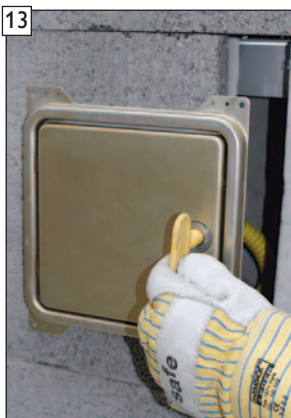
13 BlowerDoor Kondensatblendentürblatt abnehmen.
