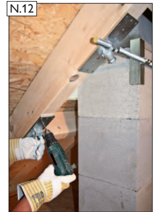
N.12 Sparrenhalter anhalten und Nagellöcher gemäß dem Nagelbild (siehe oben) vorbohren.
