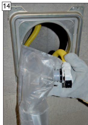
14 Kondensatauffangbeutel vorsichtig herausziehen.
