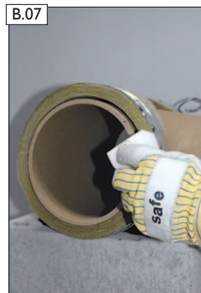
B.07 Unterseite Rauchrohranschluss säubern.
