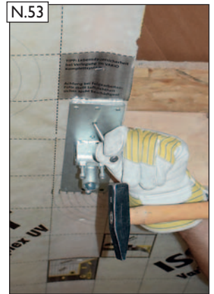
N.53 Sparrenhalter mit Kamm-nägeln (E) ausnageln.
