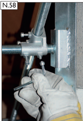
N.58 Spannwinkel an den Schornstein drücken. Ab-reißschrauben anziehen bis der Schraubkopf an der Sollbruchstelle abreißt.
