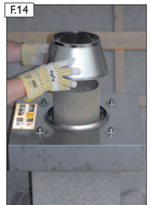
F14 Konus aufstecken. WICHTIG! Oberkante Konus muss auf dem Keramikrohr aufliegen!
