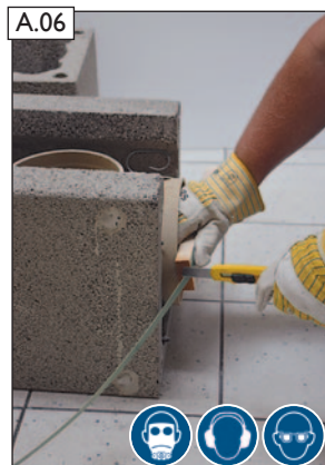
A.06 Sicherungsbänder entfernen. ACHTUNG! Beachten Sie bitte die Hinweise zum Arbeitsschutz auf Seite 2!
