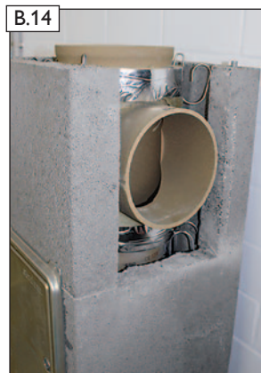
B.14 Fertigansicht - weiter mit Punkt C.01 auf Seite 18 (Aufbau nach Fertigfuß).
