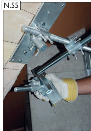
N.55 Gewindestange in Spann-kreuze des oberen und un-teren Schornsteinhalters einfädeln und dabei das Spannkreuz mit dem 45° Spannwinkel mit auffädeln.
