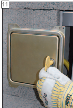
11 Kondensatblendentürblatt wieder verschließen.
