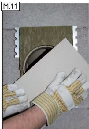
M.11 ... mit Hilfe der Schnittschablone (als Einschubhilfe) bündig zum Mantelstein einsetzen.
