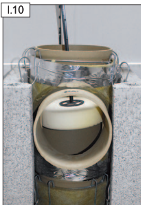
I.10 RAPID-Fugendichtreste mit Fugenglätter abstreifen.
