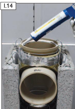
I.14 RAPID-fugendicht satt auftragen.
