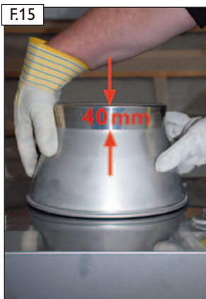
F15 Konus nach unten bis ca. 2-3 mm auf Zuluftkopfplatte aufchieben. (Höhenausgleich bis 40 mm möglich)
