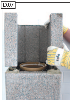
RA-Öffnungsstein versetzen.
