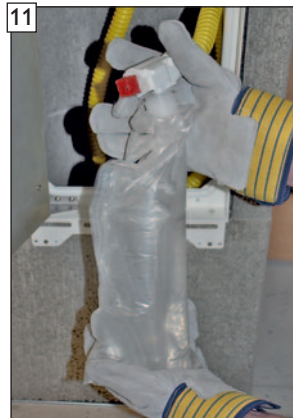
Kondensatauffangbeutel vorsichtig herausziehen.
