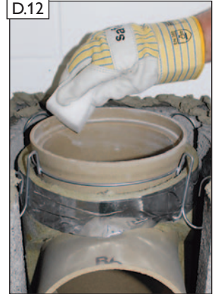
Steckverbindung säubern.
