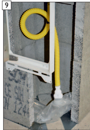
Fertigansicht am Beispiel: Ausführung mit angeschlossenen Kondensatauffangbeutel.
