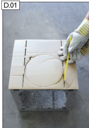
RA-Schnittschablone außen anlegen, Mantelsteinöffnung anzeichnen.
