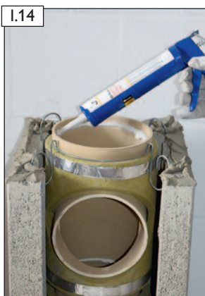
I.14 RAPID-fugendicht satt auftragen.
