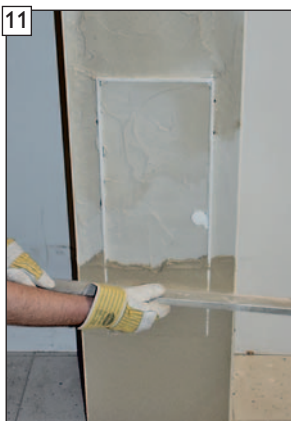
11 Bauseitigen Oberputz auftragen.
