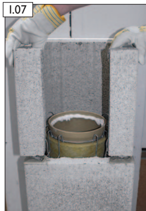
I.07 PA-Formstück versetzen.
