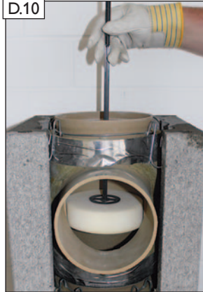
RAPID-Fugendichtreste mit Fugenglätter abstreifen.
