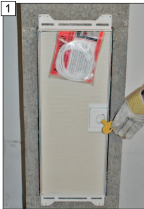
1 Öffnen Sie die BlowerDoor Design Putztür:
