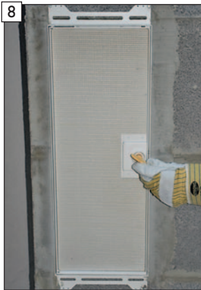
BlowerDoor Design-Putztürblatt wieder verschließen.
