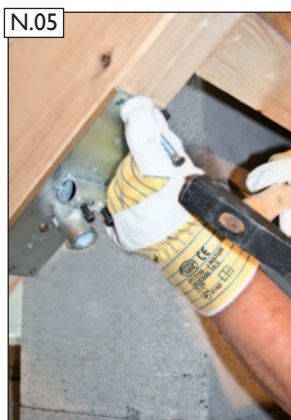
N.05 Sparrenhalter mit Kamm-nägeln (D) ausnageln.
