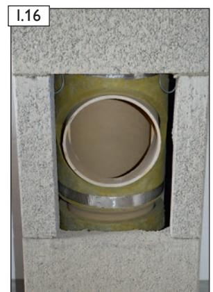
I.16 Ansicht vor dem Anbringen der Putztür.
