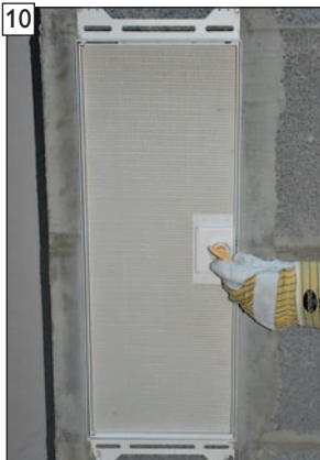
BlowerDoor Design-Putztür öffnen.
