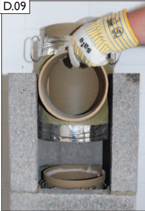
RA-Formstück einsetzen.
