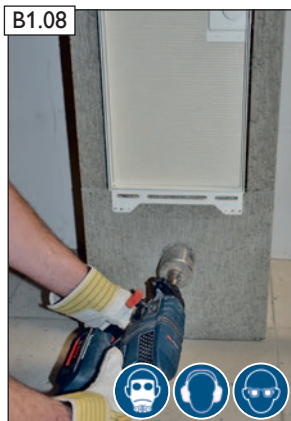
Bauseitige Öffnungsbohrung herstellen.
