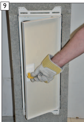
9 Funktionskontrolle (Öffnen und Schließen) durchführen.
