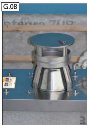
Regenhaube „EAGLE“ mit der Zuluftkopfplatte-Edelstahl verschrauben.
