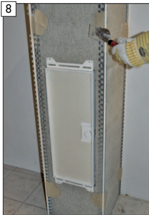
8 Anbringen der bauseitigen Putzschienen.
