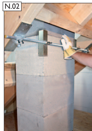
N.02 Aufgefädelte Einzelteile zum einrichten anhalten.
