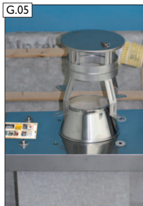
Silikondichtungen auf Zuluftkopfplatte-Edelstahl auflegen. Regenhaube „EAGLE“ aufsetzen.
