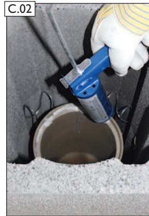
C.02 RAPID-fugendicht satt auftragen.
