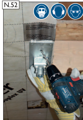
N.52 Sparrenhalter anhalten und Nagellöcher gemäß dem Nagelbild (siehe oben) vorbohren. ACHTUNG! Beachten Sie bitte die Hinweise zum Arbeitsschutz auf Seite 2!
