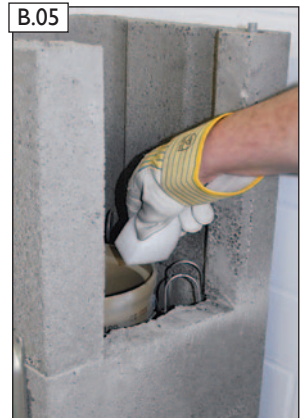
B.05 Steckverbindung säubern.
