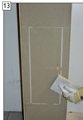
13 ... dabei die Schutzdichtung bündig freireiben.
