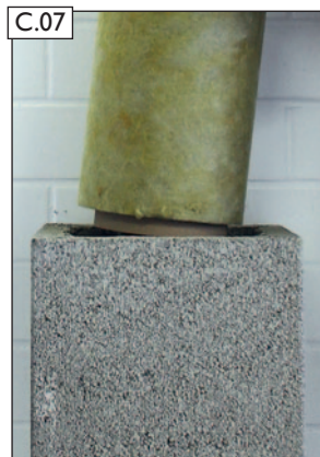
C.07 Profilrohr (66 cm) einsetzen.
