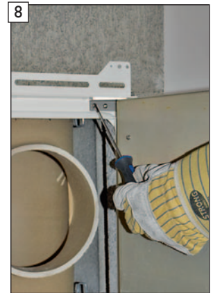
8 Türblatt kann jetzt auf der Gegenseite in umgekehrter Reihenfolge wieder eingebaut werden. ACHTUNG! Umlaufende Innendichtung nicht beschädigen!
