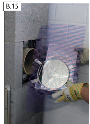
B.15 Abschlussarbeit: Einbau BlowerDoor Frontplatte (Einbauanleitung siehe Kapitel M, Seite 43)
