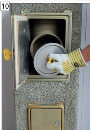
Putztür öffnen und Revisionsverschluss abnehmen. (Bilddarstellung am Beispiel ABSOLUT-Revisionsverschluss „B“)
