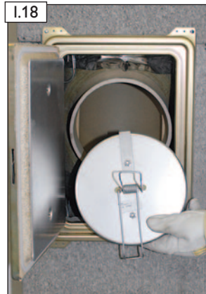
Revisionsverschluss „F“ für Festbrennstoffbelegung einsetzen.
