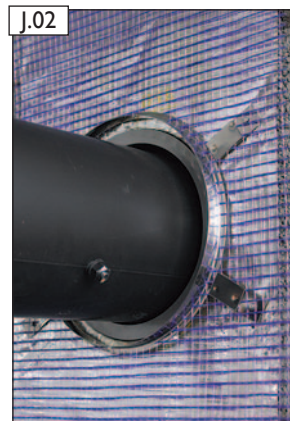
Ansicht Anschlussfutter mit bauseitig eingesteckter Verbindungsleitung.
