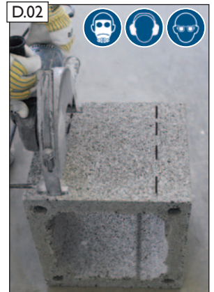
Mit Winkelschleifer Öffnung herstellen. ACHTUNG! Beachten Sie bitte die Hinweise zum Arbeitsschutz auf Seite 2!
