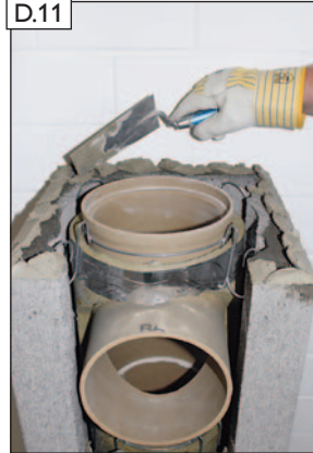
Mörtel MG(M5) Ila (Mauermörtel nach EN 998-2) auftragen.
