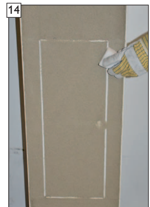
14 Schutzdichtung mit Schwamm nacharbeiten.
