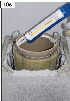
I.06 RAPID-fugendicht satt auftragen.
