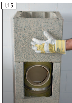
I.15 Weiteren Mantelstein versetzen.
