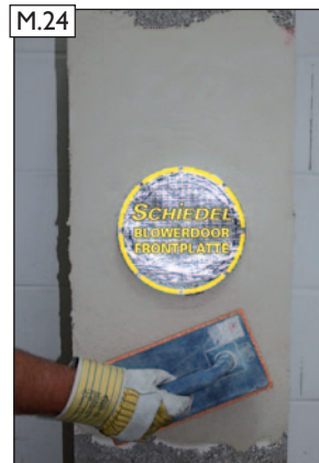
Auftrag und Veredelung Oberputz.
