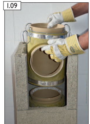
I.09 PA-Formstück einsetzen.
