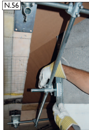
N.56 Spannwinkel ausrichten und vorfixieren.
