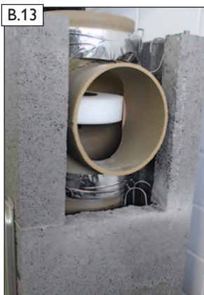
B.13 RAPID-Fugendichtreste mit Fugenglätter abstreifen.
