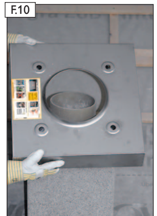
F10 Zuluftkopfplatte-Edelstahl auflegen.
