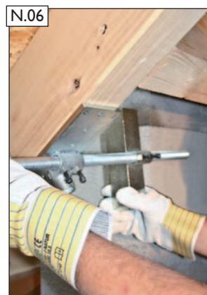
N.06 Gewindestange und Spannwinkel wieder einfädeln.
