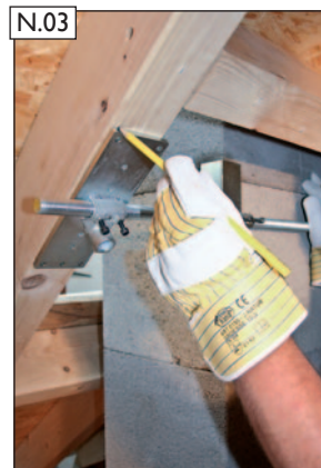
N.03 Einbauposition für den Sparrenhalter markieren. Danach Einzelteile ausfä-deln.
