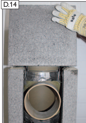
Weiteren Mantelstein versetzen.
