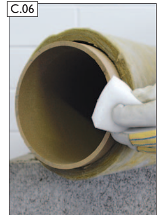
C.06 Unterseite Profilrohr säubern.
