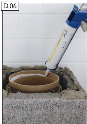
RAPID-fugendicht satt auftragen.
