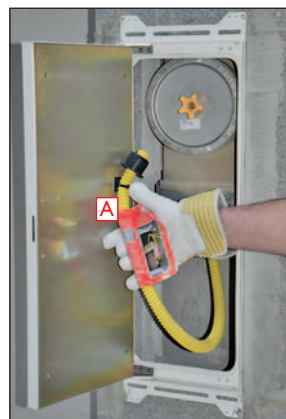
Ableitung (A) zum Abwasserkanal bauseits erstellen.
