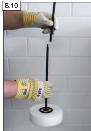
B.10 Mittelstück auf die Aufnahmestange fest einstecken.
