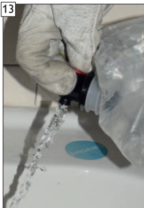
Durch Drücken der Entriegelung (rote Entriegelungstaste) am BIB-Anschlusshahn kann der Kondensatauffangbeutel tropfsicher entleert werden.
