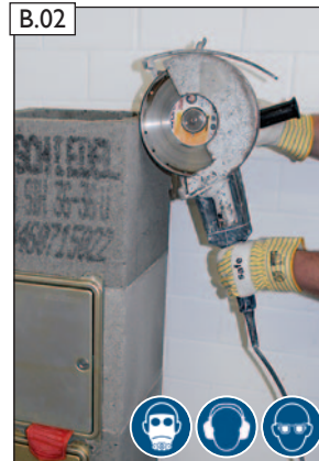
B.02 Mit Winkelschleifer Öffnung herstellen. ACHTUNG! Beachten Sie bitte die Hinweise zum Arbeitsschutz auf Seite 2!
