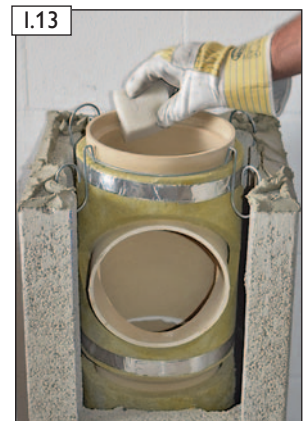
I.13 Steckverbindung säubern.
