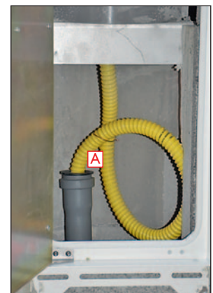
Ableitung (A) zum Abwasserkanal bauseits erstellen.
