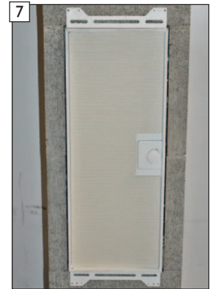
7 Fertigansicht mit vollständig eingebrachter Schutzdichtung.
