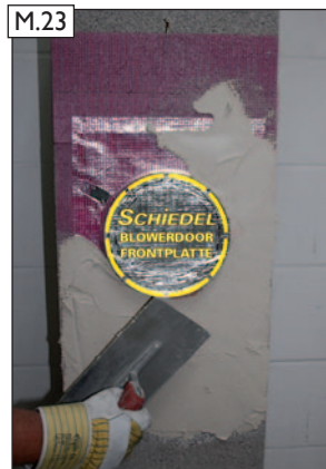
Armierungsputzauftrag frü- hestens nach 48 Std. aus- führen. Trocknungszeit des BlowerDoor A 270 Dicht- heitsklebers ( vor Frost schützen ) beachten!
