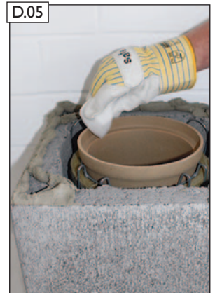
Steckverbindung säubern.
