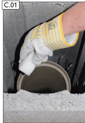
C.01 Steckverbindung säubern.
