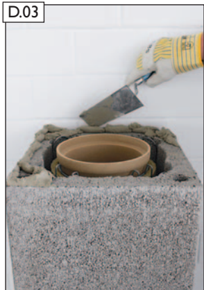
Mörtel MG(M5) IIa (Mauermörtel nach EN 998-2) auftragen.
