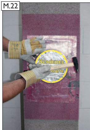
Putzring mit Putzgewebetrag er annageln. ACHTUNG! Die Spezial-Alugewebe- folie darf dabei nicht beschädigt werden!
