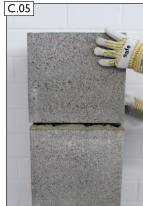
C.05 1 Mantelstein (bei Profilrohr 66 cm) in Mörtel MG(M5) Ila (Mauermörtel nach EN 998-2) versetzen.
