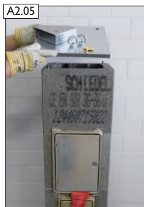
A2.05 Versetzösen und Schutzabdeckung entfernen.
