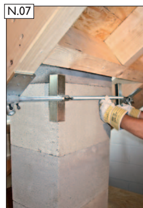
N.07 Spannwinkel an beiden Seiten ausrichten.
