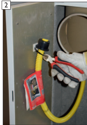
2 Kabelbinder an der Transportsicherung des Siphonschlauches entfernen.
