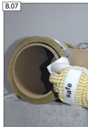
B.07 Unterseite Rauchrohranschluss säubern.
