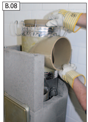
B.08 Rauchrohranschluss (RA) einsetzen.
