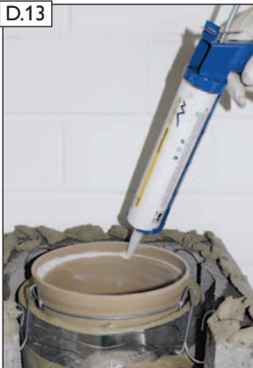
RAPID-fugendicht satt auftragen.
