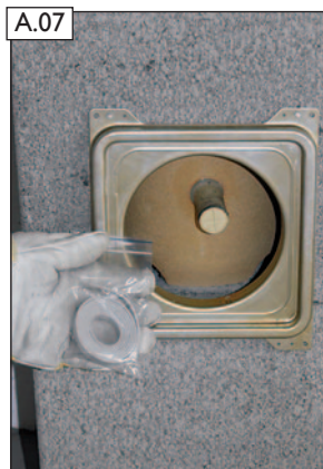
A.07 BlowerDoor Dichtset aus dem Fertigfußpaket entnehmen und ...
