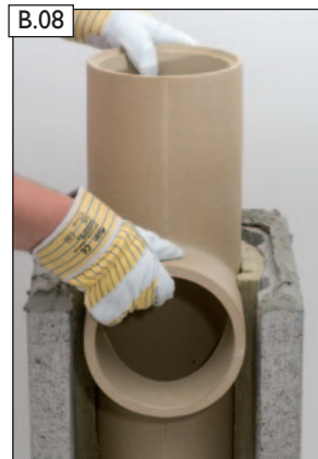
B.08 Rauchrohranschluss-Form- stück versetzen.
