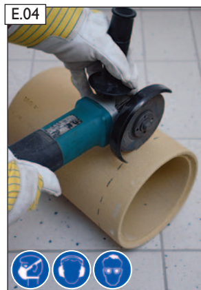
An der Nutseite des Schamotterohres anzeichnen und mit Winkelschleifer zuschneiden. ACHTUNG! Beachten Sie bitte die Hinweise zum Arbeitsschutz auf Seite 2!
