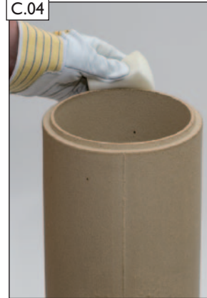
Unterseite des Schamotte- rohrs säubern.
