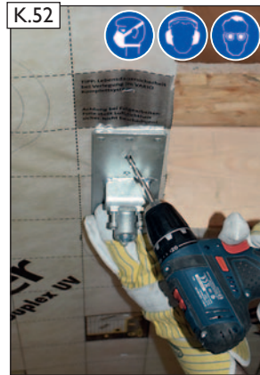
K.52 Sparrenhalter anhalten und Nagellöcher gemäß dem Nagelbild (siehe oben) vorbohren. ACHTUNG! Beachten Sie bitte die Hinweise zum Arbeitsschutz auf Seite 2!
