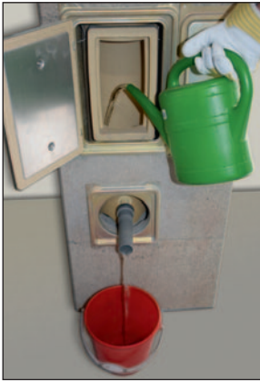
Kondensatteller und Siphonschlauch spülen.
