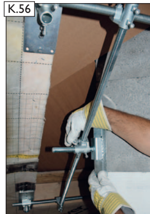
K.56 Spannwinkel ausrichten und vorfixieren.
