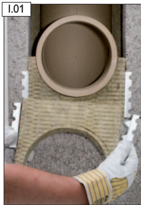
I.01 Frontplatte zuschneiden, Haltewinkel aufstecken und einsetzen.
