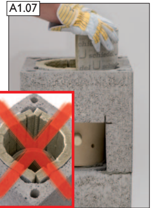
Gegenhälfte einsetzen, Stoßfugen nicht im Bereich der Hinterlüftung!
