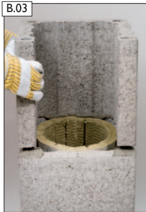
Öffnungsstein in Mörtel MG(M5) Ila (Mauermörtel nach EN 998-2) versetzen.
