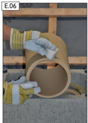
Unterseite des zugeschnittenen Abschlussrohres säubern.
