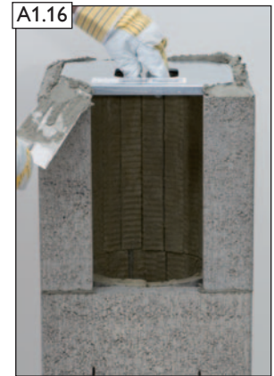
Mörtel aufbringen, Schablone verwenden.
