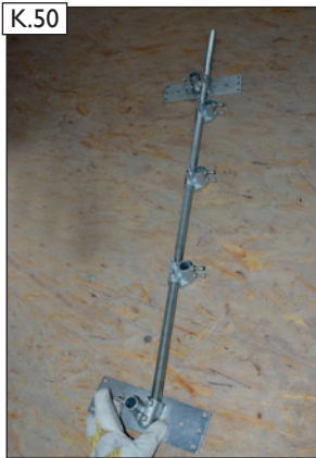
K.50 Zweiten Schornsteinhalter vorbereiten. Spannkreuze und Sparrenhalter lose auf die Gewindestange auffädeln.
