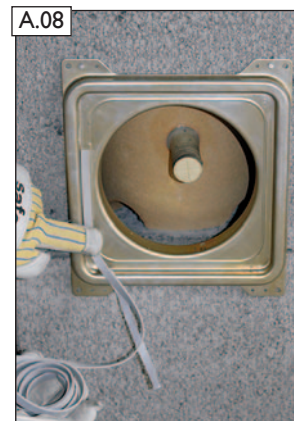
A.08 ... umlaufend dicht am Blendenrahmen aufkleben. WICHTIG! Die Klebeflächen müssen sauber und trocken sein!
