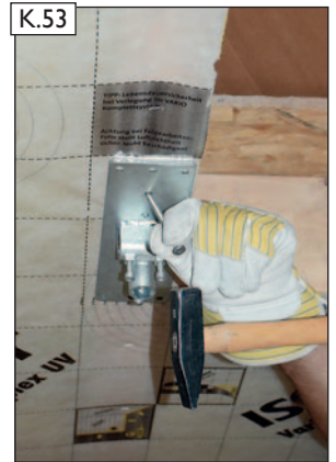
K.53 Sparrenhalter mit Kammnägeln (E) ausnageln.
