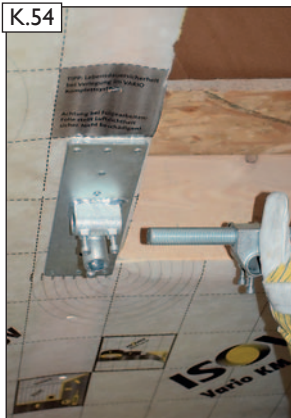
K.54 Gewindestange und 45° Spannwinkel wieder einfädeln und ausrichten.
