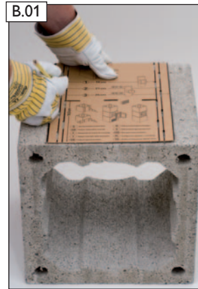
Mantelstein mit RA-Ausschnittschablone anzeichnen. Schablone mittig anlegen.
