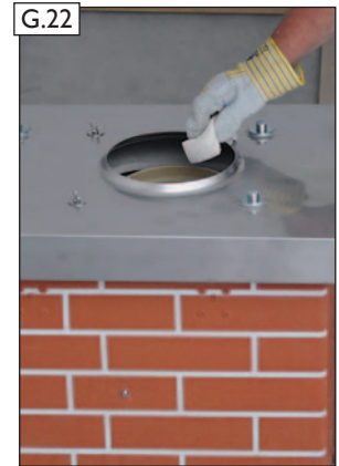
Steckverbindung säubern.
