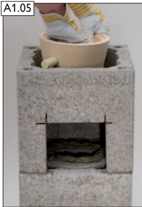
Öffnungsstein für Zuluftgittereinbau und Sockelstein in Mörtel versetzen.
