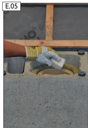
Unterseite des Schamotterohrs säubern.
