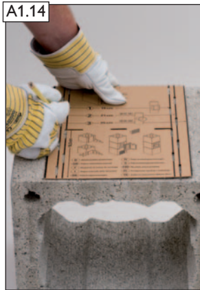
Mantelstein mit Schablone anzeichnen und ausschneiden.
