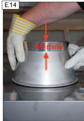
Konus nach unten bis ca. 2-3 mm auf Zuluftkopfplatte aufschieben. (Höhenausgleich bis 40 mm möglich)
