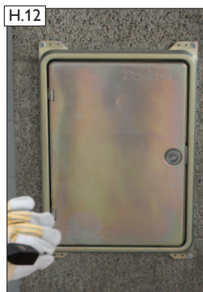
H.12 Abschlussarbeit: Putztür annageln.
