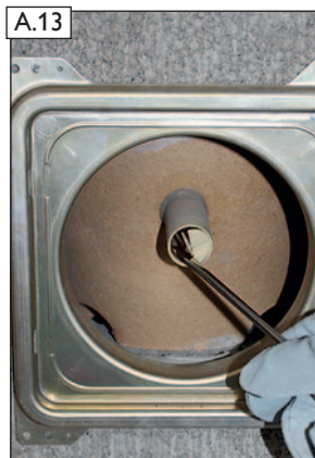
A.13 Verschluss am Kondensatablauf des Sockelsteins herausbrechen.
