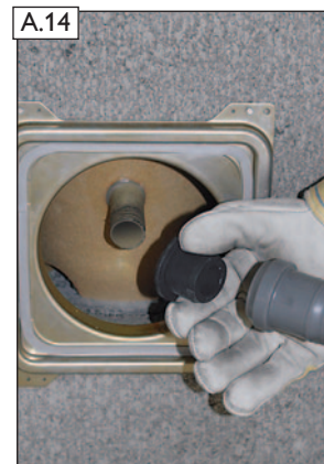
A.14 Anschlussübergang von HT DN40 auf den Kondensatablauf des Sockelsteins erfolgt mit einem Adaptergummi.
