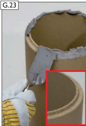
Fugenkitt auf Rohrunterseite des Abschlussrohres auftragen.
