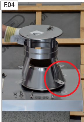
Regenhaube „EAGLE“ auf die Silikondichtungen aufsetzen.
