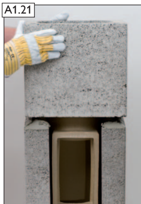
Vorgedämmten Mantelstein versetzen.
