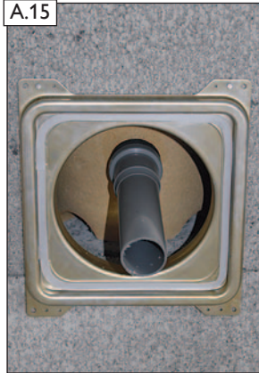
Ansicht fertiger Anschlussübergang.
