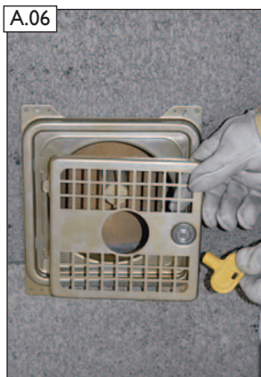
A.06 Zulufttürblatt mit PT-Schlüssel öffnen und aushängen.
