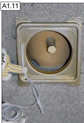
... umlaufend dicht am Blendenrahmen aufkleben. WICHTIG! Die Klebeflächen müssen sauber und trocken sein!
