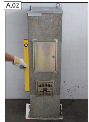
Fertigfuß in Mörtel MG(M5) Ila (Mauermörtel nach EN 998-2) versetzen und lotrecht ausrichten.
