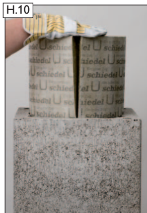
H.10 Dämmplatten biegen, einsetzen und gemeinsam nach unten schieben.
