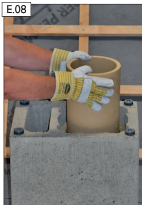
Abschlussrohr (ohne Dämmschale) versetzen.
