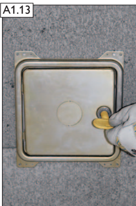
BlowerDoor Türblatt einsetzen und verschließen.
