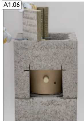
Wärmedämmung einstecken und mit Sägeblatt bündig abschneiden.
