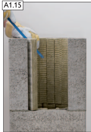
Dämmplatten einbringen und kürzen, Hinterlüftungszellen bleiben frei.
