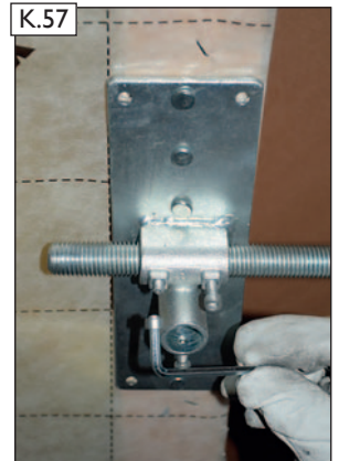
K.57 Gewindestange fixieren. Dazu die Abreißschrauben an beiden Sparrenhaltern mit Inbusschlüssel (F) anziehen bis der Schraubkopf an der Sollbruchstelle abreißt. Erst danach Spannwinkel fixieren (siehe Bild K.58).
