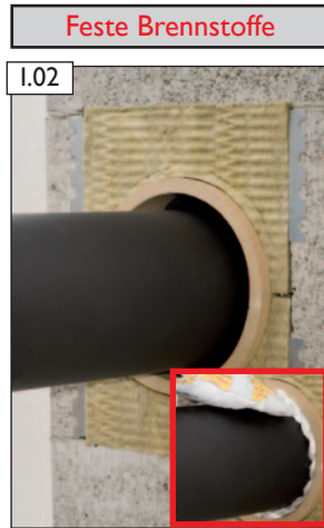
I.02 Feste Brennstoffe Ringspalt zwischen Schamottestutzen und Rauchrohr mit keramischer Schnur abdichten.
