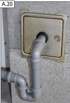
Fertigansicht mit bauseitigem Siphon.
