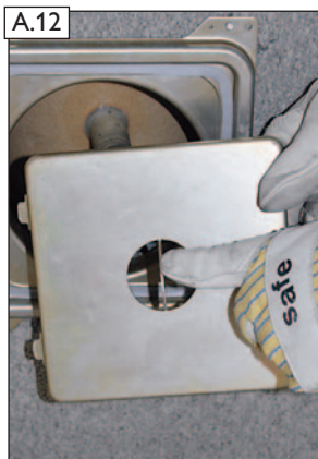
A.12 Den perforierten Öffnungsverschluss herausbrechen.
