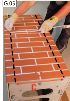
Ermittelte Abmessungen C des Mantelsteins mittig auf den Stülpkopf übertragen.
