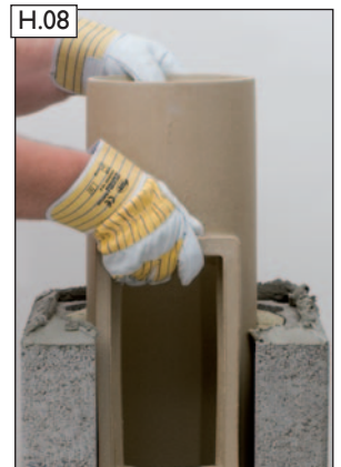
H.08 Putztüranschluss-Formstück versetzen.
