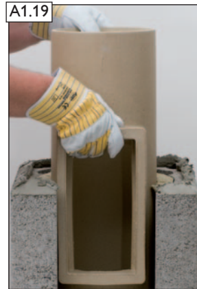
PA-Formstück versetzen, Zargenabstand planparallel zum Mantelstein.
