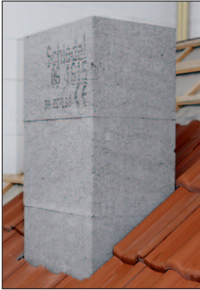
Ansicht vor Montagebeginn.
