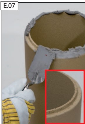
Fugenkitt auf Rohrunterseite auftragen.
