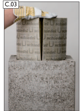
Dämmplatten biegen, einsetzen und gemeinsam nach unten schieben.
