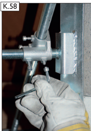
K.58 Spannwinkel an den Schornstein drücken. Abreißschrauben anziehen bis der Schraubkopf an der Sollbruchstelle abreißt.
