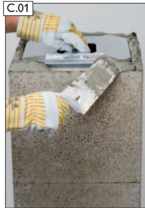
Mörtel MG(M5) IIa (Mauermörtel nach EN 998-2) mit Versetzschablone auf Mantelstein auftragen.
