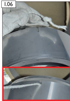
I.06 An einem Ende der E-Glas Flachdichtung einen Knoten binden und das Knotenende der E-Glas Flachdichtung in den Knotenfänger des Anschlussfutters einhängen.
