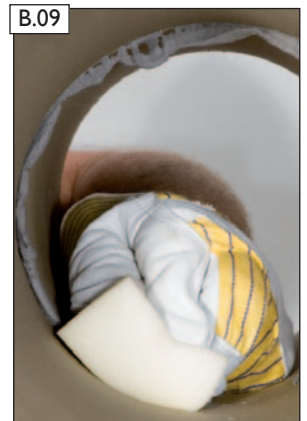
B.09 Fugenkittreste abstreifen.
