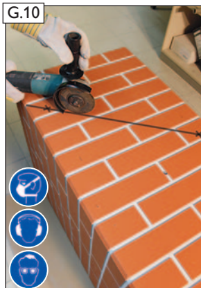
Schrägschnitt mit Flex herstellen.
