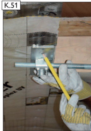
K.51 Aufgefädelt Einzelteile zum einrichten anhalten. Einbauposition für den Sparrenhalter markieren. Danach Einzelteile ausfädeln.
