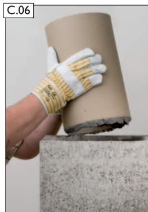
Schamotte- rohr versetzen.
