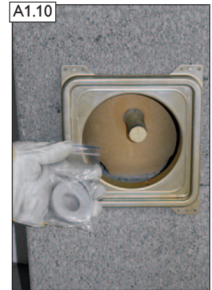
BlowerDoor Dichtset aus dem Fertigfußpaket entnehmen und ...
