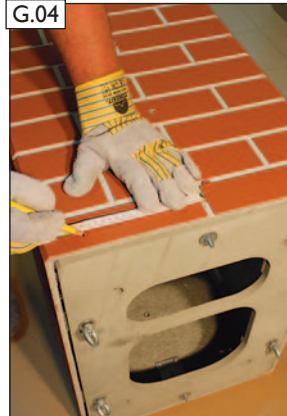
Ermittelte Abmessungen C des Mantelsteins mittig auf den Stülpkopf übertragen.
