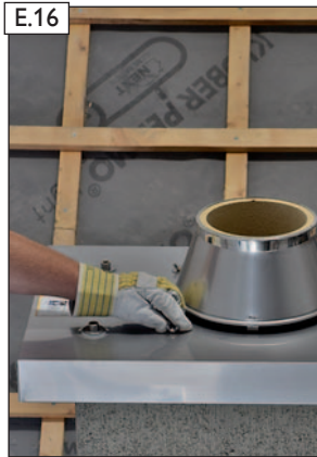
Beilagenscheiben und Flügelmuttern auf den beiden Befestigungsbolzen der Zuluftabdeckplatte montieren.
