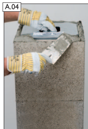
Mörtel MG(M5) Ila (Mauermörtel nach EN 998-2) mit Versetzschablone auf Fertigfuß auftragen.
