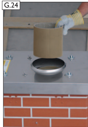
Zugeschnittenes Abschlussrohr versetzen.
