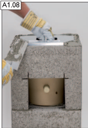
Mörtel mit Versetzschablone auf Mantelstein auftragen.
