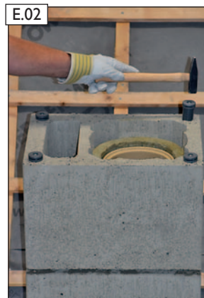
HEB-Spezialdübel in die Bewehrungskanäle des Mantelsteins einschlagen.
