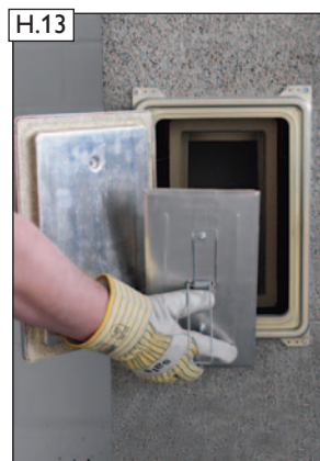
H.13 Vorsatzschale aus dem SIH-Anschlusspaket entnehmen und in den Putztüranschluss einsetzen.
