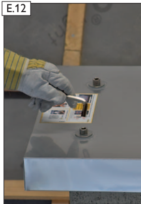
3. Edelstahl-Inbusschrauben M12 handfest anziehen.
