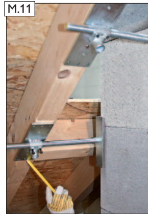
Aufgefädelte Einzelteile zum einrichten anhalten. Einbauposition für den Sparrenhalter markieren. Danach Einzelteile ausfädeln.
