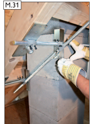
Zusätzliche Gewindestange fixieren. Dazu die Abreißschrauben an den Spannkreuzen mit Inbusschlüssel anziehen bis Schraubkopf an der Sollbruchstelle abreißt.
