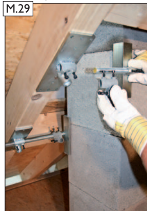
Sparrenhalter anbringen (siehe Bild M.01 bis M.05). Gewindestange, Spannwinkel und Spannkreuze wieder einfädeln.
