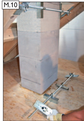
Zweiten Schornsteinhalter vorbereiten. Spannwinkel und Sparrenhalter lose auf die Gewindestange auffädeln.
