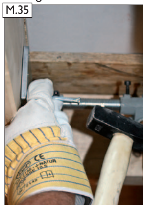
Traufseitigen Sparrenhalter mit Kammnägeln (D) ohne vorzubohren ausnageln (siehe Nagelbild Zwischensparrenmontage).
