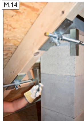
Gewindestange und Spannwinkel wieder einfädeln und ausrichten.
