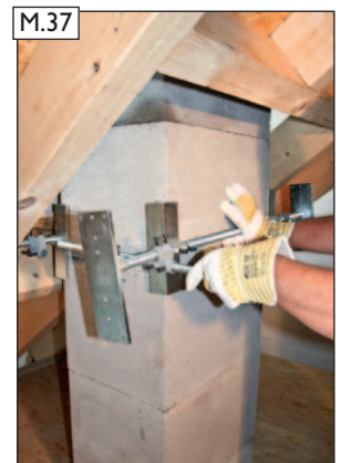
Lose aufgesteckte Sparrenhalter, Spannkreuze, Spannwinkel und Gewindestange in die Wechsellösung einbringen.
