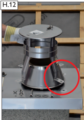
Regenhaube „EAGLE“ auf die Silikondichtungen aufsetzen.
