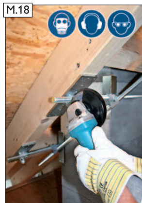
Bei Bedarf überstehende Gewindestangen an den Lagerbuchsen kürzen. ACHTUNG! Beachten Sie bitte die Hinweise zum Arbeitsschutz auf Seite 2!
