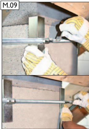
Spannwinkel an den Schornstein drücken. Abreißschrauben anziehen bis der Schraubkopf an der Sollbruchstelle abreißt.
