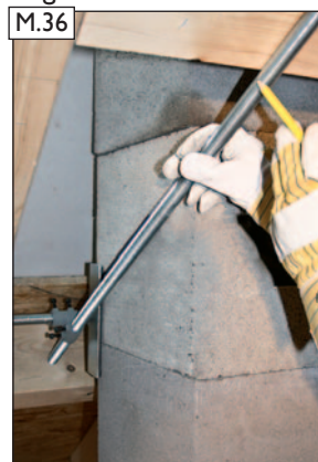
Mögliche Einbaulänge ermitteln, auf Gewindestange markieren und kürzen.
