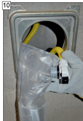
Bei fehlender Ableitung kann Kondensat- und Niederschlagswasser mit dem PARAT-Kondensatauffangbeutel, mit spezieller Sicherheitskupplung zum Beutelwechsel, gesammelt und entsorgt werden.
