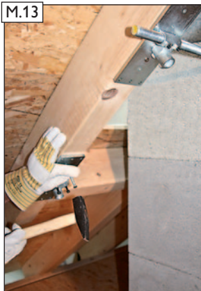
Sparrenhalter mit Kammnägeln (D) ausnageln.
