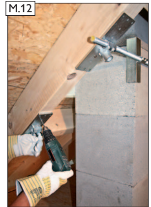
Sparrenhalter anhalten und Nagellöcher gemäß dem Nagelbild (siehe oben) vorbohren.
