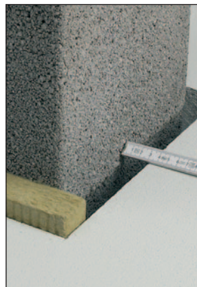
Montageöffnung allseitig mind. 3 cm größer als Mantelsteinmaß.
