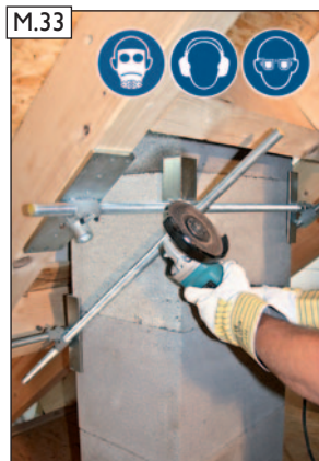
Bei Bedarf überstehende Gewindestange an den Spannkreuzen kürzen.
