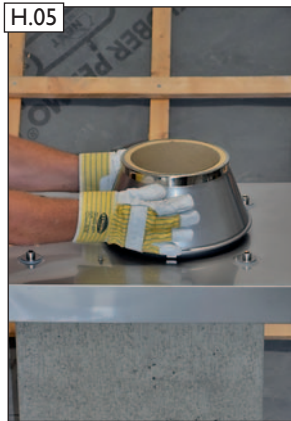
Konus bis ca. 2-3 cm auf Abdeckplatte schieben.
