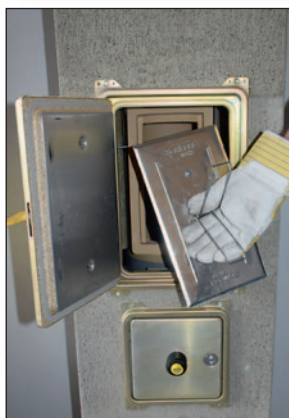
Putztür öffnen und Vorsatzschale herausnehmen.
