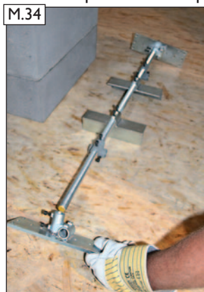
Vorarbeiten ausführen (siehe Bild M.18 bis M.20). Spannwinkel, Spannkreuze lose auf Gewindestange auffädeln und Sparrenhalter lose aufstecken.
