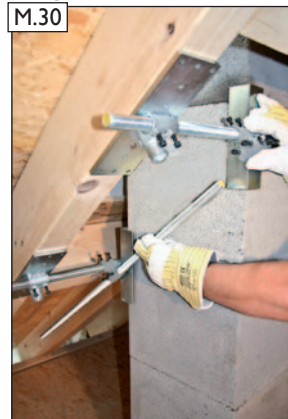
Gewindestange und Spannwinkel fixieren (siehe Bild M.08 und M.09). Zusätzliche Gewindestange in die Spannkreuze einfädeln.
