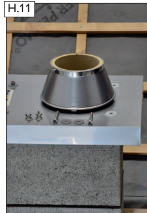
Silikondichtungen auf Zuluftkopfplatte-Edelstahl auflegen. Regenhaube „EAGLE“ aufsetzen.
