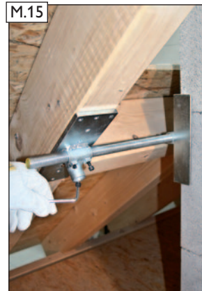
Gewindestange fixieren. Dazu die Abreißschrauben an beiden Sparrenhaltern mit Inbusschlüssel (E) anziehen bis der Schraubkopf an der Sollbruchstelle abreißt. Erst danach Spannwinkel fixieren (siehe Bild M.09).
