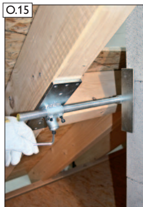
O.15 Gewindestange fixieren. Dazu die Abreißschrauben an beiden Sparrenhaltern mit Inbusschlüssel (E) anziehen bis der Schraubkopf an der Sollbruchstelle abreißt. Erst danach Spannwinkel fixieren (siehe Bild O.09).
