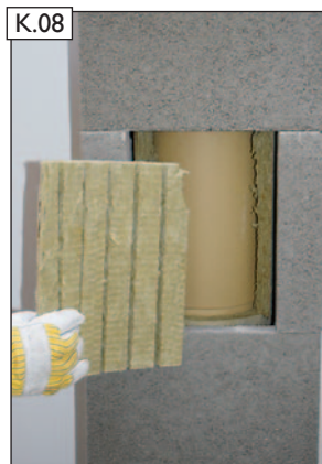
Dämmschicht vollständig entfernen.
