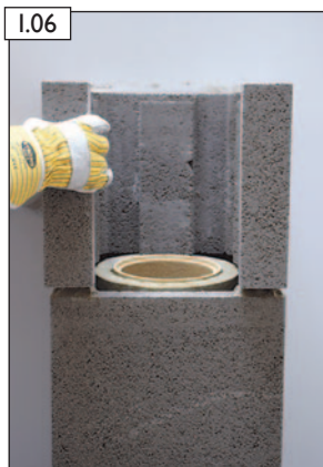
PA-Öffungsstein versetzen.
