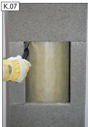
Vordere erreichbare Dämmschicht mit Cuttermesser freischneiden.
