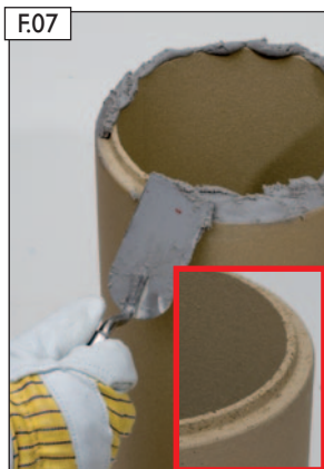
F.07 Fugenkitt auf Rohrunterseite auftragen.
