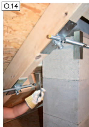
O.14 Gewindestange und Spannwinkel wieder ein-fädeln und ausrichten.
