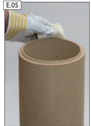
Unterseite des Schamotterohrs säubern.
