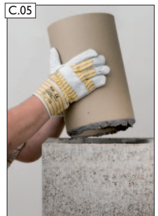
Schamotterrohr versetzen.
