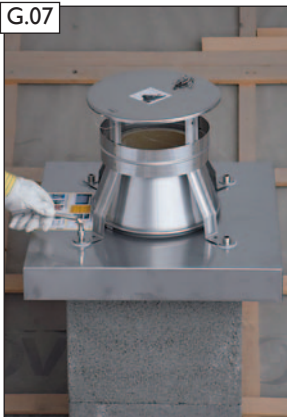
Regenhaube „EAGLE“ mit der Zuluftkopfplatte-Edelstahl verschrauben.
