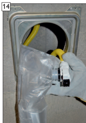
Kondensatauffangbeutel vorsichtig herausziehen.
