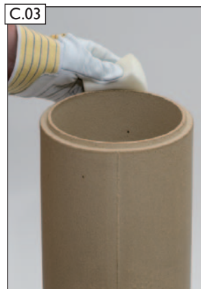
Unterseite des Schamotterohrs säubern.
