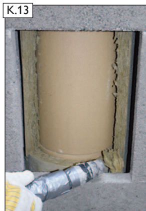
Zuluftkanäle von Dämmstoffresten freihalten.
