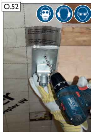
O.52 Sparrenhalter anhalten und Nagellöcher gemäß dem Nagelbild (siehe oben) vorbohren. ACHTUNG! Beachten Sie bitte die Hinweise zum Arbeitsschutz auf Seite 2!
