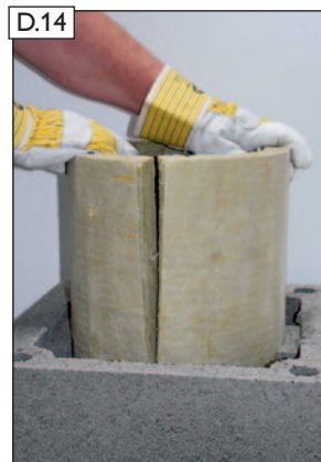
Dämmplatte biegen, einsetzen und nach unten schieben.
