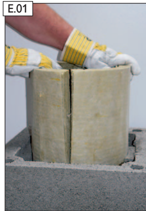
Dämmplatte biegen, einsetzen und nach unten schieben.
