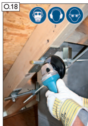
O.18 Bei Bedarf überstehende Gewindestangen an den Lagerbuchsen kürzen. ACHTUNG! Beachten Sie bitte die Hinweise zum Arbeitsschutz auf Seite 2!
