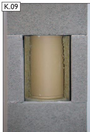
Fertigansicht der entfernten vorderen Dämmschicht.
