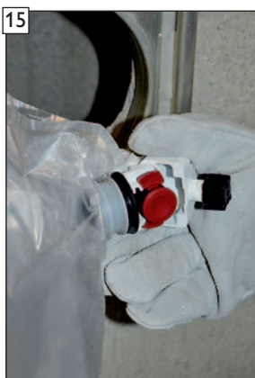
Verriegelung des BIB-Connectors öffnen und BIB-Anschlussahn mit dem Kondensatauffangbeutel aus dem Kupplungsteil herausziehen.
