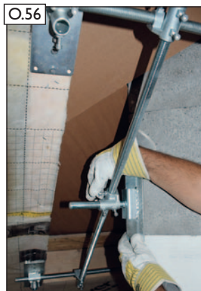
O.56 Spannwinkel ausrichten und vorfixieren.
