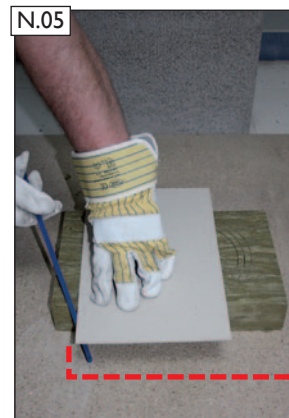
BDF mit der Dämmstoffsäge und der Schnittschablone (als Anschlagführung) zuschneiden. Den entstandenen BDF-Abchnitt an der Oberseite anlegen. Der innere Stützkern bleibt dabei als Aussteifung in der BDF.
