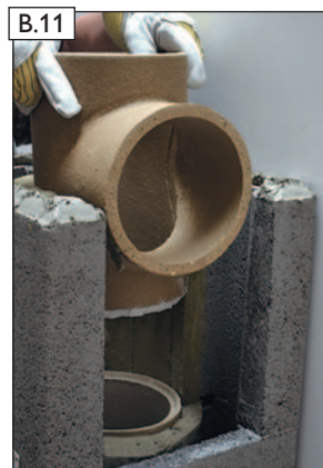
Rauchrohranschluss (RA) einsetzen.
