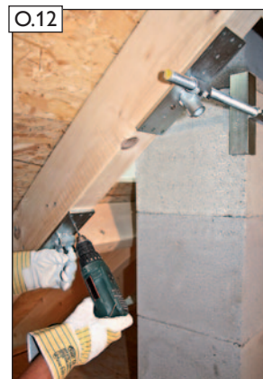
O.12 Sparrenhalter anhalten und Nagellöcher gemäß dem Nagelbild (siehe oben) vorbohren.
