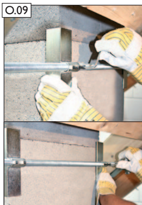
O.09 Spannwinkel an den Schornstein drücken. Abreißschrauben anziehen bis der Schraubkopf an der Sollbruchstelle abreißt.
