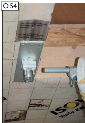
O.54 Gewindestange und 45° Spannwinkel wieder ein-fädeln und ausrichten.
