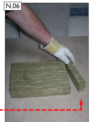
BDF mit der Dämmstoffsäge und der Schnittschablone (als Anschlagführung) zuschneiden. Den entstandenen BDF-Abchnitt an der Oberseite anlegen. Der innere Stützkern bleibt dabei als Aussteifung in der BDF.
