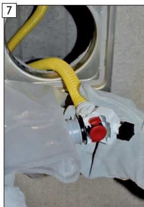
BIB-Anschlussahn des Kondensatauffangbeutels in die Aufnahme des Kupplungsteils vom BIB-Connector einstecken.
