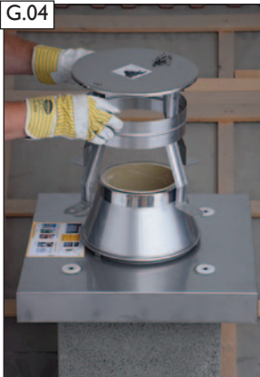
Regenhaube „EAGLE“ auf die Silikondichtungen aufsetzen.
