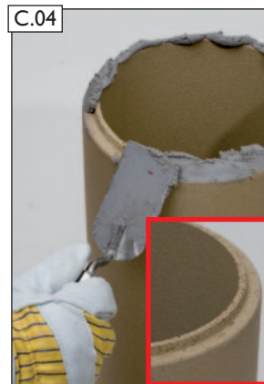
Fugenkitt auf Rohrunterseite auftragen.
