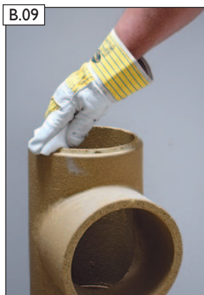
Unterseite Rauchrohranschluss säubern.
