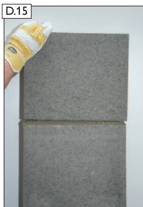
Vorgedämmten Mantel- stein versetzen.
