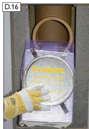
Abschlussarbeit: Einbau BlowerDoor Front- platte (Einbauanleitung siehe Kapitel N)
