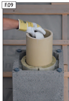
F.09 Fugenkittreste abstreifen.
