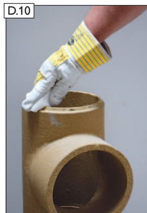
Unterseite Rauchrohran- schluss säubern.
