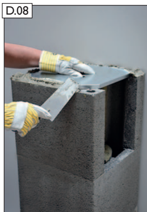
Mörtel aufbringen, Schablone verwenden.
