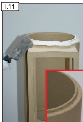
Fugenkitt auf Unterseite Rauchrohranschluss-Formstück (RA) auftragen.
