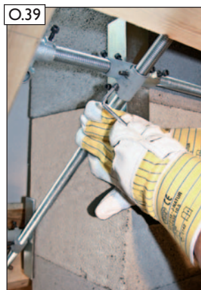
O.39 Zuerst Sparrenhalter und Spannwinkel (siehe Bild O.24 und O.25), danach Spannkreuz fixieren. Abreißschrauben anziehen bis Schraubkopf an der Sollbruchstelle abreißt.
