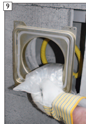
Siphonschlauch und Kondensatauffangbeutel in Schornsteinfuß einschieben.
