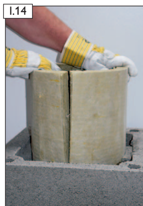
Dämmplatten biegen, einsetzen und gemeinsam nach unten schieben.
