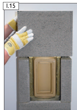
Vorgedämmten Mantelstein versetzen. HINWEIS! Weiter mit Standardversetzvorgang auf Seite 18.
