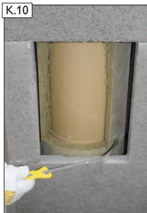
Das 1/4-Kreis Gelenk-Dämmstoffmesser ansetzen.
