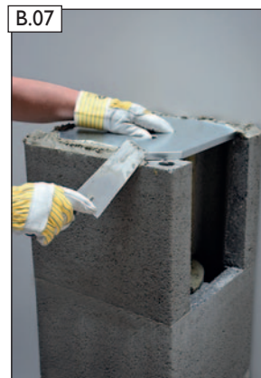
B.07 Mörtel MG(M5) IIa (Mauermörtel nach EN 998-2) mit Versetzschaablone auf Mantelstein auftragen.
