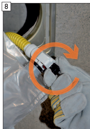
Verriegelung des BIB-Connectors im Uhrzeigersinn schließen.
