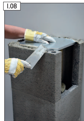
Mörtel aufbringen, Schablone verwenden.
