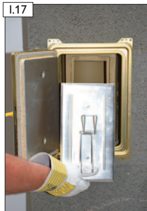
Vorsatzschale einsetzen.
