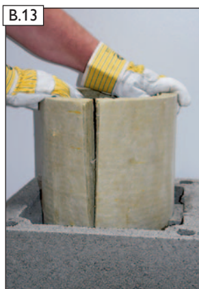
Dämmplatte biegen, einsetzen und nach unten schieben.
