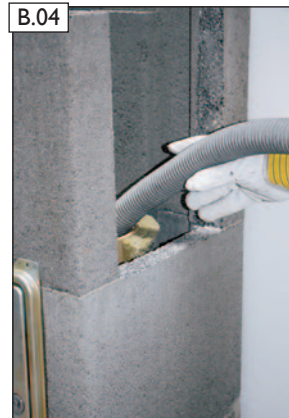
B.04 Fertigfuß von allen Bauschuttresten säubern.
