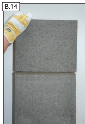
Vorgedämmten Mantelstein versetzen.
