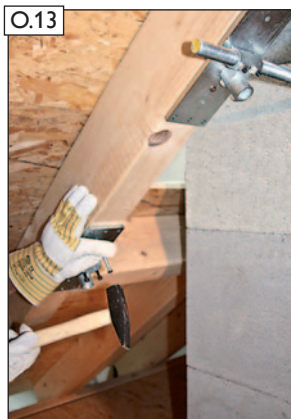
O.13 Sparrenhalter mit Kamm-nägeln (D) ausnageln.
