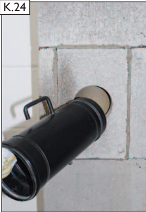
Bauseitige Zuluftleitung einbauen.
