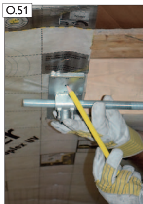
O.51 Aufgefädelt Einzelteile zum einrichten anhalten. Einbauposition für den Sparrenhalter markieren. Danach Einzelteile aus-fädeln.
