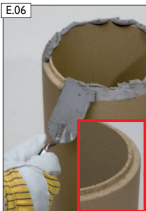
Fugenkitt auf Rohrunterseite auftragen.
