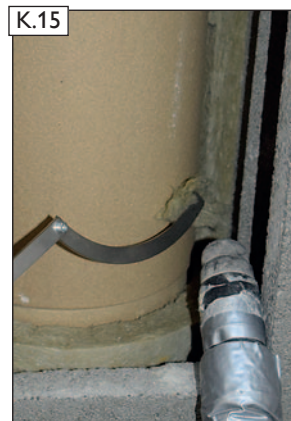
Kleine Dämmstoffreste immer sofort mit dem Staubsauger aufnehmen.
