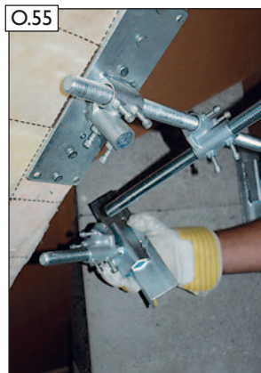
O.55 Gewindestange in Spannkreuze des oberen und unteren Schornsteinhalters einfädeln und dabei das Spannkreuz mit dem 45° Spannwinkel mit auffädeln.
