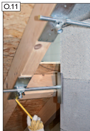
O.11 Aufgefädelte Einzelteile zum einrichten anhalten. Einbauposition für den Sparrenhalter markieren. Danach Einzelteile aus-fädeln.
