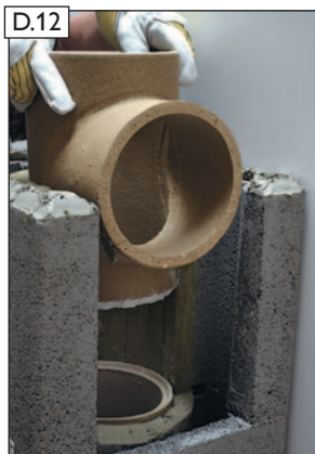
Rauchrohranschluss (RA) einsetzen.
