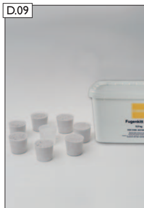
Fugenkitt anmischen. Verhältnis: 7 Teile Fugenkitt auf 1 Teil Wasser
