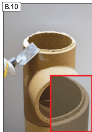
Fugenkitt auf Unterseite Rauchrohranschluss-Formstück (RA) auftragen.
