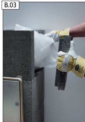
B.03 Bauseitige Schutzabdeckung entfernen.
