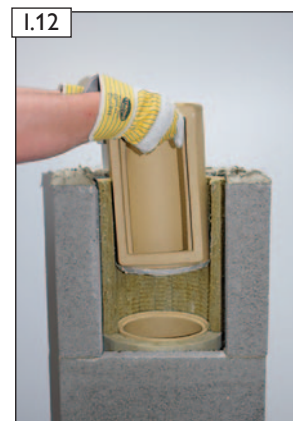
PA-Formstück einsetzen.
