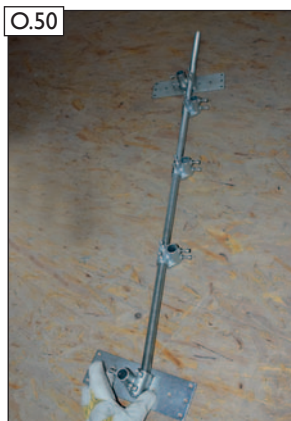
O.50 Zweiten Schornsteinhalter vorbereiten. Spannkreuze und Sparrenhalter lose auf die Gewindestange auf-fädeln.
