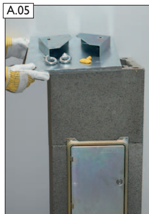
A.05 Versetzösen und Schutzabdeckung entfernen.
