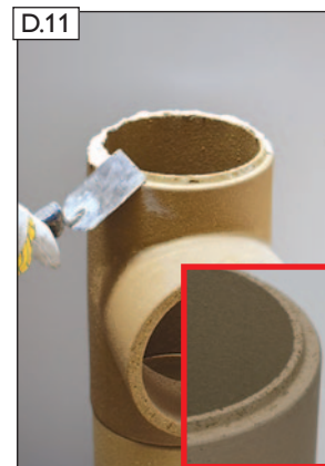
Fugenkitt auf Unterseite Rauchrohranschluss-Form- stück (RA) auftragen.
