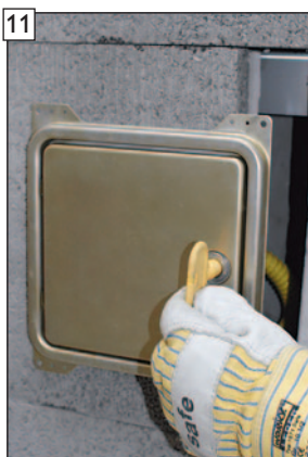
Kondensatblendentürblatt wieder verschließen.
