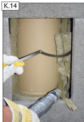
Seitlichen Dämmstoff mit dem 1/4-Kreis Dämmstoffschaber entfernen.
