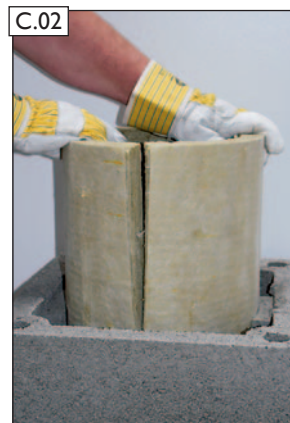
Dämmplatte biegen, einsetzen und nach unten schieben.
