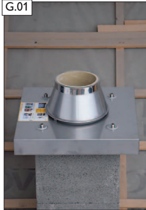
Ansicht vor Montagebeginn.
