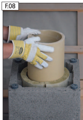
F.08 Abschluss-Profilrohr (ohne Dämmschale) versetzen.
