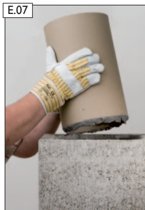
Schamotterohr versetzen.
