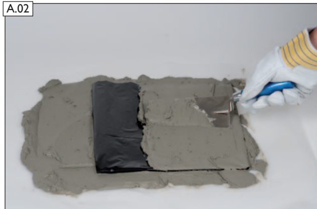
A.02 Mörtelbett vorbereiten, Feuchtesperre einlegen, Mörtel MG(M5) IIa (Mauermörtel nach EN 998-2) auftragen.
