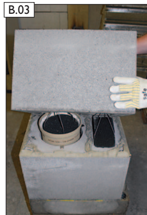
B.03 Mantelstein versetzen.
