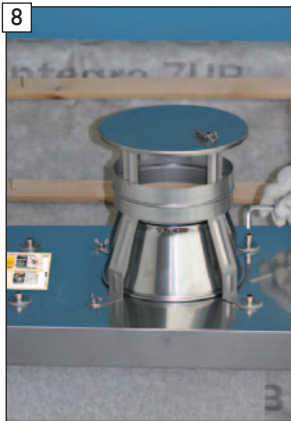
8 Regenhaube „EAGLE“ mit der Zuluftkopfplatte-Edelstahl verschrauben.
