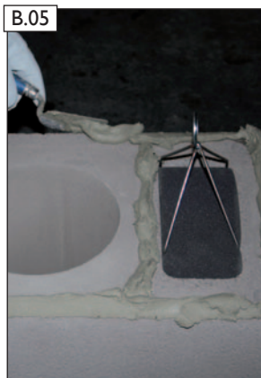
B.05 Dünnbettmörtel auftragen.
