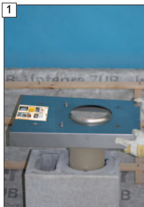
Zuluftkopfplatte-Edelstahl auflegen.
