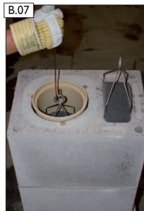
B.07 Nach dem Einbau des nächsten Keramikrohres wird der obere Schutzschwamm Abgas (3) mit Hilfe des Hakens (6) immer wieder bündig zur Muffe des versetzten Keramikrohres gezogen.
