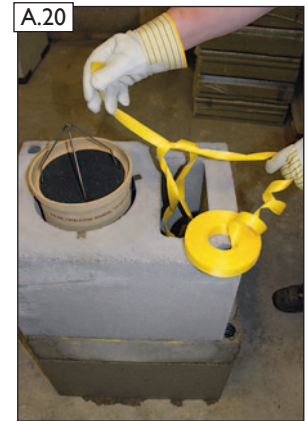
A.20 Äußeres Zugseilende mit dem unteren Schutzschwamm Zuluft (2) sicher verknotten.
