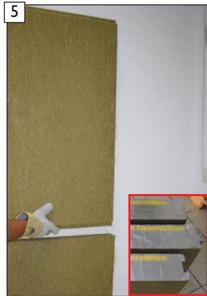
5 Doppelfederplatte in die Nutplatte einstecken und ...
