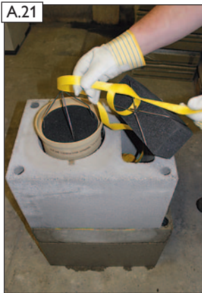
A.21 Inneres Zugseilende mit der Unterseite des oberen Schutzschwamms Zuluft (4) sicher verknotten und bündig bis zur Mantelsteinoberkante einstecken.
