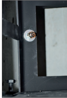
Ansicht der werkseitig verbauten Potentialausgleichsanschlussklemme.
