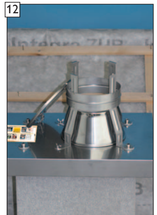
14 Der Revisionsdeckel ist mit einer Drahtschlinge, als „Absturzicherung“, verbunden. Die Drahtschlaufensicherung mind. einmal im Jahr überprüfen und ggf. erneuern.
