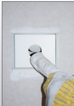
Perforiertes Eingriffsloch eindrücken.
