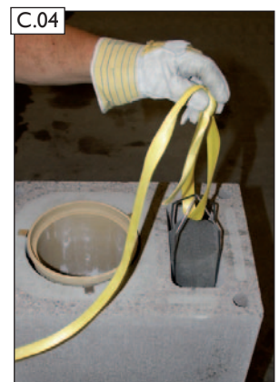
C.04 Mit dem Zugseil den unteren Schutzschwamm Zuluft (2) nach oben ziehen.
