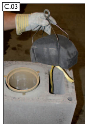
C.03 Oberen Schutzschwamm Zuluft (4) herausziehen.
