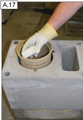
A.17 Muffenverbindung gem. der ABSOLUT-Versetzanleitung säubern.
