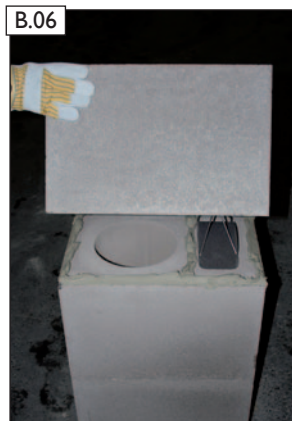
B.06 Den nächsten Mantelstein gem. des Versetzvorgangs ABSOLUT versetzen. (siehe auch ABSOLUT-Versetzanleitung)
