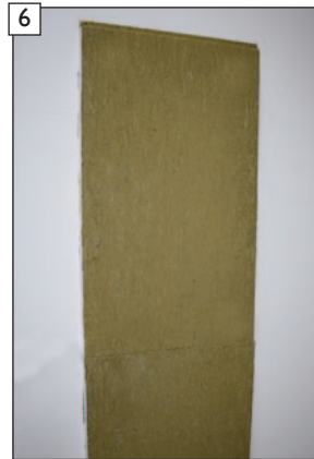
6 ... an der Innenwand befestigen.
