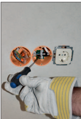
Klemmstelle für LEDA LUC Verbinder
