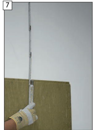
7 Differenzmaß zur bauseitigen Decke ermitteln.
