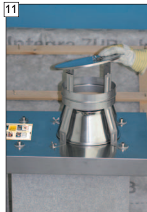
13 Der Revisionsdeckel ist mit einer Drahtschlinge, als „Absturzicherung“, verbunden. Die Drahtschlaufensicherung mind. einmal im Jahr überprüfen und ggf. erneuern.
