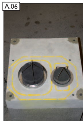
A.06 Unteren Schutzschwamm Zuluft (2) einstecken.
