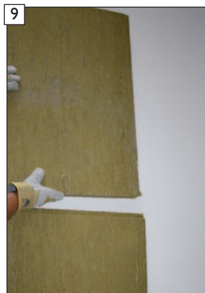
9 Obere Nutplatte in die Doppelfederplatte einstecken.
