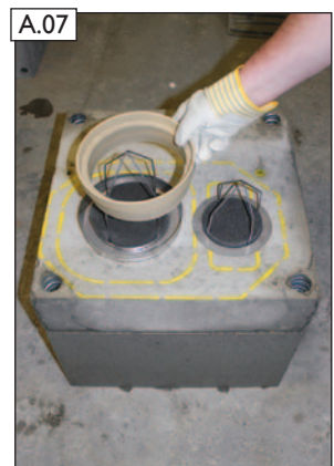
A.07 ABSOLUT-Adapterring (12) in Montagetrichter einlegen.
