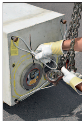
KINGFIRE-Ofenmodul gem. Versetzanleitung anschlagen.
