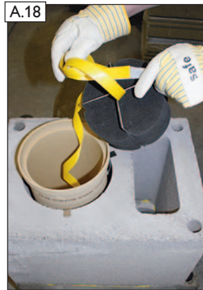
A.18 Inneres Zugseilende mit der Unterseite des oberen Schutzschwamms Abgas (3) verknotten.
