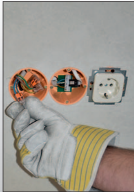
Klemmstelle für Flexkabel 230V
