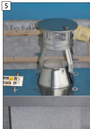
5 Silikondichtungen auf Zuluftkopfplatte-Edelstahl auflegen. Regenhaube „EAGLE“ aufsetzen.
