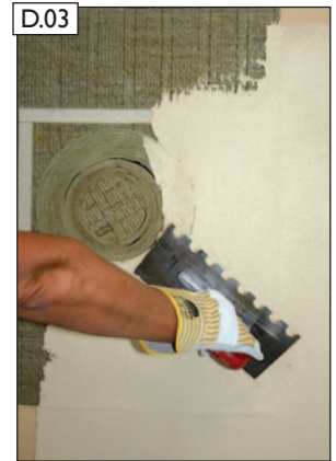
Vollflächiger Auftrag der Pressspachtelung.
