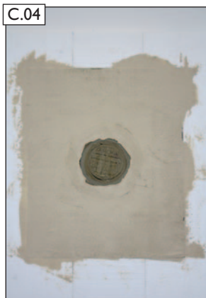
Fertigansicht der Pressspachtelung.
