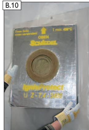
IGNIS PROTECT passgenau einsetzen. Die aluschierte Seite zeigt dabei in den Innenraum!
