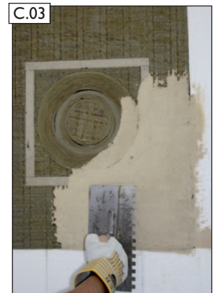
Auftrag der Pressspachtelung nur an der IGNIS PROTECT Außenseite vornehmen. ACHTUNG! Innenschutzrohre nicht mit überspachteln!
