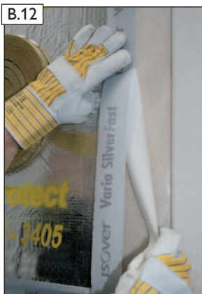
Übergänge zur Dampfbremse bauseitig mit geeignetem Dichtband auf der Alukaschierung verkleben.
