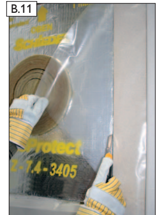
Bauseitige Dampfbremse bündig zum IGNIS PROTECT zuschneiden.
