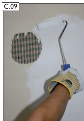
Aufbringung der Grundierung.
