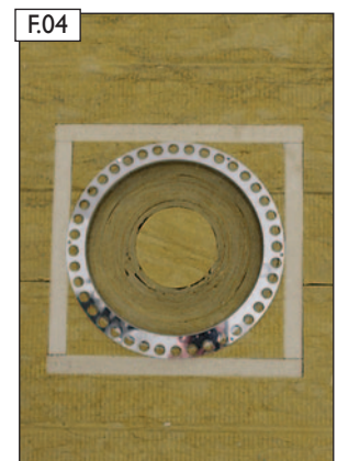
Prüfen Sie vor dem Aufbringen der Pressspachtelung nochmals die korrekte zentrische Ausrichtung der Regenrosette.
