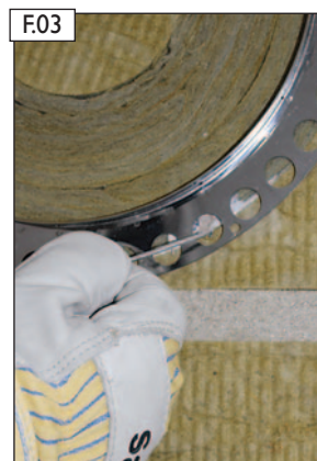
Regenrosette mit Edelstahlnägeln (bauseits bereitstellen) anheften.
