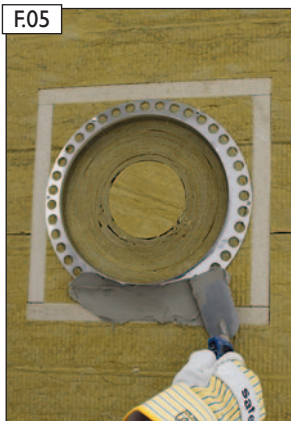
F.05 Pressspachtelung an der Außenseite vornehmen.
