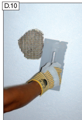
Strukturierung des Oberputzes.
