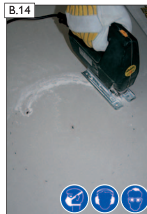
Gipskartonplatte auf das erforderliche Öffnungsmaß des IGNIS PROTECT Außenschutzrohres zuschneiden.
