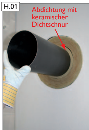
T450 Ausführungsbeispiel mit einwandiger Verbindungs- leitung.
