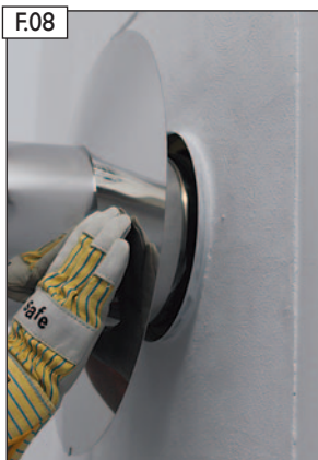
F.08 Verbindungsleitung gem. Montageanleitung einbauen.
