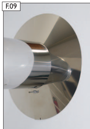
F.09 Abdeckblende gem. Montageanleitung bündig zur Außenwand montieren.
