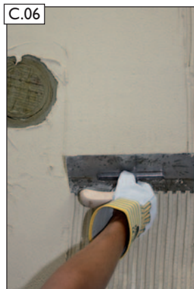
Schichtstärkenbestimmung mit der Zahnpachtel.
