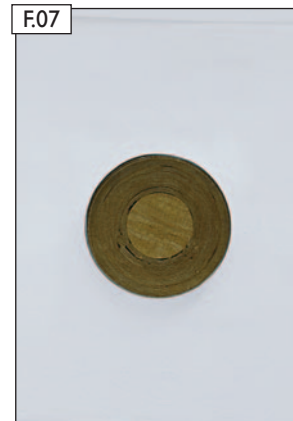
F.07 Ansicht nach Fertigstellung des Oberputzes.
