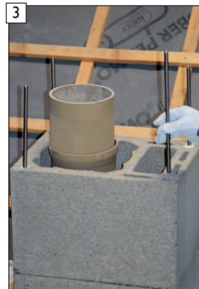
Bewehrungsverlängerung in Gewindehülsen einschrauben.
