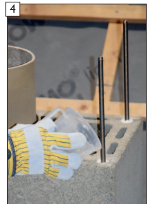
Vergussmörtel in Bewehrungskanäle einbringen.
