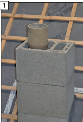
Ansicht vor Montagebeginn.
