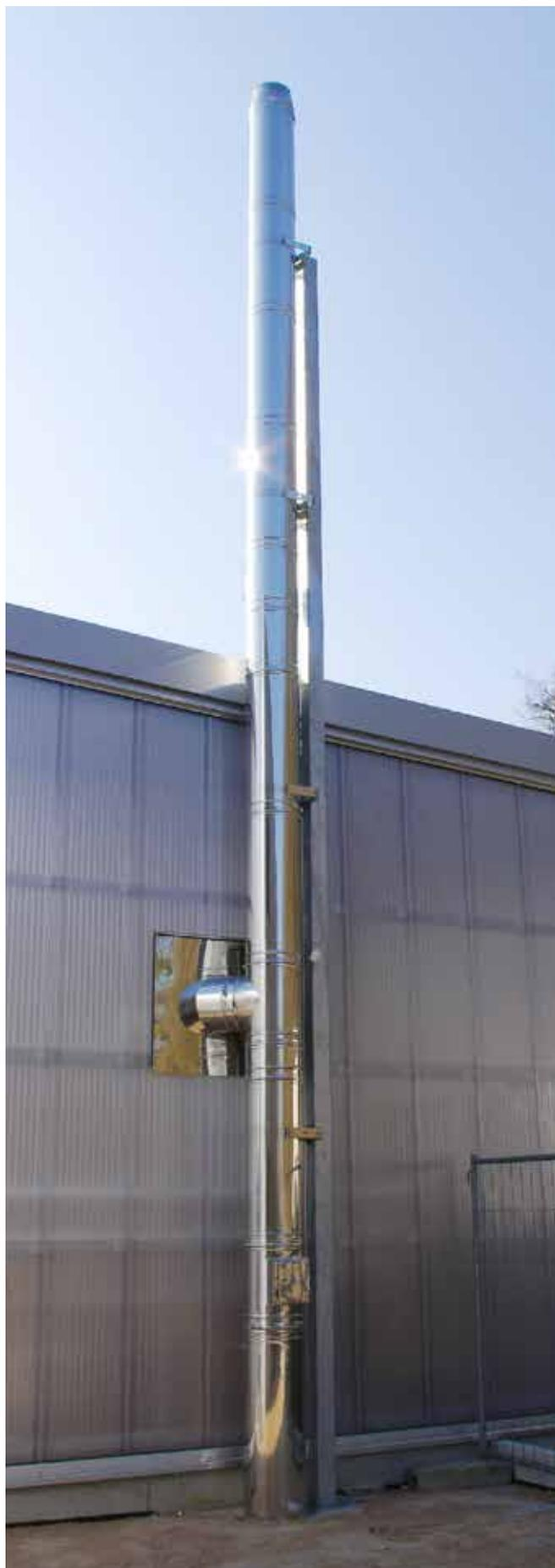
Schiedel Kragarme werden eingesetzt, wenn die freitragende Höhe nach der letzten Abstützung überschritten wird. Bei Schiedel Mastanlagen handelt es sich i.d.R. um freistehende Abgasanlagen, die der Statik entsprechen sollen.
