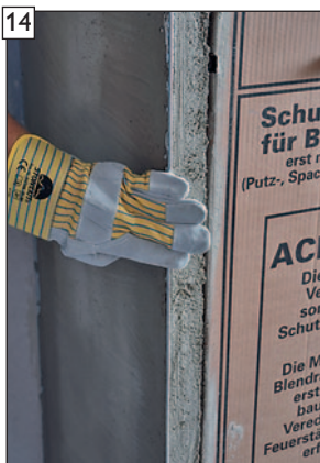
14 Eckschienenkanten noch im feuchten Zustand reinigen.
