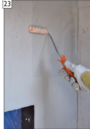
Grundierung StoPrim Plex aufbringen.
