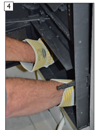
4 KINGFIRE LINEARE SC-Brennkammer kann jetzt max. 45 mm nach vorne herausgezogen werden.
