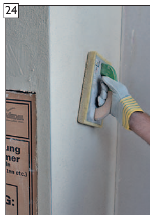
Gegebenenfalls Oberfläche im Anschluss filzen.
