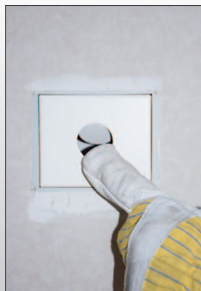
Perforiertes Eingriffsloch eindrücken.
