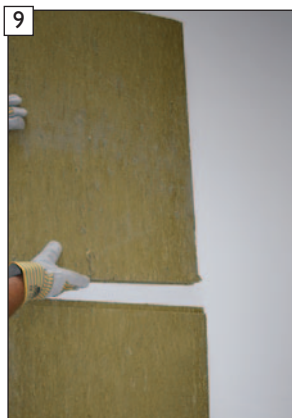
9 Obere Nutplatte in die Doppelfederplatte einstecken.
