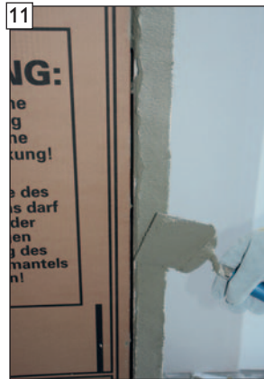
11 Haftbrückenauftrag zu den Öffnungen vornehmen, ...
