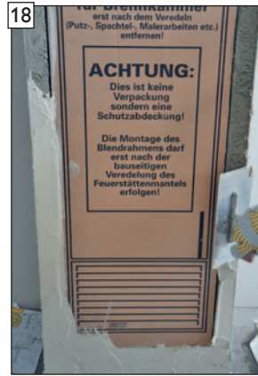
Spachtelauftrag an den Öffnungen vornehmen, ...
