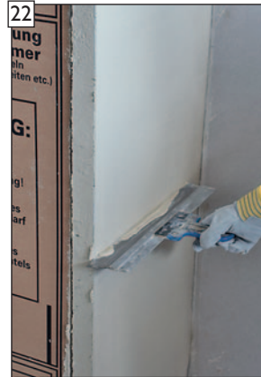
Oberfläche ggf. mit Flächenspachtel nach- arbeiten.
