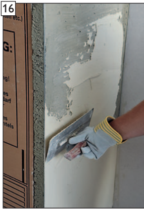
Spachtelauftrag Deck- schicht auftragen und ...
