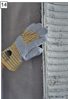
14 Eckschienenkanten noch im feuchten Zustand reinigen.
