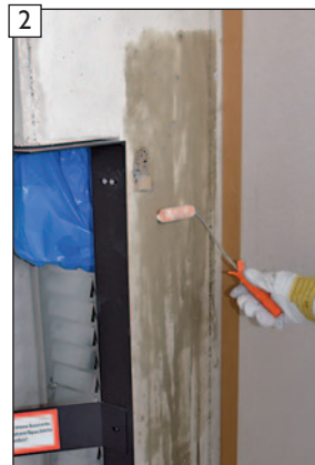
Grundierung Sopro GD 749 auf den Betonmantel aufbringen.
