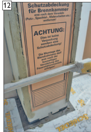
12 ... mit Kardätsche abziehen und ...
