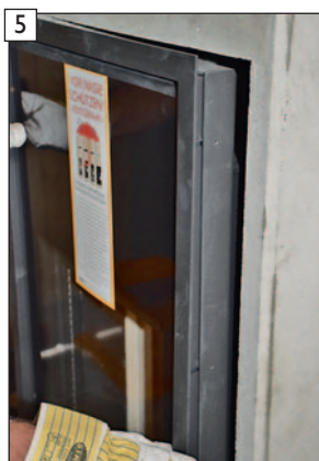
5 Montage des Universal-blendrahmens weiter mit Bild 7, Seite 24.
