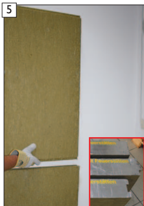
5 Doppelfederplatte in die Nutplatte einstecken und ...
