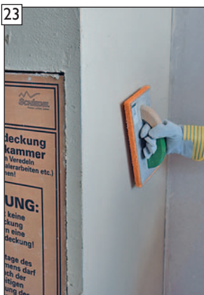
Oberfläche abreiben bzw. strukturieren.
