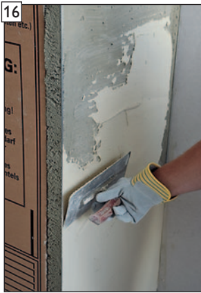
16 Oberputz auftragen und ...
