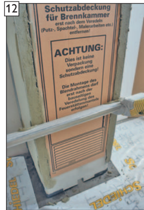
12 ... mit Kardätsche abziehen und ...
