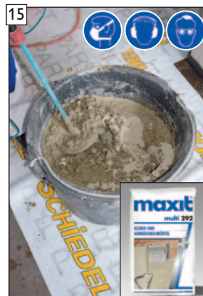
16 „maxit multi 292“ Oberputz gem. den Herstellervorgaben anmischen. ACHTUNG! Beachten Sie bitte die Hinweise zum Arbeitsschutz auf Seite 2!
