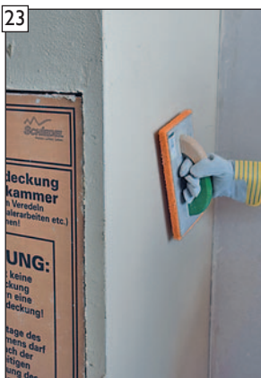
23 Oberfläche abreiben bzw. strukturieren.
