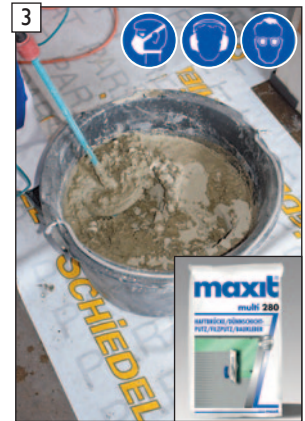
„maxit multi 280“ Haftbrücke gem. den Herstellerangaben anmischen.
