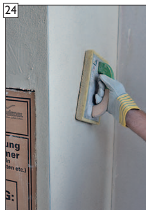
24 Gegebenenfalls Oberfläche im Anschluss filzen.
