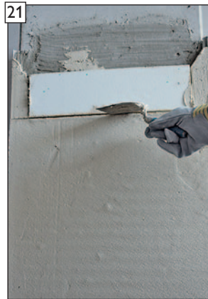
21 Ansicht „Abschneiden“ an der Konvektionsluftöffnung.
