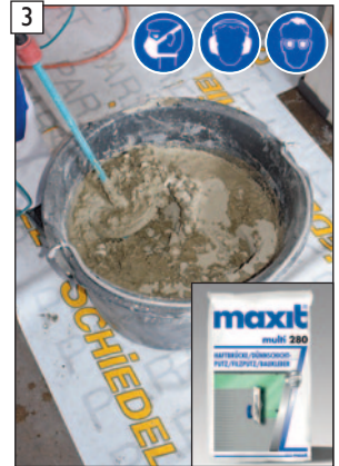
„maxit multi 280“ Haftbrücke gem. den Herstellerangaben anmischen.
