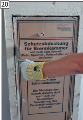
... Oberflächenspachtel an den Öffnungen abschneiden.
