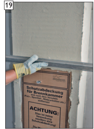
... mit Kardätsche abziehen und ...
