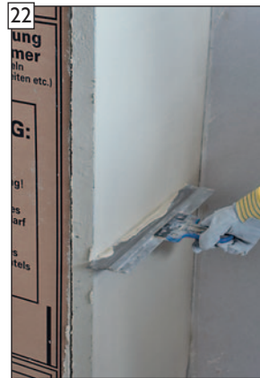
22 Oberfläche ggf. mit Flächenspachtel nacharbeiten.
