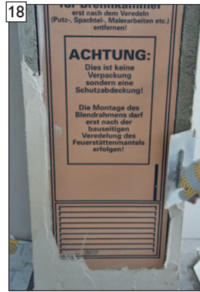
18 Oberputz an den Öffnungen auftragen und ...
