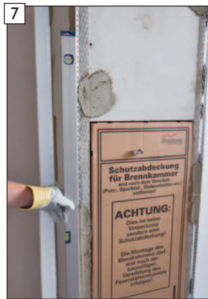
7 Eckprofile lotrecht ausrichten.
