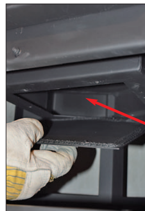
Ansicht Revisionsöffnung des Zuluftkanals an der Geräteunterseite zur Entnahme von evtl. herabfallenden Kehrresten oder Fremdkörpern aus dem Zuluftkanal.
