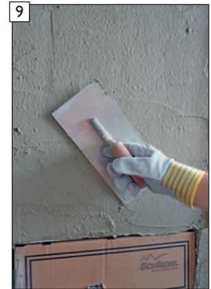
9 Haftbrückenauftrag vornehmen - max. Auftragsdicke 5 mm.
