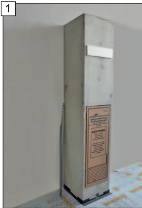
Ansicht vor Montagebeginn
