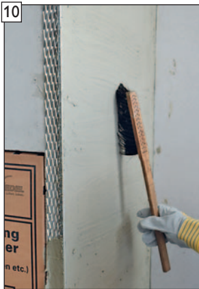
10 Oberflächenverzahnung für späteren Spachtelauftrag der Deckschicht in Haftbrücke einbringen (z.B. mit Putzbürste).
