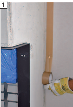
Trennband zur angrenzenden Leichtbauwand aufbringen.
