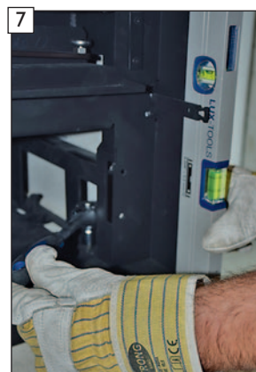
7 Ggf. ist hierbei mittels der vier Justierschrauben (B) eine entsprechende Nachjustierung der KINGFIRE LINEARE SC-Brennkammer vor dem kraftschlüssigen Anziehen der beiden Verbindungsschrauben (A) vor-zunehmen.
