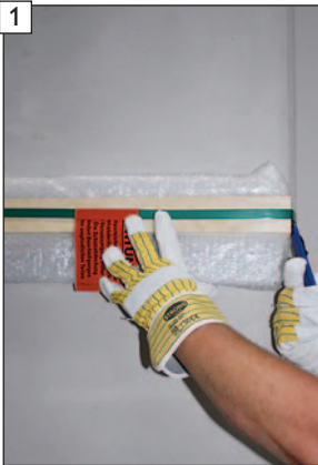
1 Transportschutzver- packung öffnen. WICHTIG! Beschädigungen am Konvektionsluftgitter/ Lackierung vermeiden!
