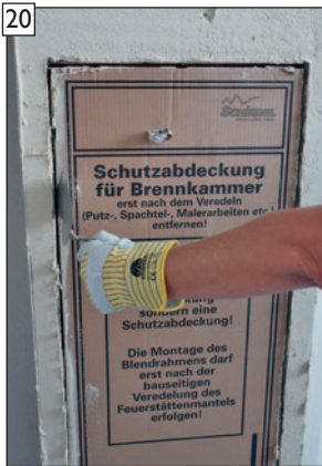
20 Oberputz an den Öffnungen abschneiden.
