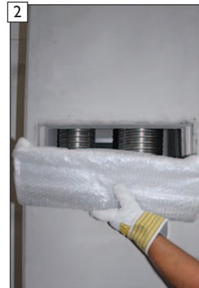
2 Konvektionsluftgitter aus der Montageöffnung ent- fernen.
