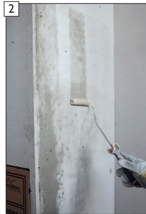
Vorreinigung des Betonmantels zur Staubbinding mit Wasser (z.B. mit Malerrolle).
