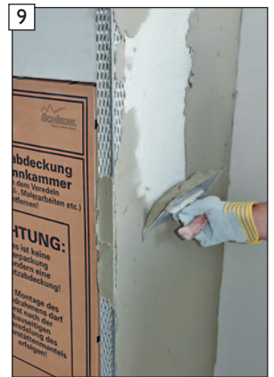
9 Haftbrückenauftrag vornehmen - max. Auftragsdicke 5 mm.
