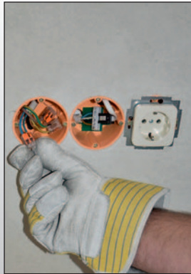
Klemmstelle für Flexkabel 230V
