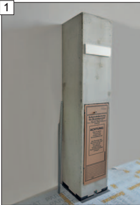
Ansicht vor Montagebeginn
