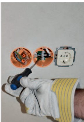
Klemmstelle für LEDA LUC Verbinder
