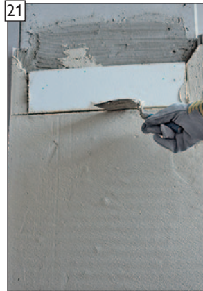
Ansicht „Abschneiden“ an der Konvektionsluftöffnung.
