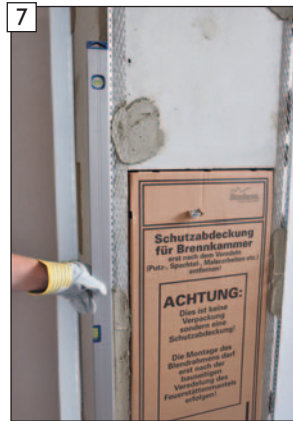
7 Eckprofile lotrecht ausrichten.
