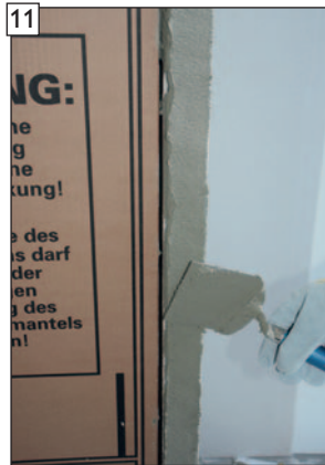
11 Haftbrückenauftrag zu den Öffnungen vornehmen, ...
