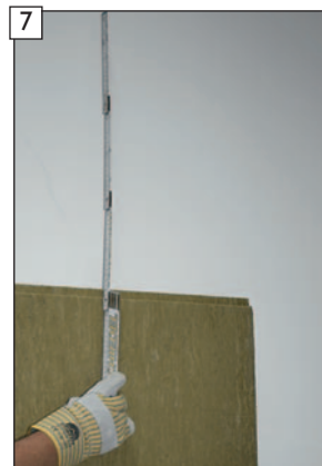
7 Differenzmaß zur bauseitigen Decke ermitteln.
