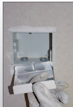
Abdeckung herausziehen. Weiter mit Montage des bauseitigen LEDA LUC Druckwächters.
