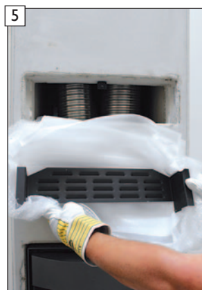
5 Sichtschutzblende auspa- cken. WICHTIG! Beschädigungen an der Sichtschutzblende/ Lackierung vermeiden!
