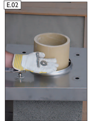
E.02 Montagereihenfolge: 1. Silikondichtungen 2. Edelstahl-Unterlegscheiben
