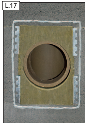
Ansicht des umlaufend vollständig geschlossenen Kleberauftrages.
