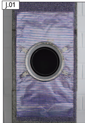
J.01 Ansicht Feuerstättenanschluss mit eingebautem Schiedel Edelstahl-Anschlussfutter:
