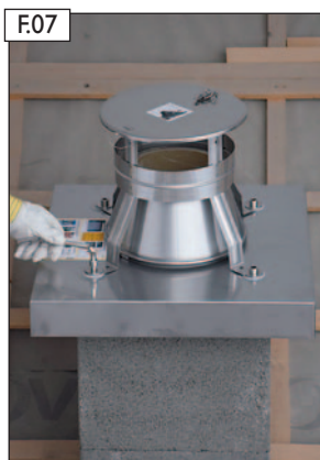
Regenhaube „EAGLE“ mit der Zuluftkopfplatte-Edelstahl verschrauben.
