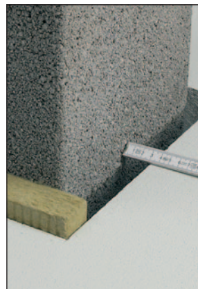
Montageausparung allseitig 3 cm größer als Mantelsteinmaß.
