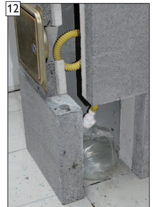
Fertigansicht am Beispiel: Ausführung mit geschlossenem Kondensatblendentürblatt und angeschlossenem Kondensatauffangbeutel.
