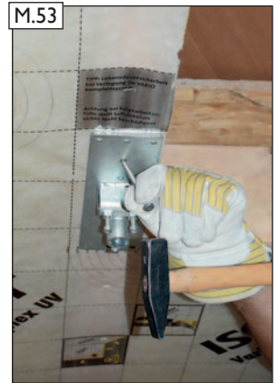
M.53 Sparrenhalter mit Kammnägeln (E) ausnageln.
