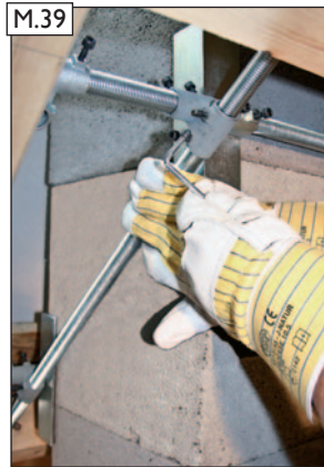
Zuerst Sparrenhalter und Spannwinkel (siehe Bild M.24 und M.25), danach Spannkreuz fixieren. Abreißschrauben anziehen bis Schraubkopf an der Sollbruchstelle abreißt.
