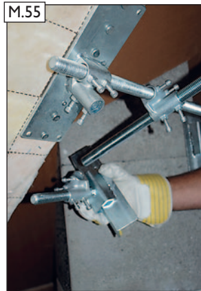
M.55 Gewindestange in Spannkreuze des oberen und unteren Schornsteinhalters einfädeln und dabei das Spannkreuz mit dem 45° Spannwinkel mit auffädeln.
