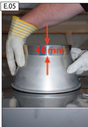
E.05 Konus nach unten bis ca. 2-3 mm auf Zuluftkopfplatte aufschieben. (Höhenausgleich bis 40 mm möglich)
