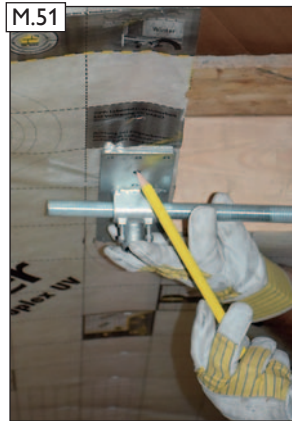
M.51 Aufgefädelt Einzelteile zum einrichten anhalten. Einbauposition für den Sparrenhalter markieren. Danach Einzelteile ausfädeln.
