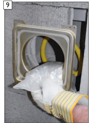
Siphonschlauch und Kondensatauffangbeutel in Schornsteinfuß einschieben.
