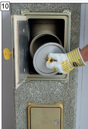
Putztür öffnen und Revisionsverschluss abnehmen. (Bild Darstellung am Beispiel ABSOLUT-Revisionsverschluss „B“)
