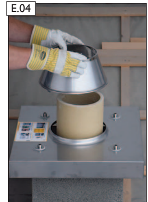
E.04 Konus aufstecken. WICHTIG! Oberkante Konus muss auf dem Keramikrohr aufliegen!
