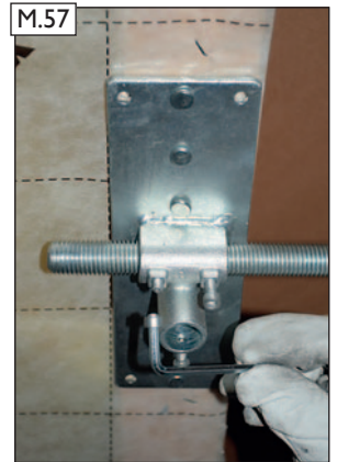
M.57 Gewindestange fixieren. Dazu die Abreißschrauben an beiden Sparrenhaltern mit Inbusschlüssel (F) anziehen bis der Schraubkopf an der Sollbruchstelle abreißt. Erst danach Spannwinkel fixieren (siehe Bild M.58).
