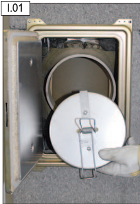
I.01 Revisionsverschluss „F“ für Festbrennstoffbelegung einsetzen.
