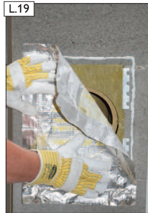
Spezial-Alugewebefolie innerhalb von 10 Minuten ausgerichtet ansetzen und ...
