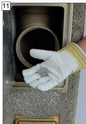
Grobfilter aus der Ablauföffnung im Kondensatteller herausnehmen und reinigen. WICHTIG! Rußablagerungen dabei ggf. vorher aus dem Kondensatteller entfernen!
