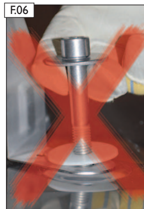
Alle Inbusschrauben der Zuluftkopfplatte-Edelstahl mit Silikondichtungen und Unterlegscheiben an der Abgaszugseite heraus-schrauben.
