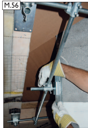
M.56 Spannwinkel ausrichten und vorfixieren.
