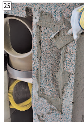
25 ... in der bisherigen Revisionstüröffnung dicht einkleben.
