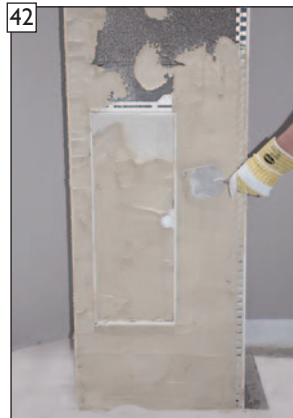
42 Anbringen des bauseitigen Unterputzes auf den Mantelsteinen und den Putzträger der Designtür.
