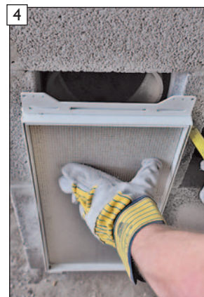
Erforderliches Öffnungsmaß (Breite) mit ausgemittelter Designtür an der freigelegten Öffnung festlegen und ...
