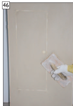
46 ... dabei die Schutzdichtung bündig freireiben.
