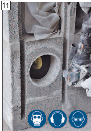
Öffnungsschnitt an der Innenseite der Nut nach unten umlaufend ...
