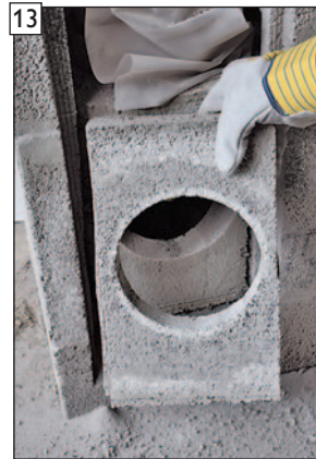
Mantelsteinscheibe entfernen und ...
