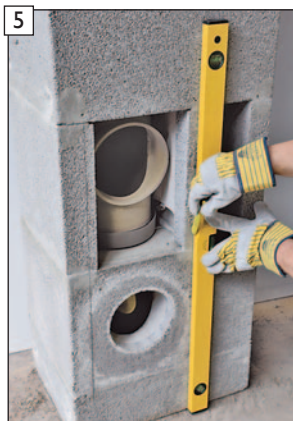
... mit Wasserwaage anzeichnen.
