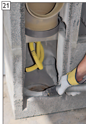
21 Mantelsteinöffnungen und Bohrungen reinigen.
