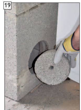
Der Bohrkern der ersten Kernbohrung wird später zum Verschluss des Außenmantels wieder benötigt.
