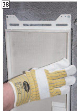
38 Schutzdichtung weiter einbringen und auf „planen“ Sitz achten.
