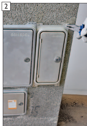
Bauseitige Reinigungs-, Kondensat- bzw. Revisionstür sowie evtl. Innendeckel vorsichtig entfernen.
