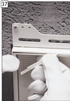
37 Detailansicht Bereich Türscharnier mit bauseits zurückgeschnittener Schutzdichtung im Bereich des Türscharniers.
