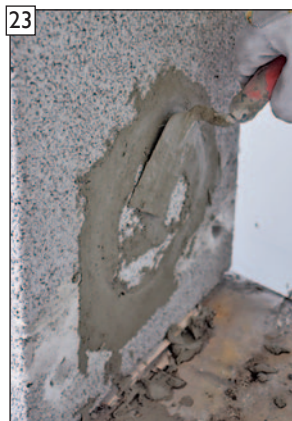
23 ... die äußere Mantelsteinscheibe dicht einkleben.
