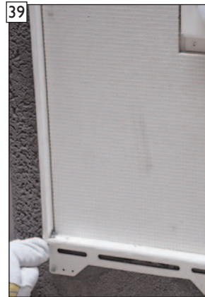
39 Ansicht unterer Türscharnierbereich mit bauseits zurückgeschnittener Schutzdichtung im Bereich des Türscharniers.
