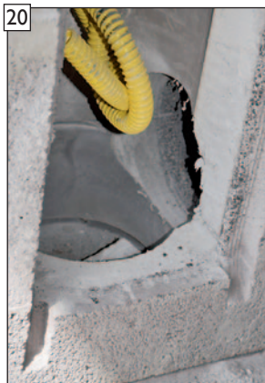
20 Jetzt die zweite Kernbohrung weiter durch die Mantelsteinzunge fortführen.
