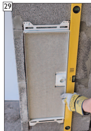
29 Ausrichtung mit Wasserwaage kontrollieren und ...
