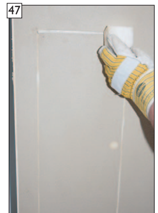
47 Schutzdichtung mit Schwamm nacharbeiten.
