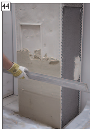
44 Bauseitigen Oberputz auftragen.
