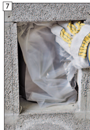
TIPPI! Bauseitigen Staubschutz an der Putztüröffnung des Keramikrohres anbringen.
