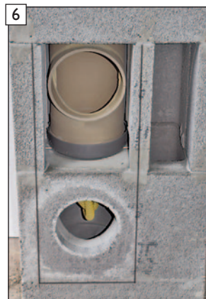
Ansicht der festgelegten Schnittführung für die erforderliche Designtüröffnung.
