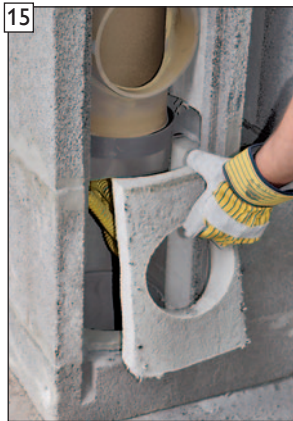
Schaumdämmung entfernen. (Ggf. Schnittflächen nacharbeiten)
