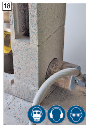
Erste Kernbohrung im Außenmantel herstellen.
