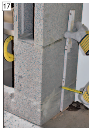
Position der Öffnungsbohrung festlegen.
