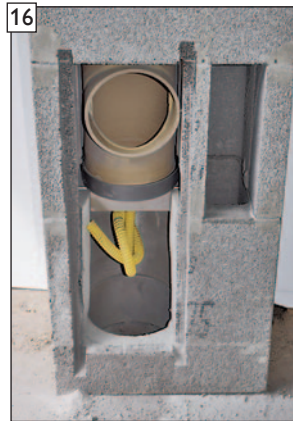
Fertigansicht Nutfräsung und Öffnungserweiterung.
