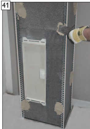
41 Anbringen der bauseitigen Putzschienen.
