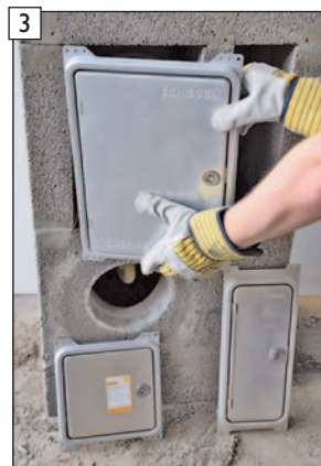
Bauseitige Reinigungs-, Kondensat- bzw. Revisionstür sowie evtl. Innendeckel vorsichtig entfernen.
