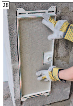
28 Designtür in die vorgeklebte Nutfräsung einsetzen.
