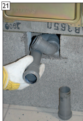
HT-Siphonteil eindrehen und auf Adapteranschluss des PA-Formstückes aufstecken.
