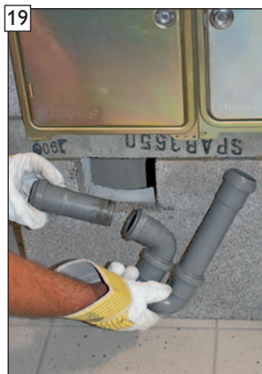
Vorderes HT-Rohrstück abziehen.
