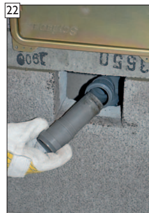
Vorderes HT-Rohrstück wieder in die untere HT-Einsteckmuffe einstecken.
