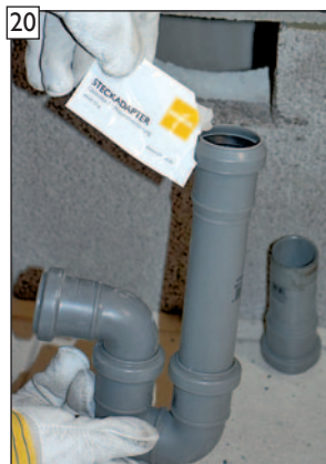
Gleitmittel in obere und untere HT-Einsteckmuffe einbringen.
