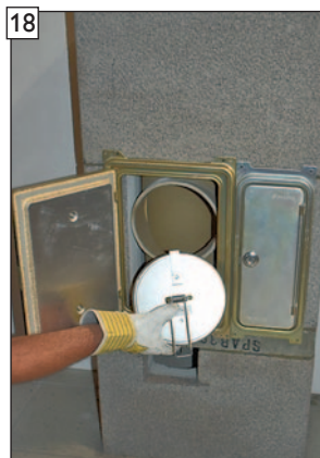
Revisionsverschluss einsetzen. (Bilddarstellung am Beispiel Revisionsverschluss „F“ für feste Brennstoffe)
