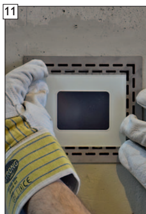
... in Displayblende bzw. der Bedien- und Messeinheit einrasten.
