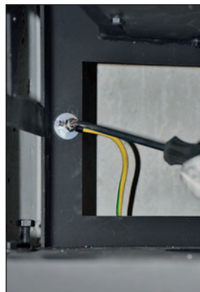
Potentialausgleichsleiter an Anschlussklemme anschließen.
