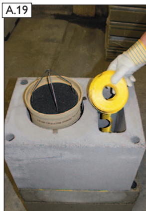
A.19 Zugseilrolle vorsichtig und verwicklungsfrei im Zuluftschacht ablegen.
