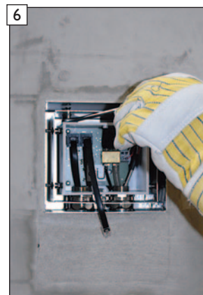
Vor der Montage des Blendrahmens kann das Gehäuse der Bedien-/Messeinheit bei Bedarf nachjustiert werden.
