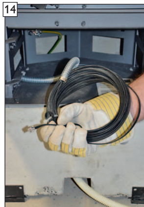
Die im LEDA LUC Grafikdisplay werkseitig vorinstallierte Datenbusleitung (Gesamtlänge 15 m zum LEDA LUC Grafikdisplay) befindet sich im Öffnungsbereich der Zuluftöffnung der Brennkammer.
