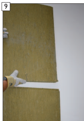
9 Obere Nutplatte in die Doppelfederplatte ein- stecken.
