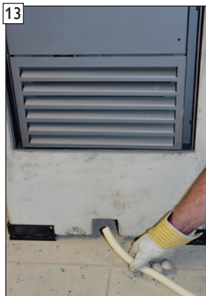
Verlegen der bauseitig erforderlichen Leerrohrverbindung vom KINGFIRE CLASSICO S zum bauseitigen Elektroschaltschrank/Kleinverteileranlage.
