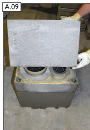
Ersten Mantelstein versetzen und ausrichten.
