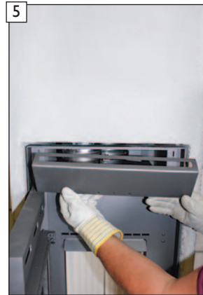
Blende der Zuluftregler leicht nach oben drücken und aushängen.
