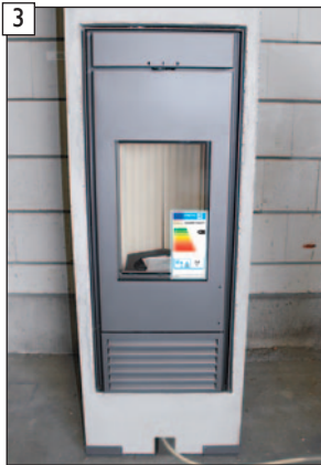
Ansicht vor Montagebeginn. HINWEIS! Die umlaufende freie Dehnfuge zum Feuerstättenmantel prüfen!
