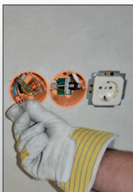
Klemmstelle für Flexkabel 230V
