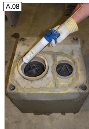
RAPID-fugendicht (7) auf ABSOLUT-Adapterring (12) auftragen.
