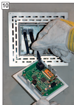
Displayeinheit an der Bedien- und Messeinheit anstecken und ...
