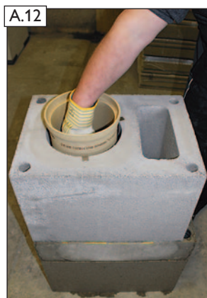
ABSOLUT-Profile Rohr (9) säubern.
