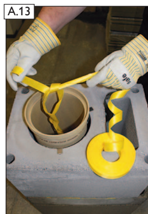
Äußeres Zugseilende mit dem unteren Schutzschwamm Abgas (1) sicher verknoten.
