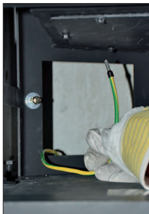
Bauseitiger Potentialausgleichsleiter „herausangeln“ und hinter der Geräterückseite zur Potentialausgleichsanschlussklemme führen.
