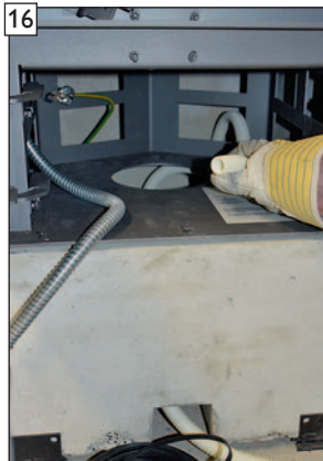
Bauseitiges Leerrohr von hinten durch die rückseitige Öffnung der Brennkammer einfädeln.
