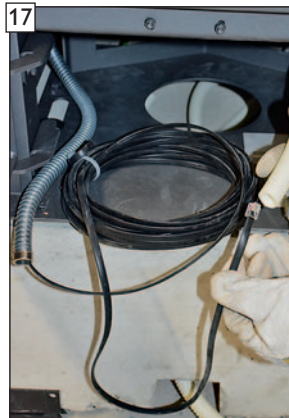
Datenbusleitung durch das bauseitige Leerrohr zum bauseitigen Elektroschrank/Kleinverteileranlage führen.
