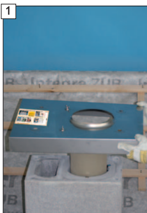
Zuluftkopfplatte-Edelstahl auflegen.
