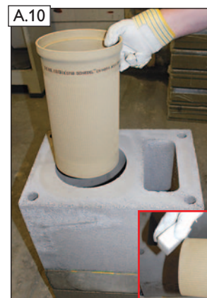
ABSOLUT-Profile Rohr (9) gem. der ABSOLUT-Versetzanleitung säubern und in Montagetrichter einsetzen.
