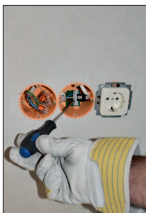
Klemmstelle für LEDA LUC Verbinder
