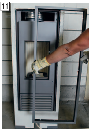
Blendrahmen einsetzen.
