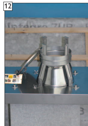
Der Revisionsdeckel ist mit einer Drahtschlinge, als „Absturzsicherung“, verbunden. Die Drahtschlauenfensicherung mind. einmal im Jahr überprüfen und ggf. erneuern.
