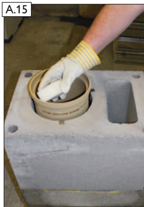
A.15 Muffenverbindung gem. der ABSOLUT-Versetzanleitung säubern.
