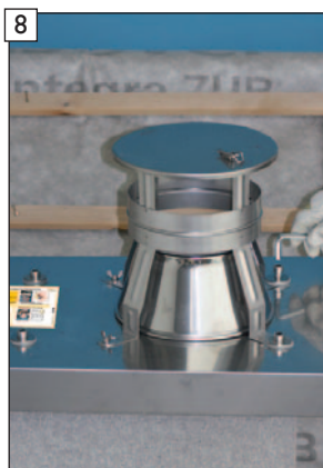
Regenhaube „EAGLE“ mit der Zuluftkopfplatte-Edelstahl verschrauben.
