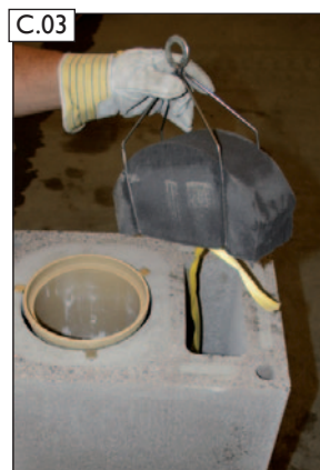
C.03 Oberen Schutzschwamm Zuluft (4) herausziehen.
