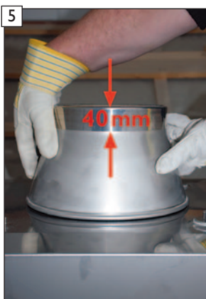
Konus bis ca. 2-3 mm auf Zuluftkopfplatte aufschieben.
