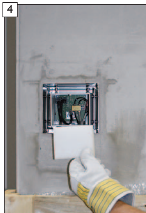
Schutzschwamm entfernen.
