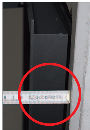
Vom fixen Überstand 30 mm bis auf 45 mm ausschiebbar.
