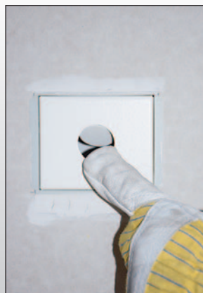
Perforiertes Eingriffsloch eindrücken.
