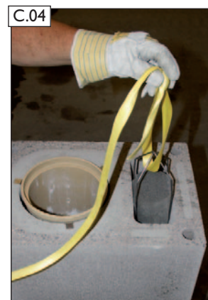
C.04 Mit dem Zugseil den unteren Schutzschwamm Zuluft (2) nach oben ziehen.
