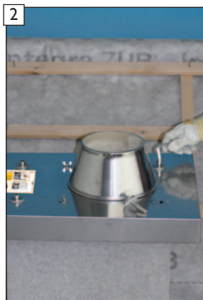
Beide Inbusschrauben der Zuluftkopfplatte-Edelstahl mit Silikondichtungen und Unterlegscheiben an der Abgaszugseite heraus-schrauben.
