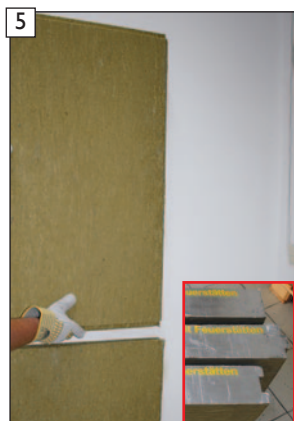
5 Doppelfederplatte in die Nutplatte einstecken und ...
