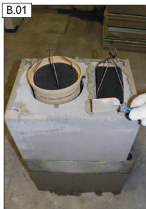
B.01 Dünnbettmörtel auftragen.
