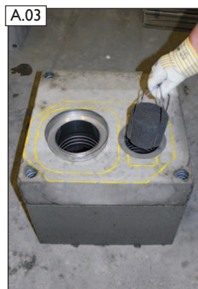
Unteren Schutzschwamm Zuluft (2) in Zuluftstutzen einstecken.
