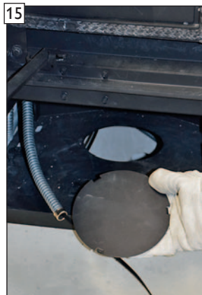
Revisionsdeckel am Gehäuseboden der Brennkammer herausnehmen.
