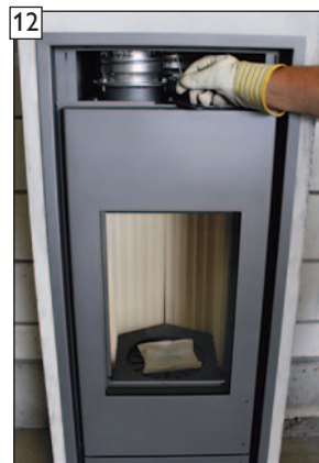
Blendrahmen bis zur bauseitigen Verkleidung aufschieben und Befestigungsschrauben umlaufend festziehen.
