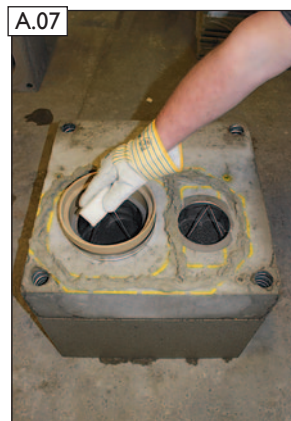
Muffenverbindung gem. der ABSOLUT-Versetzanleitung säubern.
