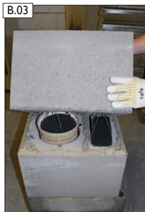
B.03 Mantelstein versetzen.
