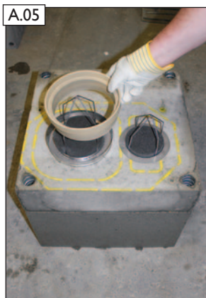
ABSOLUT-Adapterring (12) in Montagetrichter einlegen.
