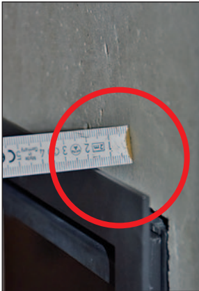
Vom fixen Überstand 0 mm bis auf 15 mm aus-schiebbar.
