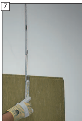
7 Differenzmaß zur bauseiti- gen Decke ermitteln.
