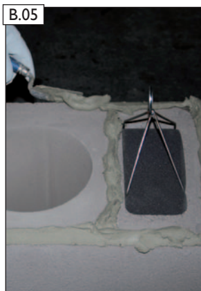
B.05 Dünnbettmörtel auftragen.
