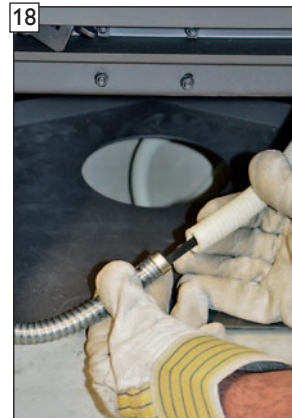
Übergang des werkseitigen Schutzschlauchs und des bauseitigen Leerrohrs bauseits verbinden und zugentlastet im Öffnungsbereich verlegen.
