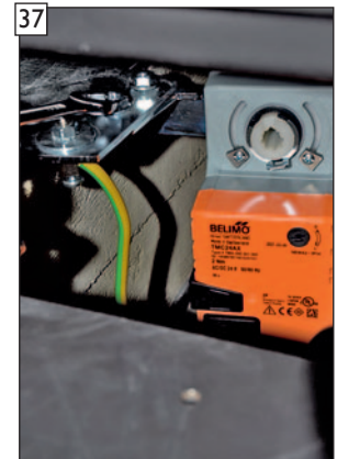
37 Stellmotorhalterung mit montiertem Stellmotor am Gleitlager befestigen.
