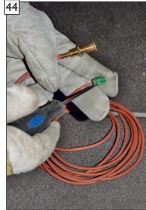
44 Anschlussstecker und Haltemutter zum Einfädeln am Verbindungskabel entfernen.
