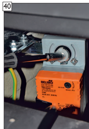
40 Stellmotorwelle von hinten in den Stellmotor einschieben und fixieren.
