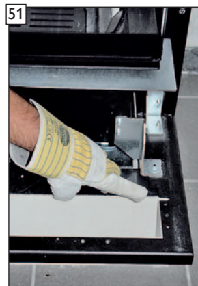
51 Montageposition für die Status-LED am Blendrahmen.
