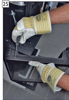
25 Neutrale Glashalteleiste montieren.
