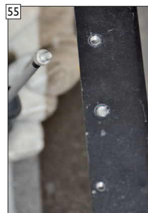
Befestigungsschrauben für den Haltewinkel der Steuereinheit von unten in den Blendrahmen 2 bis 3 Umdrehungen einschrauben.
