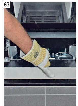
63 Montageposition für das Erdungskabel am Blendrahmen.
