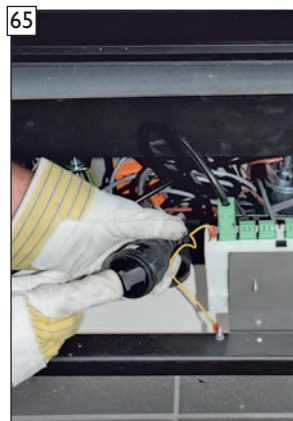
65 230V-Netzstecker der Steuerung mit der bauseitigen Steckdose verbinden.
