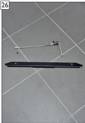
26 Der demontierte Stellhebel sowie die Glashalteleiste sind dem Bauherren dokumentiert zu übergeben und im Protokoll zu vermerken.
