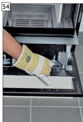
Montageposition für die Befestigungsschrauben am Blendrahmen.
