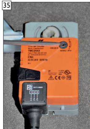
35 Drehrichtungsschalter auf „0“ stellen.
