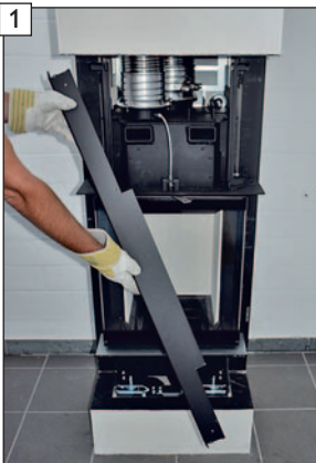
1 Frontverkleidung, Ofentisch und Blendenbauteile entfernen.
