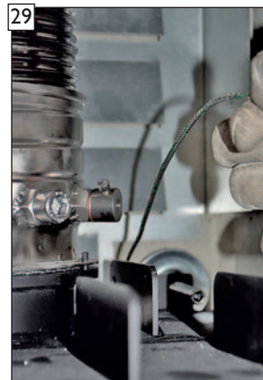
29 Anschlussklemme und Fühlerkabel hinter der Brennkammer nach unten fädeln.
