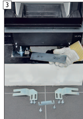
3 Klemmverbindung des Gleitlagers entfernen.
