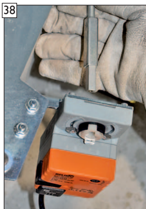
38 Einstecken der Stellmotorwelle in den Stellmotor. (Montageansicht zu Bild 40)
