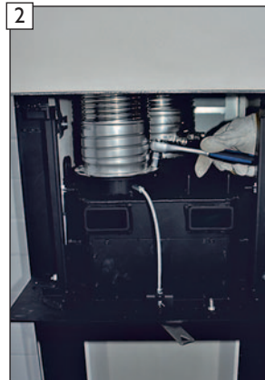
2 Zuluft- und Abgasadapter von der Brennkammer lösen.
