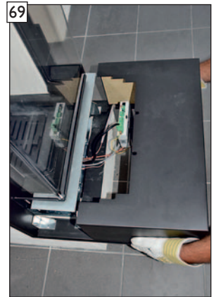
Abschlussarbeit - Montage des Ofentisches
