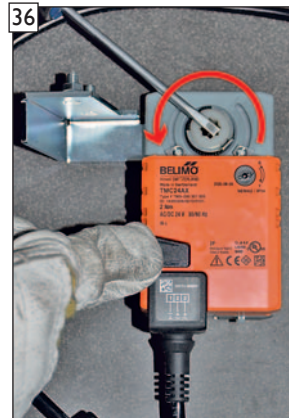
36 Freilaufaste gedrückt halten und die Aufnahme der Stellmotorwelle ganz nach links drehen.
