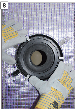
Äußeren Steckadapter mit Gleitmittel in Putzring einsetzen.
