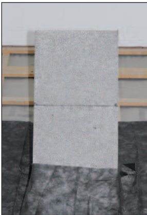
Ansicht vor Montagebeginn.
