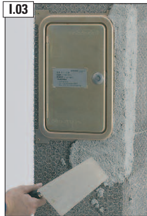
I.03 Putztür anputzen.
