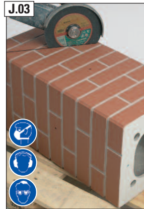
J.03 Mit Winkelschleifer zuschneiden. ACHTUNG! Beachten Sie bitte die Hinweise zum Arbeitsschutz auf Seite 2!
