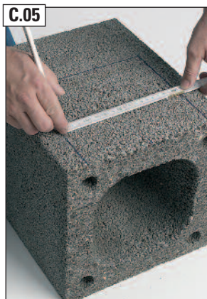
Öffnungsbreite am Mantelstein anzeichnen.
