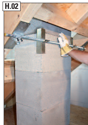
H.02 Aufgefädelte Einzelteile zum einrichten anhalten.
