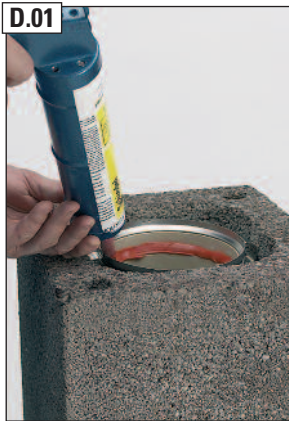
D.01 Schiedel ROTEMPO satt auf Profilrohr auftragen.
