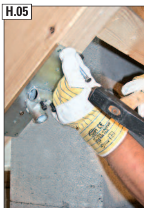
H.05 Sparrenhalter mit Kammnägeln (D) ausnageln.
