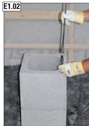
E1.02 Zweiten Gewindestab mit Doppelhülse kraftschlüssig verschrauben.
