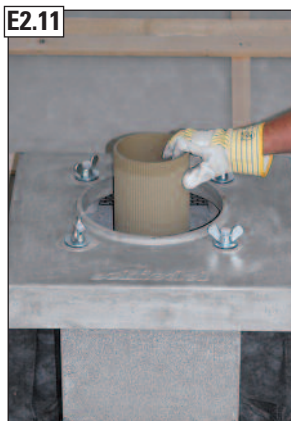
E2.11 Differenzrohr gem. der AVANT-Versetzanleitung zuschneiden und versetzen.
