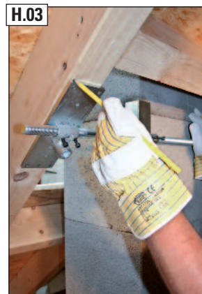
H.03 Einbauposition für den Sparrenhalter markieren. Danach Einzelteile ausfädeln.
