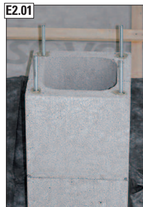
Die 4 Gewindestäbe 300mm in die obere Hülse des Bewehrungssets einschrauben.
