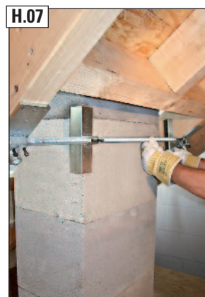
H.07 Spannwinkel an beiden Seiten ausrichten.
