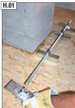
H.01 Ersten Schornsteinhalter vorbereiten. Spannwinkel und Sparrenhalter lose auf die Gewindestange auffädeln.
