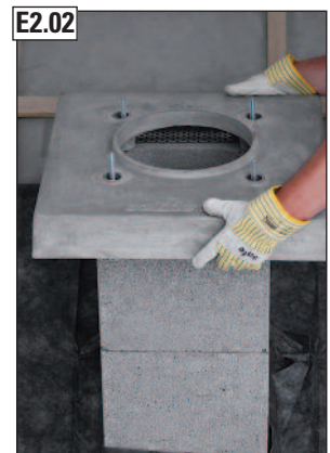
Zuluftkopfplatte aufsetzen.
