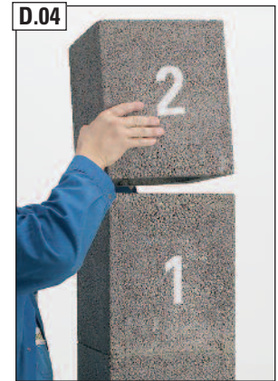
D.04 Zwei Mantelsteine versetzen.
