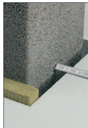
Deckenaussparung allseitig 3cm größer als Mantelsteinmaß.
