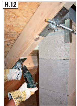
H.12 Sparrenhalter anhalten und Nagellöcher gemäß dem Nagelbild (siehe oben) vorbohren.
