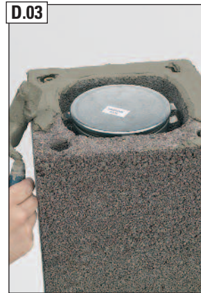
D.03 Dünnbettmörtel auftragen.
