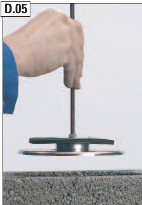
D.05 Fugenschutzdeckel mit Magnet am Fugenglätter abnehmen.
