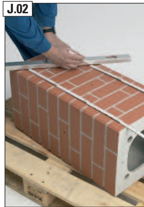
J.02 Maßübertragung auf den Stülpkopf.
