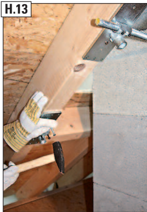
H.13 Sparrenhalter mit Kammnägeln (D) ausnageln.
