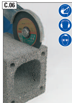
Mantelsteinöffnung mit Winkelschleifer herstellen.
