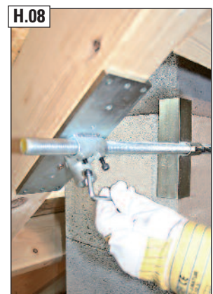
H.08 Gewindestange fixieren. Dazu die Abreißschrauben an beiden Sparrenhaltern mit Inbusschlüssel (E) anziehen bis der Schraubkopf an der Sollbruchstelle abreißt.
