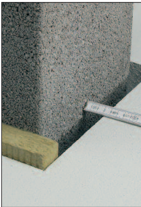
Deckenaussparung allseitig 3cm größer als Mantelsteinmaß.
