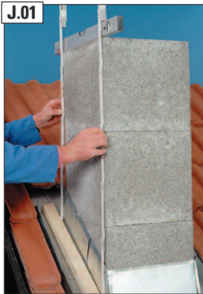
J.01 Ermittlung des Schrägschnittes.
