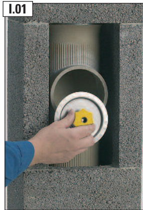
I.01 Revisionsverschluss einsetzen.
