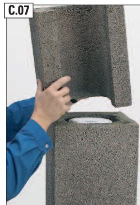
Öffnungsstein versetzen.
