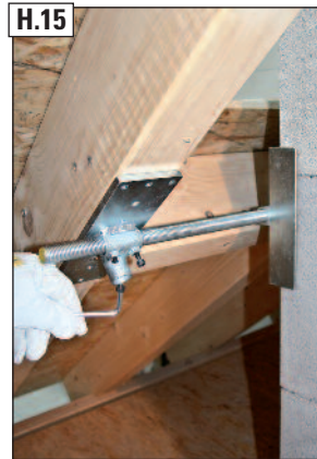
H.15 Gewindestange fixieren. Dazu die Abreißschrauben an beiden Sparrenhaltern mit Inbusschlüssel (E) anziehen bis der Schraubkopf an der Sollbruchstelle abreißt. Erst danach Spannwinkel fixieren (siehe Bild H.09).
