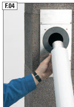
Dämmring einsetzen.
