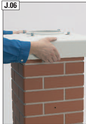
J.06 Zuluftkopfplatte aufsetzen und ...
