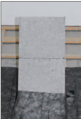
Ansicht vor Montagebeginn.
