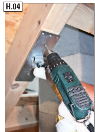
H.04 Sparrenhalter anhalten und Nagellöcher gemäß dem Nagelbild (siehe oben) vorbohren.
