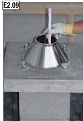
E2.09 Differenzmaß zum letzten Keramikrohr ermitteln.
