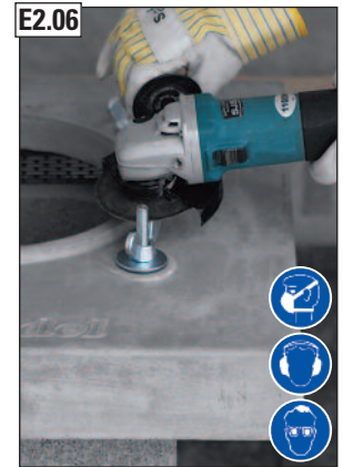
E2.06 Überstehende Gewindestäbe können entfernt werden.
