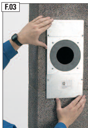
Steckadapter einsetzen. Schiedel Gleitmittel verwenden.
