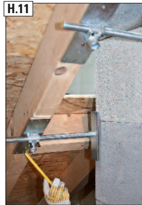
H.11 Aufgefädete Einzelteile zum einrichten anhalten. Einbauposition für den Sparrenhalter markieren. Danach Einzelteile ausfädeln.
