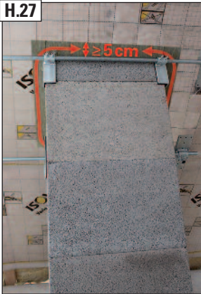
Fertigansicht mit ausgedämmtem Dachdurchgang gem. FeuVo der Länder.
