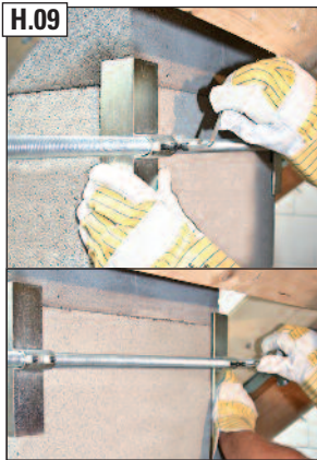
H.09 Spannwinkel an den Schornstein drücken. Abreißschrauben anziehen bis der Schraubkopf an der Sollbruchstelle abreißt.
