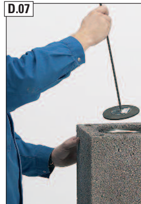
D.07 Profilrohrfuge mit Fugenglätter verstreichen.
