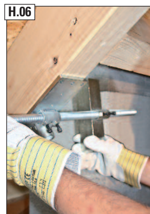
H.06 Gewindestange und Spannwinkel wieder einfädeln.
