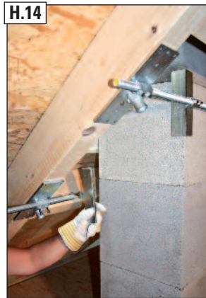
H.14 Gewindestange und Spannwinkel wieder einfädeln und ausrichten.
