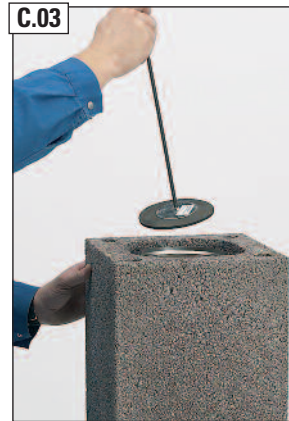
Profilrohr mit Fugenglätter verstreichen.
