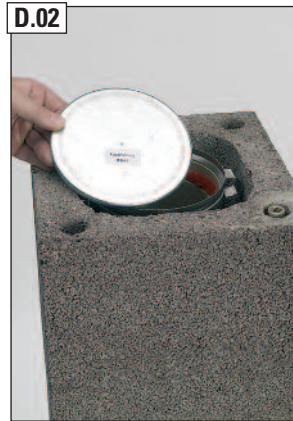
D.02 Fugenschutzdeckel auf Profilrohr auflegen.
