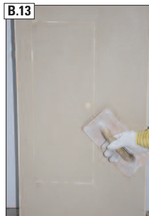
B.13 ... dabei die Schutzdichtung bündig freireiben.
