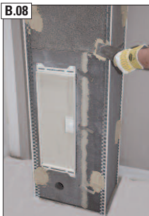
B.08 Anbringen der bauseitigen Putzschienen.
