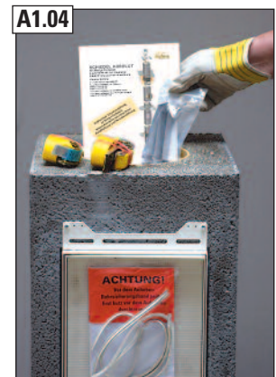
A1.04 Restliches Zubehör aus dem Fertigfuß entnehmen.
