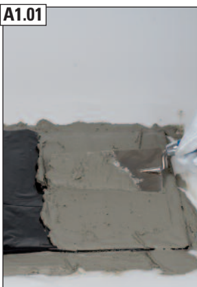
A1.01 Mörtelbett MG (M5) IIa (Mauermörtel nach EN 998-2) für Fertigfuß und Lüftungsmodul vorbereiten, Feuchtesperre einlegen, Mörtel auftragen.
