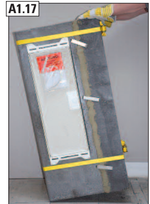
Der Fertigfuß kann nun sofort in vorbereitetes Mörtelbett versetzt werden.
