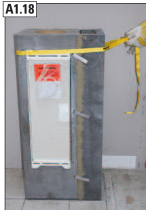
Spanngurte lösen. HINWEIS! Die Spanngurte werden im weiteren Versetzvorgang nicht mehr benötigt!
