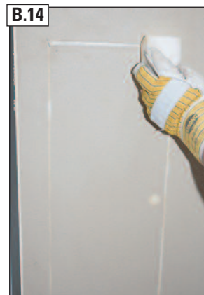
B.14 Schutzdichtung mit Schwamm nacharbeiten.
