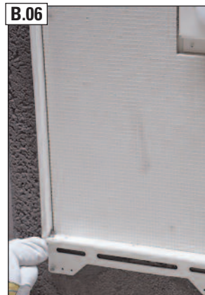
B.06 Ansicht unterer Türscharnierbereich mit bauseits zurückgeschnittener Schutzdichtung im Bereich des Türscharniers.
