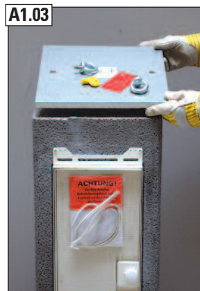
A1.03 Ringschrauben und Abdeckung entfernen.
