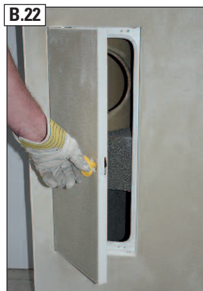
B.22 Funktionskontrolle! Überprüfen Sie die Schließung der BlowerDoor-Design-Fertigfußtür und entfernen Sie ggf. Putzreste an Türblatt und Zarge.
