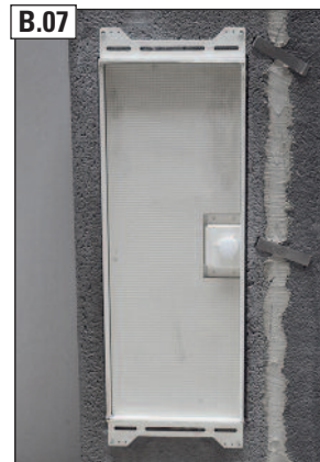
B.07 Fertigansicht mit vollständig eingebrachter Schutzdichtung.
