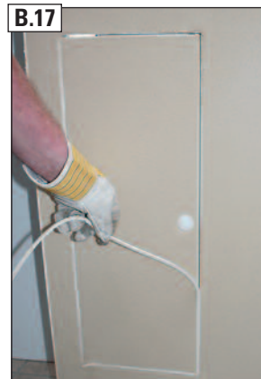
B.17 Schutzdichtung dabei immer vorsichtig und langsam herausziehen.
