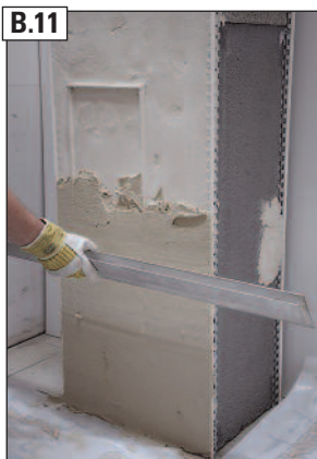
B.11 Bauseitigen Oberputz auftragen.
