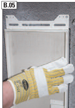
B.05 Schutzdichtung weiter einbringen und auf „planen“ Sitz achten.
