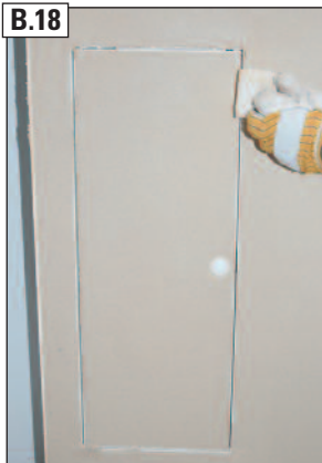
B.18 Putzkanten ggf. vorsichtig mit Schwamm nacharbeiten.
