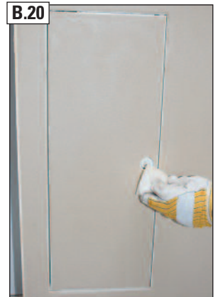
B.20 Putzkante zur Abdeckkappe ggf. mit Schwamm nacharbeiten.
