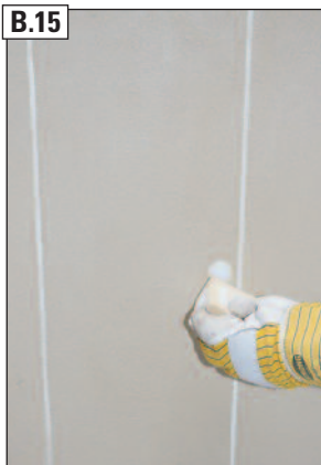
B.15 Ebenso die Abdeckkappe des Türverschlusses mit Schwamm nacharbeiten.
