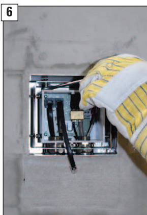
Vor der Montage des Blendrahmens kann das Gehäuse der Bedien-/Messeinheit bei Bedarf nachjustiert werden.
