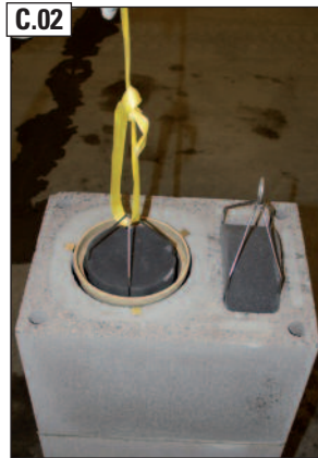
Mit dem Zugseil den unteren Schutzschwamm Abgas (1) nach oben ziehen.
