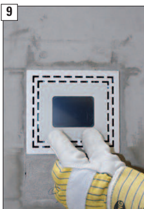
LUC-Grafikdisplay in der Steckverbindung des Gehäuses einrasten.
