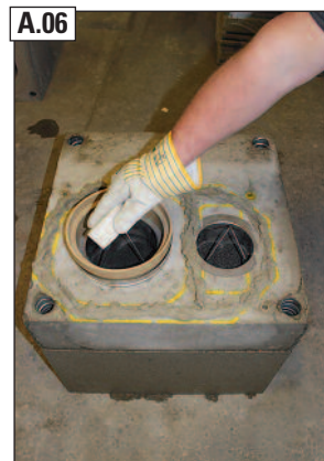
A.06 Muffenverbindung gem. der ABSOLUT-Versetzanleitung säubern.
