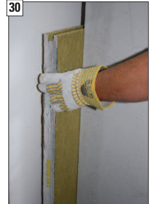
Untere Nutplatte des Spezial-KINGFIRE-Rückwanddämmsets hinter die Rückwand der Feuerstätte schieben.
