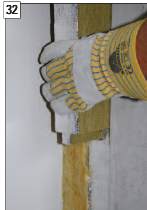
Doppelfederplatte in die Nutplatte einstecken.
