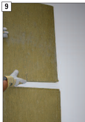
9 Obere Nutplatte in die Doppelfederplatte einstecken.
