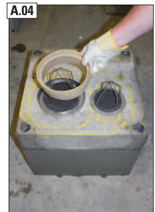
A.04 ABSOLUT-Adapterring (12) in Montagetrichter einlegen.
