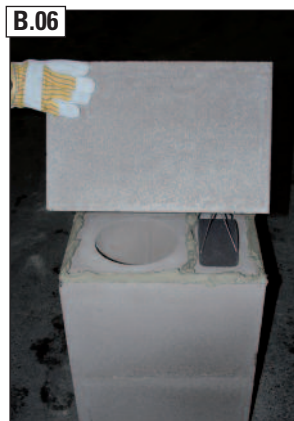
B.06 Den nächsten Mantelstein gem. des Versetzvorgangs ABSOLUT versetzen. (siehe auch ABSOLUT-Versetzanleitung)
