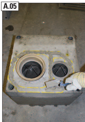
A.05 Dünnbettmörtel, innerhalb der Markierungen auf der Übergangsplatte, gem. der ABSOLUT-Versetzanleitung auftragen.
