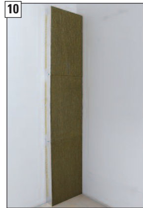
Ansicht vor Montagebeginn mit der eingebauten Spezial-KINGFIRE-Seitenwanddämmung gem. Bilder 1-9.
