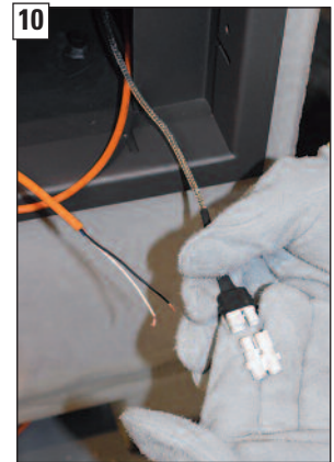
10 Anschlussklemme vom Fühlerkabel des Temperatursens- sors (A) abstecken und ...
