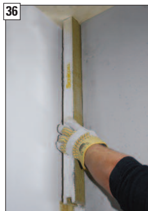
Obere Nutplatte in die Doppelfederplatte einstecken.
