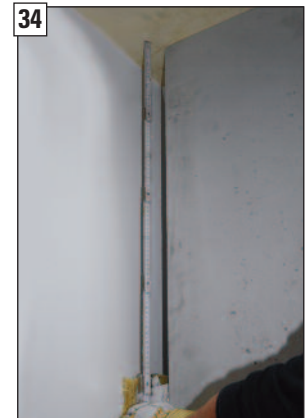
Differenzmaß zur bauseitigen Decke ermitteln.
