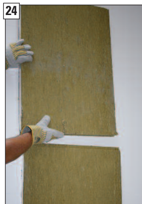
24 Obere Nutplatte in die Doppelfederplatte einstecken.
