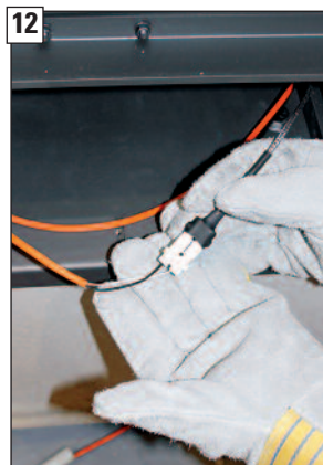
12 Steckverbindung zwi- schen der bauseitigen Zuleitung und dem Tem- peratursensor (A) her- stellen.
