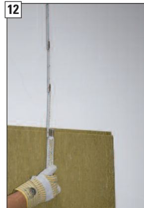
Differenzmaß zur bau-seitigen Decke ermitteln.
