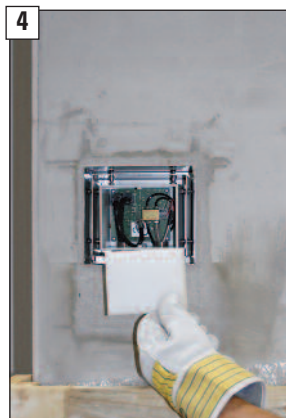
Schutzschwamm entfernen.
