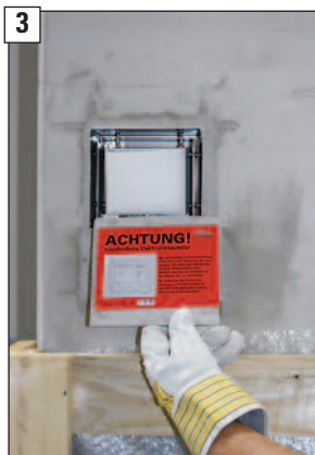
Innere Schutzabdeckung entfernen.
