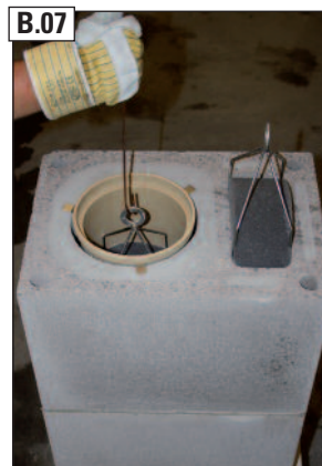
B.07 Nach dem Einbau des nächsten Keramikrohres wird der obere Schutzschwamm Abgas (3) mit Hilfe des Hakens (6) immer wieder bündig zur Muffe des versetzten Keramikrohres gezogen.
