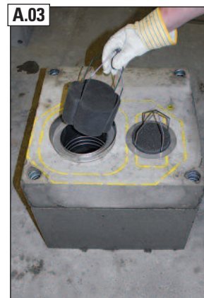
A.03 Unteren Schutzschwamm Abgas (1) in Montage-trichter einstecken.
