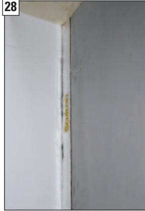
Fertigansicht zum Deckenanschluss.
