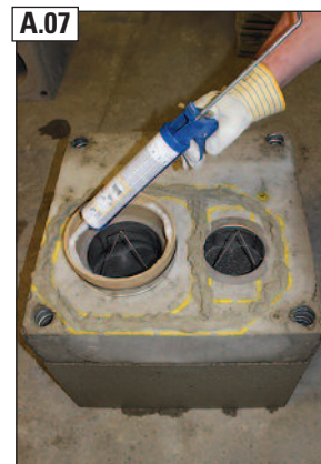
A.07 RAPID-fugendicht (7) auf ABSOLUT-Adapterring (12) auftragen.
