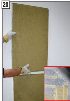
20 Doppelfederplatte in die Nutplatte einstecken und ...
