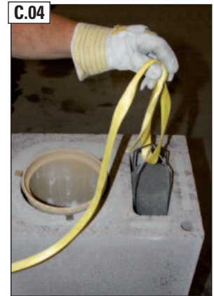
Mit dem Zugseil den unteren Schutzschwamm Zuluft (2) nach oben ziehen.
