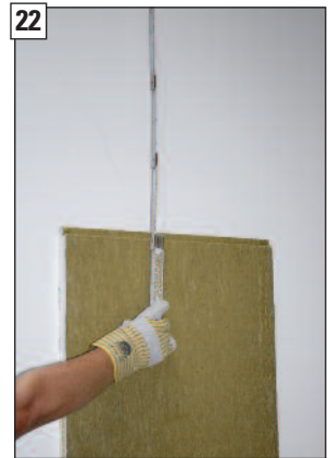
22 Differenzmaß zur bauseitigen Decke ermitteln.
