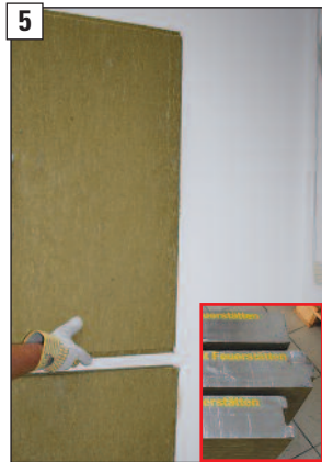
5 Doppelfederplatte in die Nutplatte einstecken und ...
