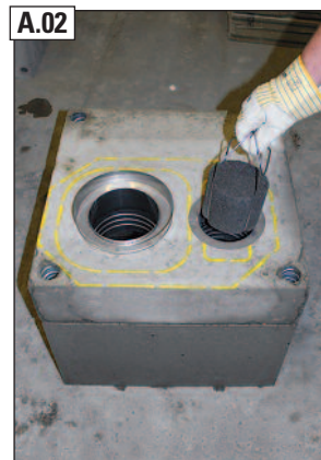
A.02 Unteren Schutzschwamm Zuluft (2) in Zuluftstutzen einstecken.
