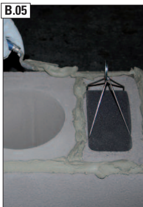
B.05 Dünnbettmörtel auftragen.
