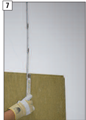
7 Differenzmaß zur bauseitigen Decke ermitteln.
