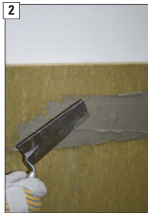
2 Spezial-KINGFIRE-Seitenwanddämmung kann wahlweise bauseitig an die Innenwand geklebt oder alternativ ...
