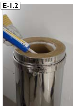
E-1.2 Schiedel RAPID-Fugenkitt auftragen. Auf geschlossene Fuge achten! Unterseite des nachfolgenden Rohrelements säubern.
