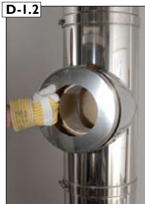
D-1.2 Bei Innenmontage ist eine Anschlussabdeckung zu montieren.
