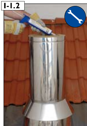
I-1.2 Nutbereich des keramischen Rohres mit leicht feuchtem Schwamm säubern. Schiedel-RAPID auftragen. Auf geschlossene Fuge achten.
