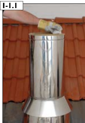
I-1.1 Klemmband vom letzten Rohrelement entfernen. Es wird nicht mehr benötigt.
