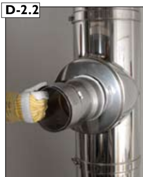
D-2.2 Variante mit Anschlussübergang: ausgewählten Anschlussübergang in den Keramikstutzen mit leichter Drehbewegung einbauen und die Verbindungsleitung vorne in das Doppelwandfutter einführen.
