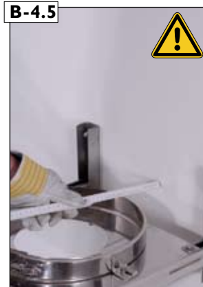
Exakten Wandabstand ermitteln. Den Mindestabstand von 5 cm anhand eines Wandhalters festlegen. ACHTUNG: Abstand zu brennbaren Bauteilen mind. 5 cm!
