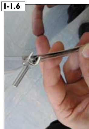
I-1.6 „Befestigungsklemme für Regenhaube“ am Rohrelement unterhalb des Mündungsabschlusses anbringen.
