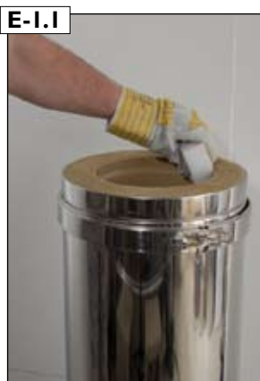
E-1.1 Klemmband am Rohrelement öffnen und zur Montage leicht nach unten schieben. Rohraufstandsfläche mit leicht feuchtem Schwamm säubern.
