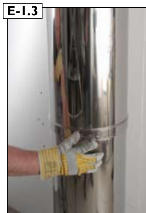
E-1.3 Rohrelement versetzen. Klemmband am Rohrelement über die Sicke der Stoßverbindung schließen und kraftschlüssig verschrauben.
