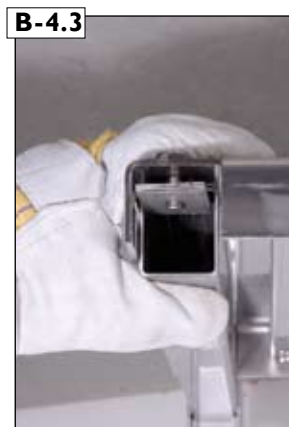
Schutzkappen zur weiteren Montage abziehen und Gewindeplatten in Wandkonsole einschieben. Vorerst nur leicht verschrauben!
