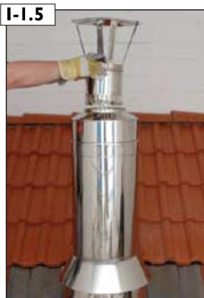
I-1.5 Regenhaube-Montage (bei Bedarf): „Regenhaube“ bis zur Anschlagssicke einschieben.
