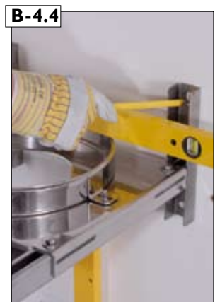
Bohrlöcher markieren und herstellen. Auf waagrechte Ausrichtung achten und gemäß nachstehendem Hinweis auf die massive Wand montieren.
