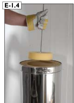
E-1.4 Schiedel RAPID-Fugenkittreste mit Verstreichergerät abstreifen.
