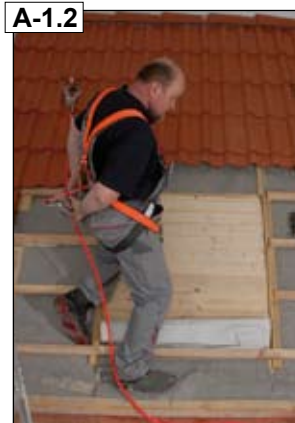
Vor Montagebeginn Gerüst aufstellen und Sicherungsmaßnahmen zur Montage treffen. Unfallvorschriften beachten!
