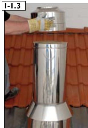
I-1.3 Keramische Unterseite des „Mündungsabschlusses“ säubern und versetzen. Befestigung des Mündungsabschlusses erfolgt ohne Klemmband.
