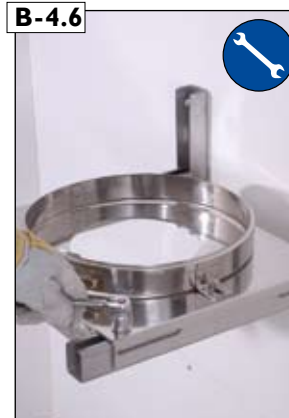
Wandkonsole nun kraftschlüssig mit der Montageschiene verschrauben und keramische Kondensatschale einlegen.
