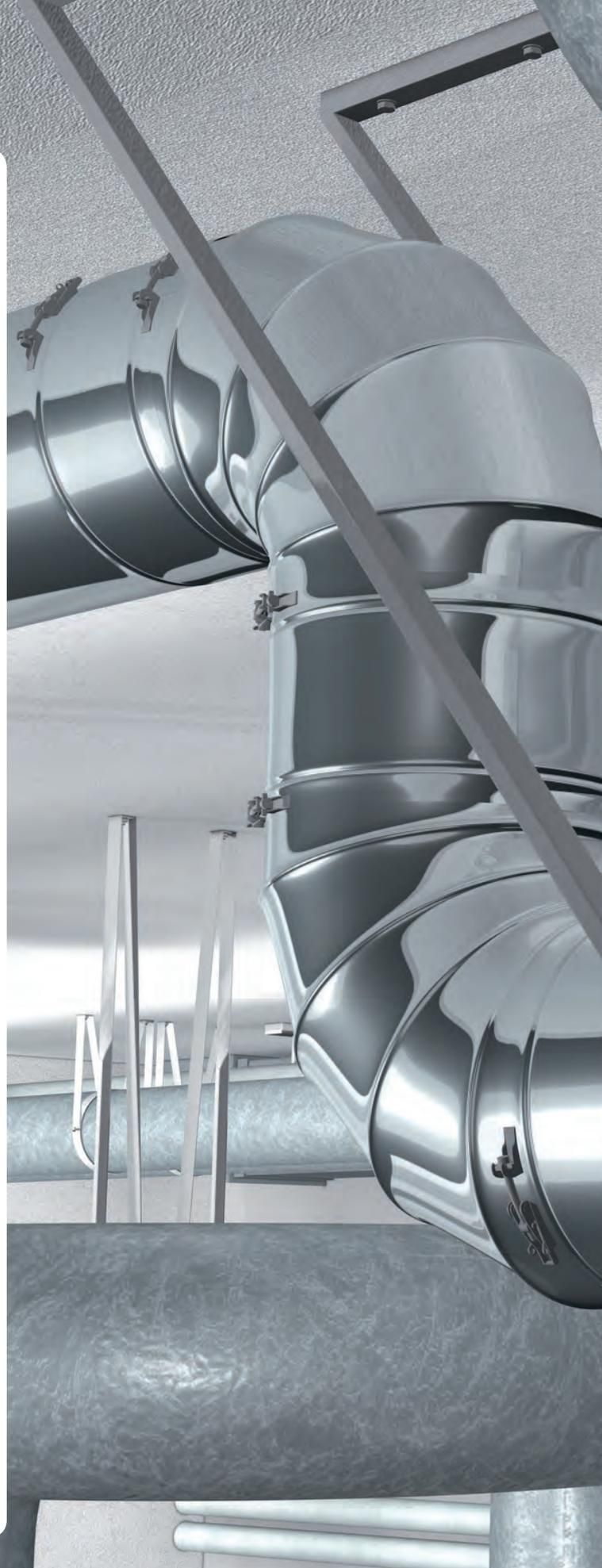
Die Ausdehnung des Abgassystems wird durch Kompensatoren im Bereich von Umlenkungen oder Abstützungen ermöglicht. Vor der 90° Umlenkung wird ein Kompensator und eine Stützplatte montiert. Die Stützplatte wird fixiert, damit der Kompensator die Ausdehnung aufnimmt. Der Kompensator wird durch einen justierbaren Außenmantel abgedeckt.
