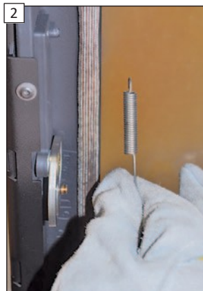
2 Demontujte poškozenou pružinu zavírače dveří.
