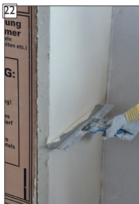
22 V případě potřeby povrch dodatečně opracujte špachtlí.
