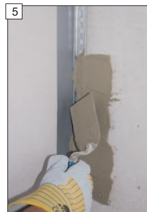
Na spojovací profily naneste a vyrovnejte adhézní můstek „Baumit multiContact MC 55 W“.
