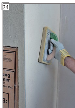
24 V případě potřeby povrch následně zahladit.
