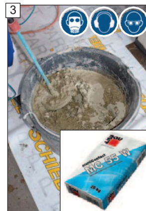
Připravte adhézní můstek „Baumit multiContact MC 55 W“ podle pokynů výrobce. POZOR! Dodržujte bezpečnostní pokyny na straně 2!
