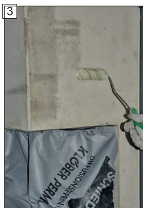
3 Předčištění betonu pláště vodou, aby se prach zpevnil (např. pomocí malířského válečku).
