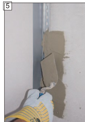
Na spojovací profily naneste a vyrovnejte adhezivní můstek „maxit multi 280“.
