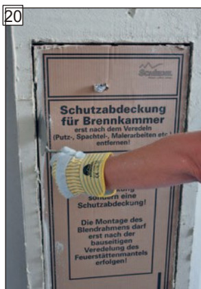
20 Odřízněte vrchní omítku v okolí otvorů.
