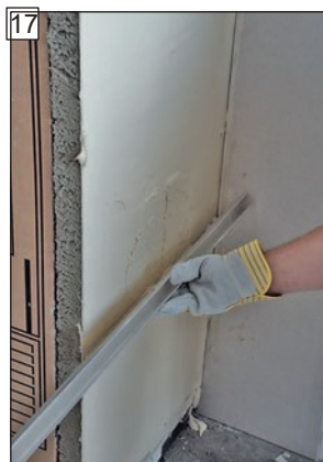
17 ... vyrovnejte stahovací latí.
