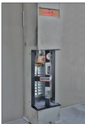
Pohled před zahájením montáže - Příklad obkladu s KINGFIRE GRANDE SC
