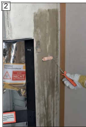
Naneste základní nátěr Sopro GD 749 na betonový plášť.
