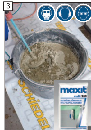
Připravte adhezivní můstek „maxit multi 280“ podle pokynů výrobce. POZOR! Dodržujte bezpečnostní pokyny na straně 2!
