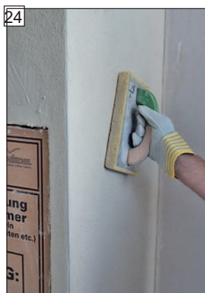
24 V případě potřeby povrch následně zplstnatit.
