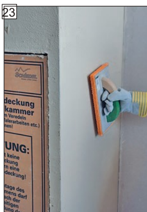
23 Povrch obrousit nebo strukturovat.
