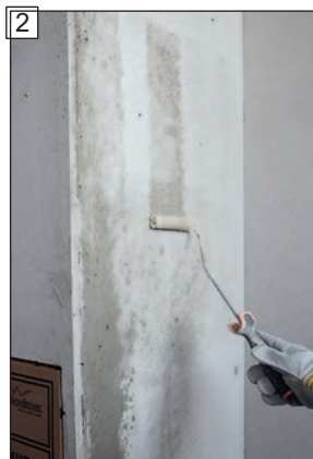
Předběžné očištění betonového pláště vodou za účelem vázání prachu (např. pomocí malířského válečku).
