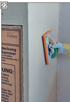
Povrch obrousit nebo strukturovat.
