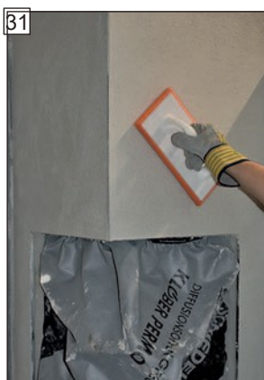
31 Povrch zbrusit nebo strukturovat.
