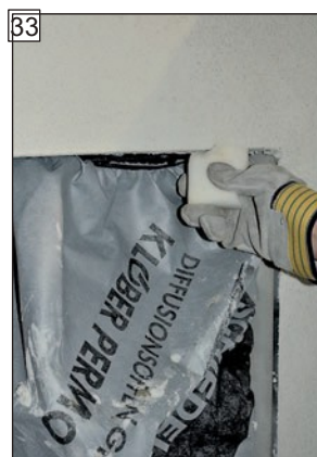
33 Spojovací profily čistit ještě ve vlhkém stavu.
