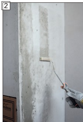
Předběžné očištění betonového pláště pro navázání prachu (např. pomocí malířského válečku).
