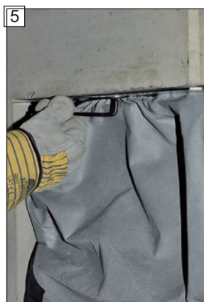
5 ... levý upevňovací šroub na horním omítkovém úhelníku povolte o 2–3 otáčky.
