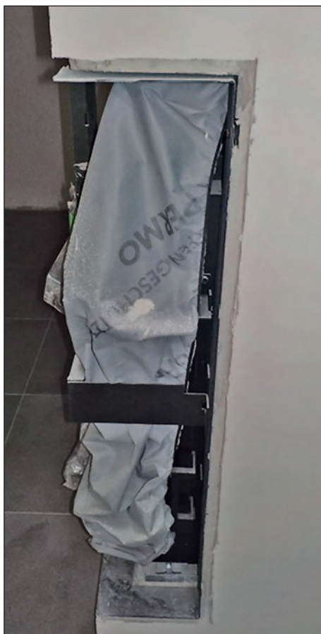
Pohled po provedení obvodového výřezu na straně stavitele
