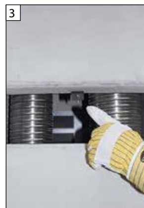
Pohled zblízka na přídržný úhelník spolu s továrně přišroubovaným zajišťovacím šroubem pro mřížku konvekčního vzduchu.
