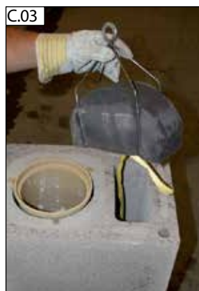
C.03 Vytáhněte horní díl (3) přívodu vzduchu ze šachty.
