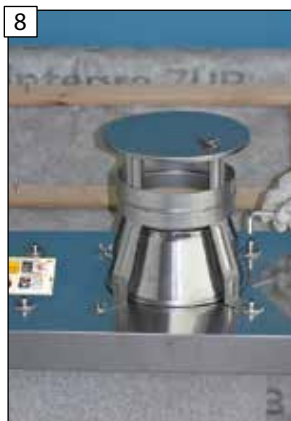
8 Utáhněte šrouby pro pevné upevnění krycí hlavy "EAGLE".
