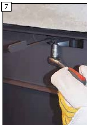
7 Pevně přišroubujte ovládací prvek.
