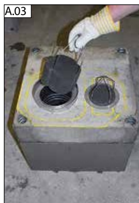
Zasuňte spodní díl (2) pro odvod spalin do průduchu.
