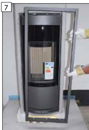
Nastavte montážní rám. POZOR! Podle polohy upevňovacích šroubů vytvořte správnou polohu pro montáž!
