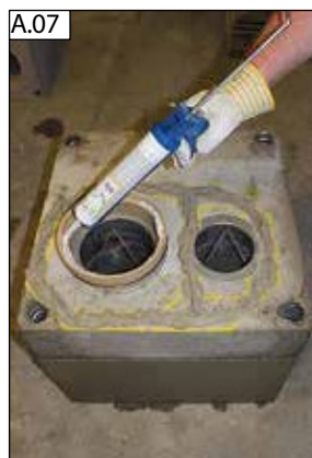
Na adaptér (12) naneste těsnicí hmotu RAPID (7).
