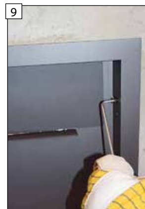
Krycí rám po přiložení na obklad realizovaný na stavbě dotažením šroubů pevně zafixujte.
