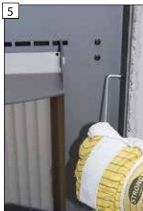
Pomocí inbusového klíče zcela vyšroubujte všechny upevňovací šrouby na rámu topeniště.
