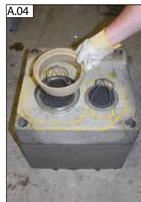
Zasuňte adaptér (12) do průduchu.
