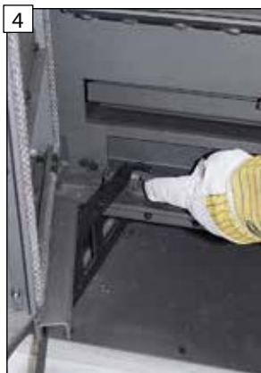
Aretace dvířek topeniště. Zajišťuje, že dvířka jsou trvale otevřená za účelem čištění spalovací komory.
