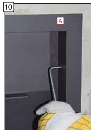
10 Poté pevně upevněte prodlužovací krycí rám (A).
