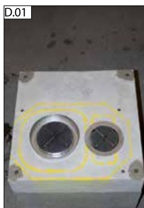
D.01 Pohled na skutečný stav před zahájením instalace.
