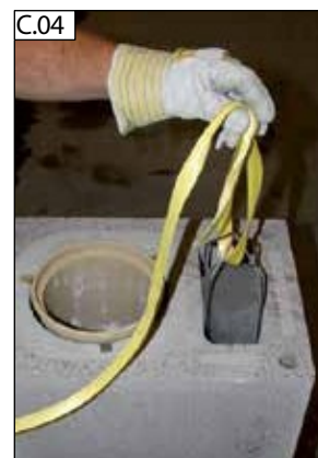
C.04 Pomocí lanka vytáhněte spodní část přívodu vzduchu (2) ze šachty
