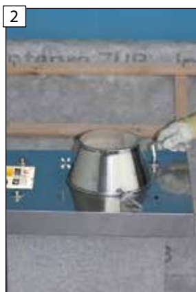
Vyšroubujte upevňovací šrouby krycí desky.
