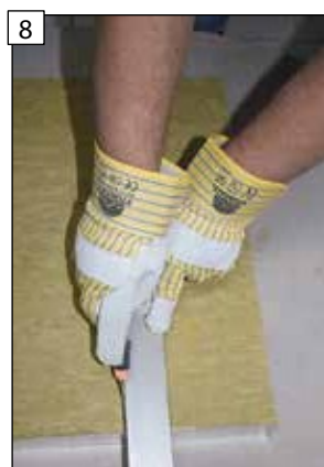
8 Horní desku odpovídajícím způsobem zkratíte. POZOR! Dbejte na rovný řez!
