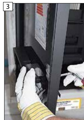
3 Namontujte zkrácenou verzi rukojeti B pomocí E a F.
