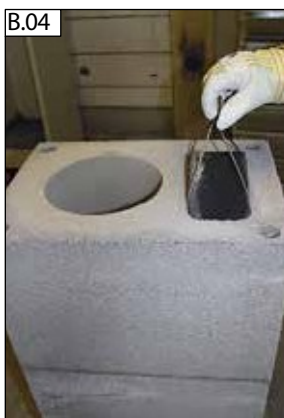
S každou další namontovanou tvárnici je nyní NUTNÉ povytáhnout vrchní díl pro přívod vzduchu (4) ještě před nanesením tenkovrstvé malty.
