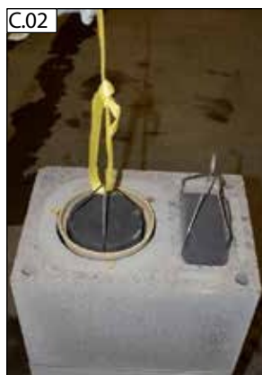
C.02 Pomocí lanka vytáhněte spodní část odvodu spalin (1) z průřechu.
