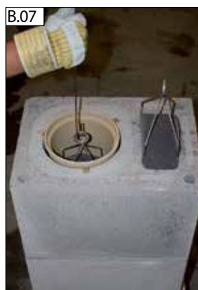
Po osazení další keramické profilované vložky povytáhněte pomocí háku (6) horní část pro odvod spalin (3).
