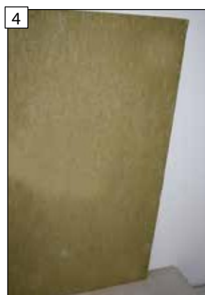
4 Dolní desku s drážkou speciální KINGFIRE izolační sady boční stěny upevníte na vnitřní stěnu.
