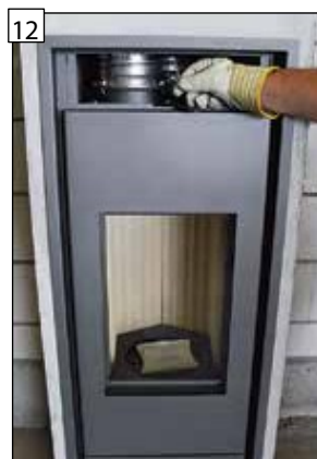
12 Osazovací rám nasuňte až k dokončenému opláštění a pevně utáhněte upevňovací šrouby po celém obvodu.
