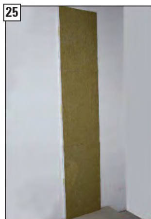
Pohled na hotový stav před montáží modulu KINGFIRE.
