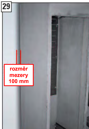
Pohled na stav před zahájením montáže. Příklad s rozměrem volné mezery 100 mm.
