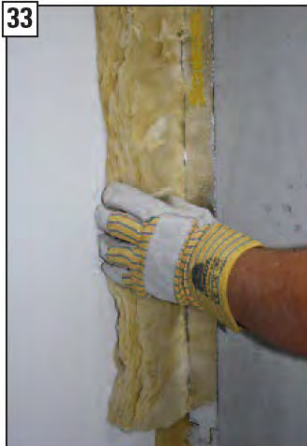
Doplňkovou izolaci zabudujte mezi zde umístěnou desku s dvojitým perem a vnitřní stěnu.
