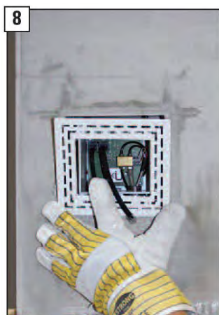
Na pouzdro řídicí jednotky nasadte clonu s přídržnými svorkami.
