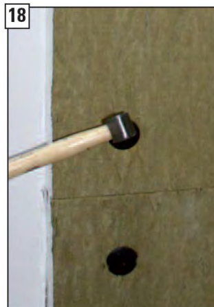
... upevnit s použitím hřebíků vhodných pro izolační hmotu.
