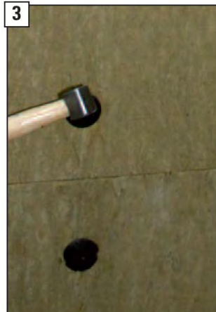
3 ... upevnit s použitím hřebíků vhodných pro izolační hmotu.
