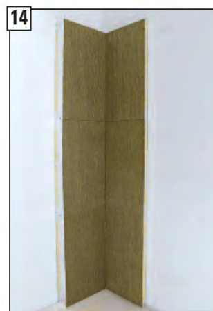
Pohled na hotový stav kombinace.
