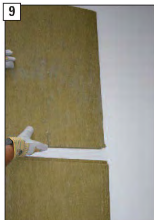
9 Horní desku s drážkou osadte do desky s dvojitým perem.
