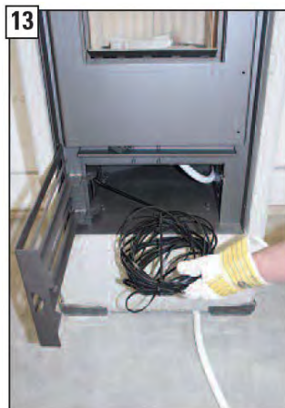
V oblasti otvoru pro přivádění vzduch do spalovacího prostoru se nachází vedení datové sběrnice k displeji LUC (celková délka 15 m), připravené z výroby.
