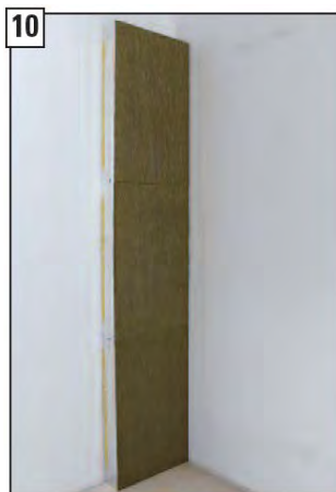
Pohled na stav před zahájením montáže, se zabudovanou speciální KINGFIRE izolační sadou boční stěny, podle obrázků 1 až 9.
