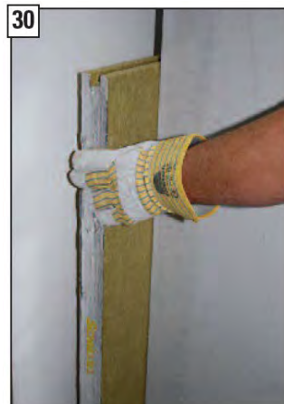
Zasunutí dolní desky s drážkou speciální KINGFIRE izolační sady zadní stěny za zadní stěnu modulu.
