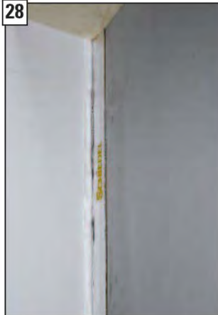
Pohled na hotový stav u připojení ke stropu.
