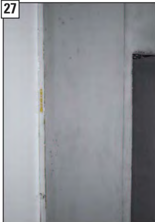
Pohled na hotový stav zadní strany.
