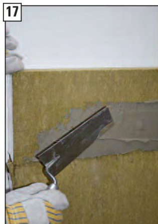
Speciální KINGFIRE izolační sada zadní stěny se může volitelně na vnitřní stěnu nebo příčku nalepit nebo alternativně...
