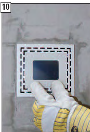
Grafický displej zařízení LUC zaklapněte do pouzdra.
