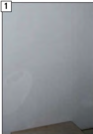
1 Pohled na stav před zahájením montáže.
