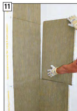
Speciální KINGFIRE izolační sadu zadní stěny osadte bez mezer.
