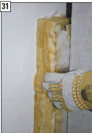
Doplňkovou tepelnou izolaci zabudujte mezi zde umístěnou dolní desku s drážkou a vnitřní stěnu.
