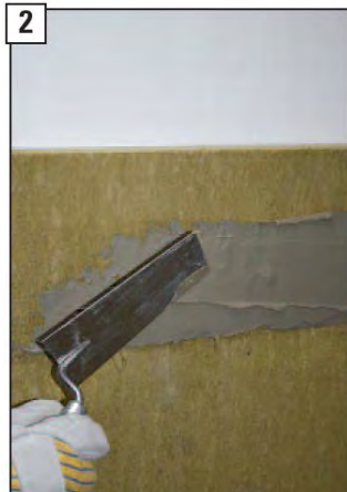
2 Speciální KINGFIRE izolační sada boční stěny se může volitelně na vnitřní stěnu nebo příčku nalepit nebo alternativně...
