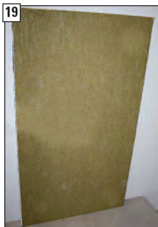
Dolní desku s drážkou speciální KINGFIRE izolační sady zadní stěny upevněte na vnitřní stěnu.
