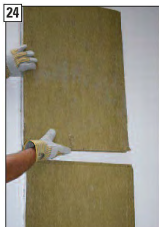
Horní desku s drážkou osadíte do desky s dvojitým perem.
