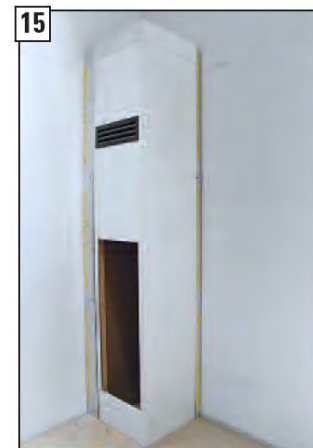
Pohled na hotový stav ve fázi hrubé stavby.
