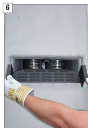
6 Pohledovou clonu nastavte do šikmé polohy a vsuňte ji do otvoru konvekčního vzduchu. Potom ji posuňte směrem dolů až k dorazu.
