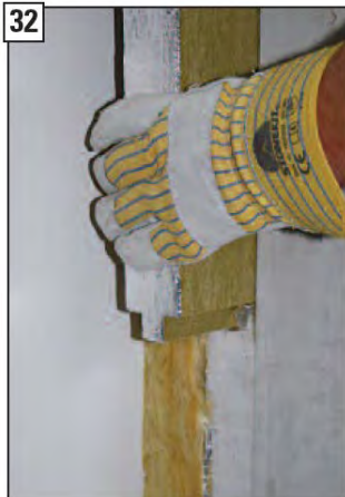
Desku s dvojitým perem osadíte do desky s drážkou.
